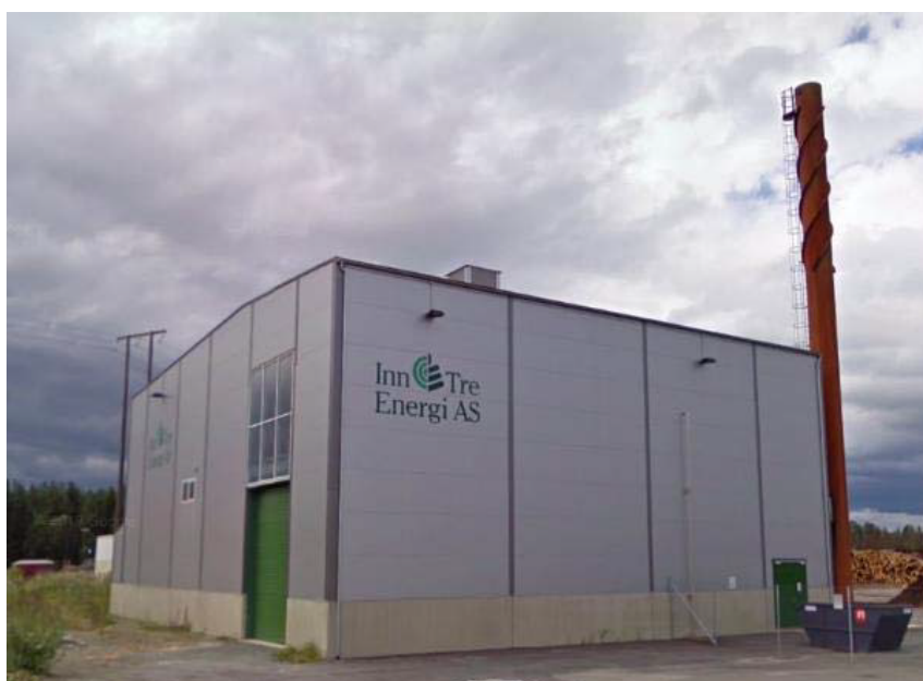
Figur 2. Eksisterende varmesentral før installeringen av 280 m 3 akkumulatortank.
