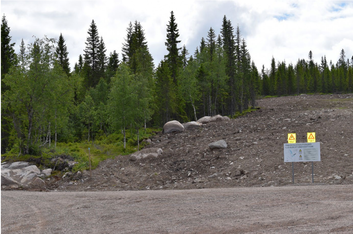
Figur 81. Massetak ved avkjøring til T10, østside med infoskilt for Finnskogleden.
