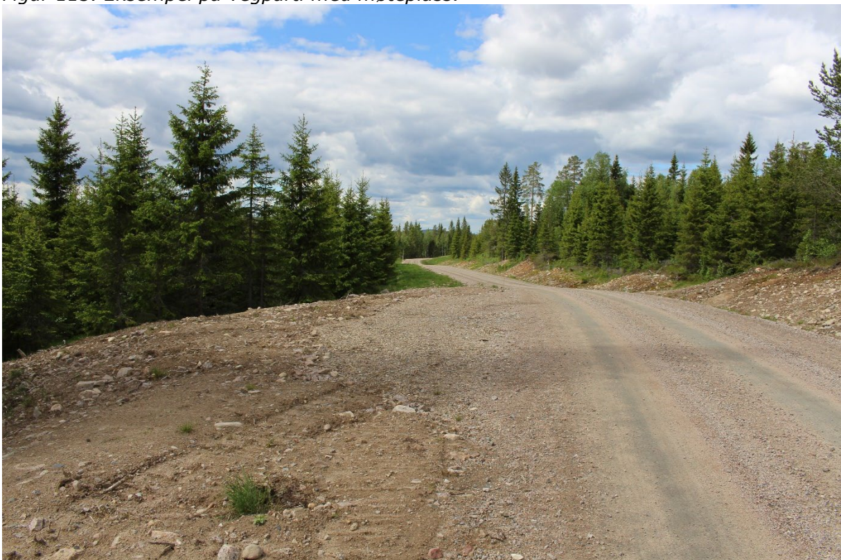
Figur 116. Eksempel på møteplass som er tilpasset driftsfase ved at den er redusert i størrelse.
