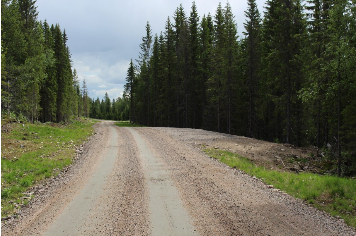
Figur 117. Eksempel på møteplass som er tilpasset driftsfase ved at den er redusert i størrelse.
