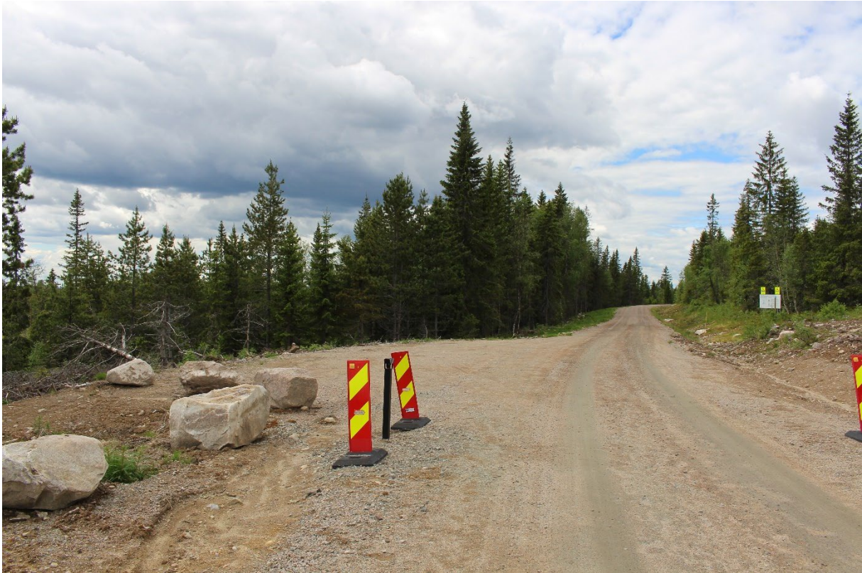
Figur 121. Foran bommen ved serviceområdet er det etablert en kombinert snuplass og parkeringslomme.
