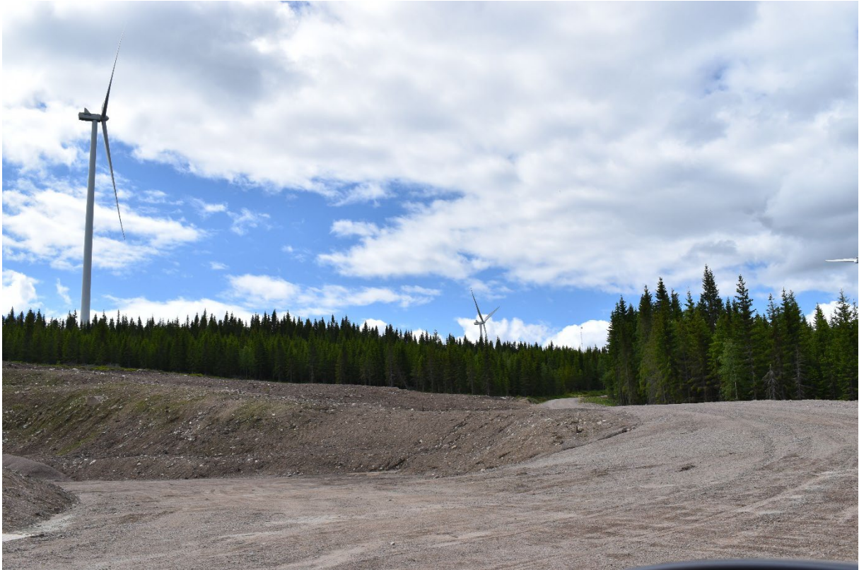
Figur 83. Massetak ved avkjøring til T10, vestside,
