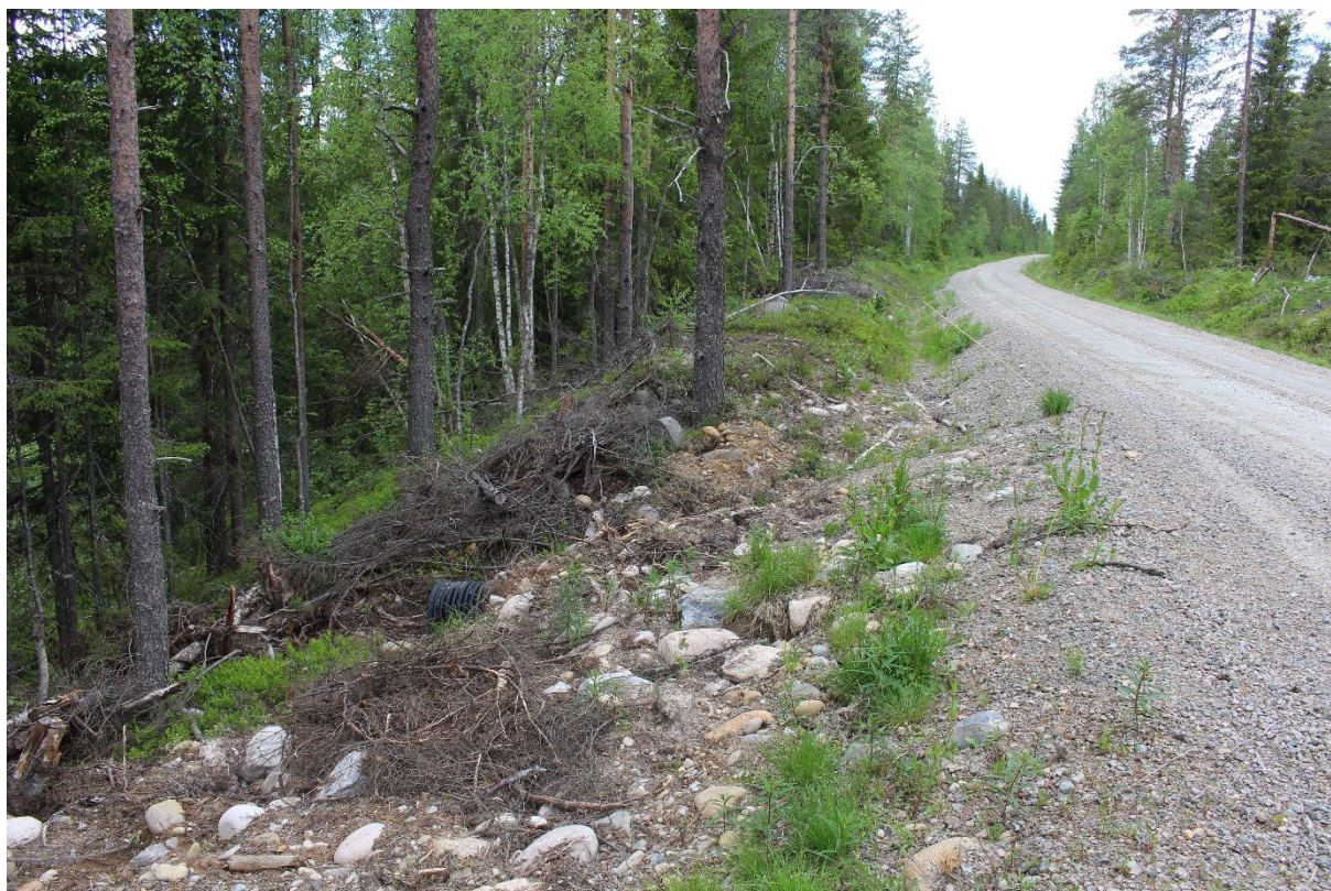
Figur 111. Eksempel på overfylt kulvert.
