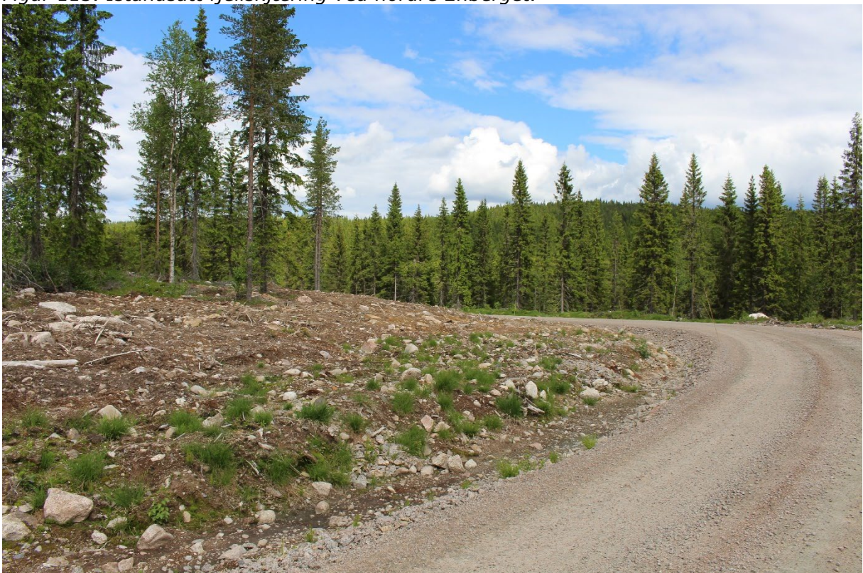
Figur 114. Vegparti med istandsatt sideterreng ved vegkryss langs adkomstveg.
