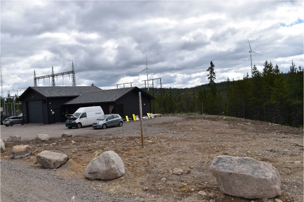
Figur 91. Servicebygg sett fra nord-vest.
