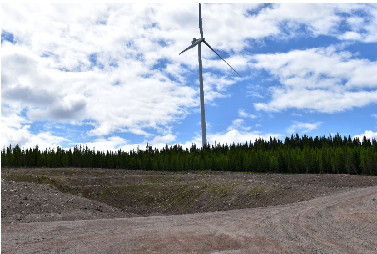
Figur 80. Massetak ved avkjøring til T10.
