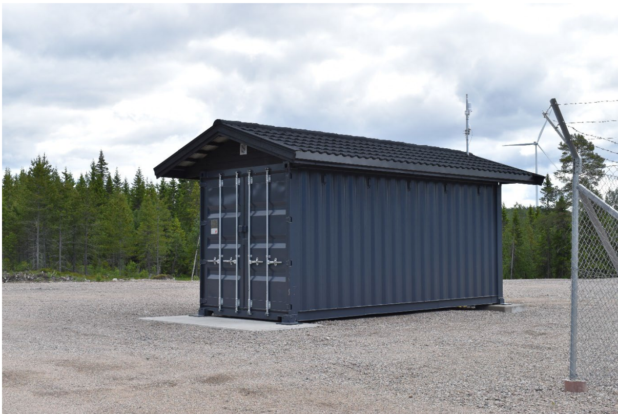
Figur 89. Scadacontainer, sett fra nord-øst.
