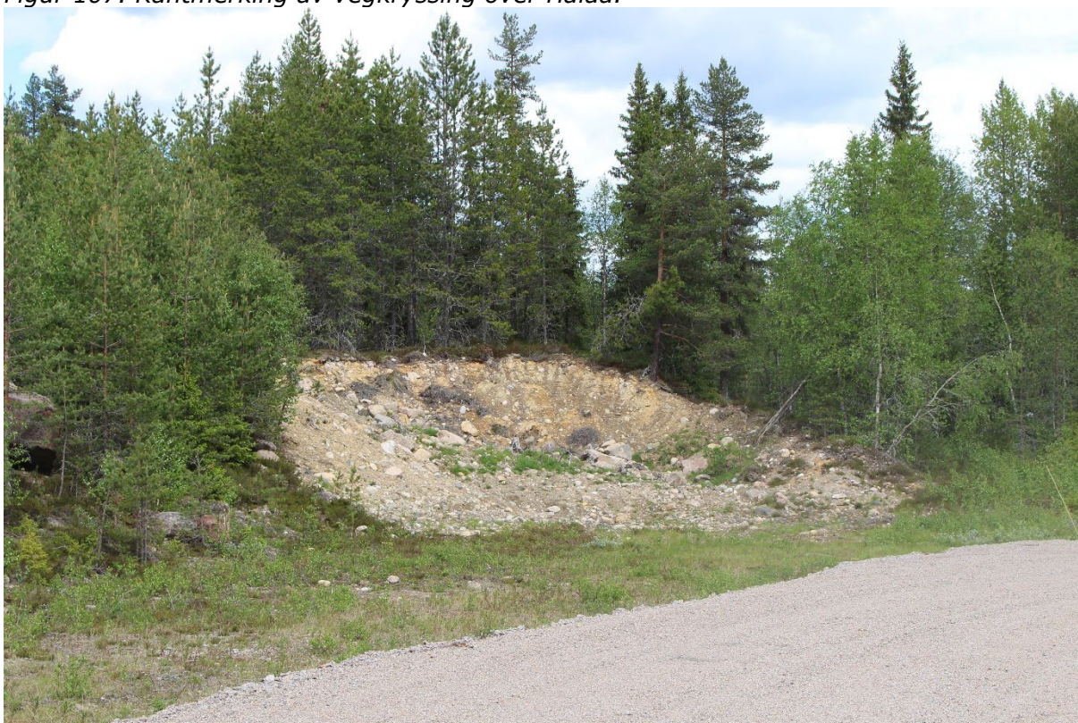
Figur 108. Istandsatt massetak øst for Halåa.
