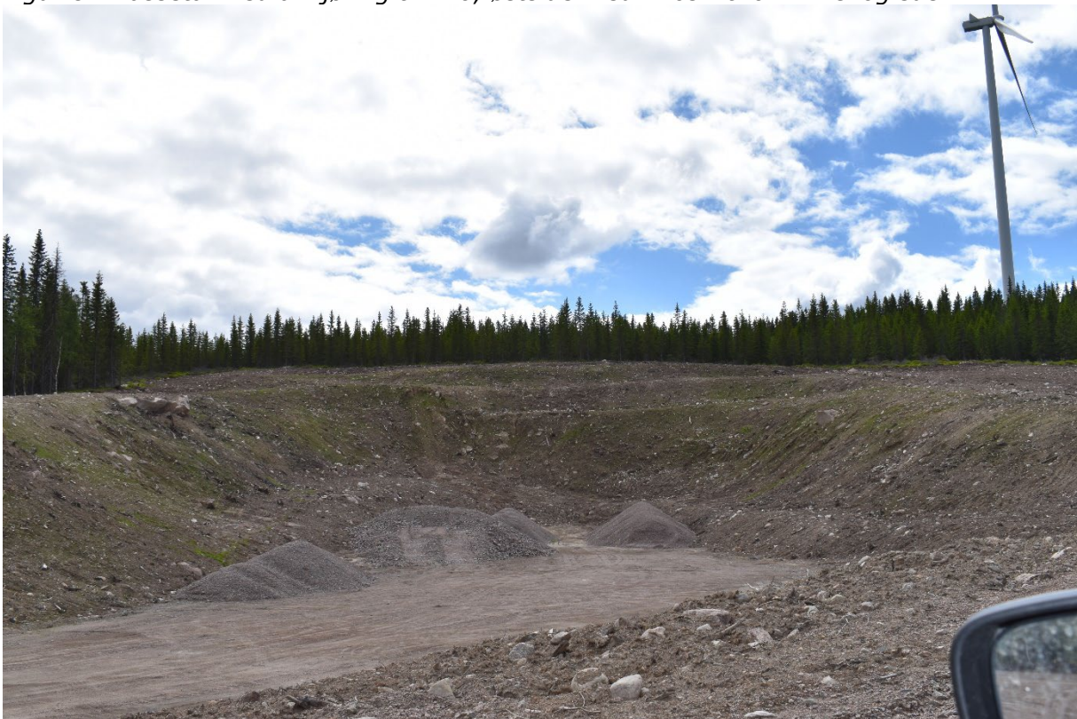
Figur 82. Massetak ved avkjøring til T10, fotoretning mot sør.
