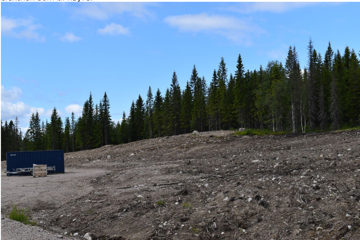
Figur 96. Serviceområde, nordside sett fra øst.
