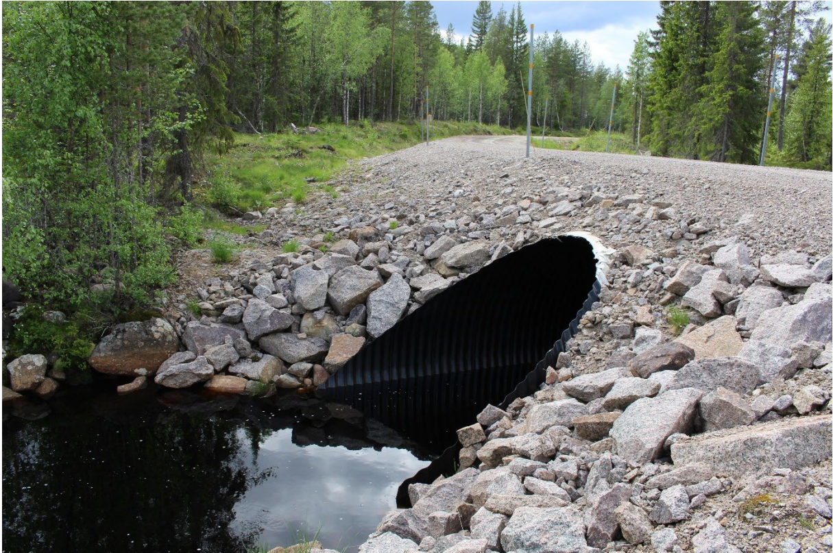
Figur 109. Eksempel på skråskjært kulvert ved Halåa.
