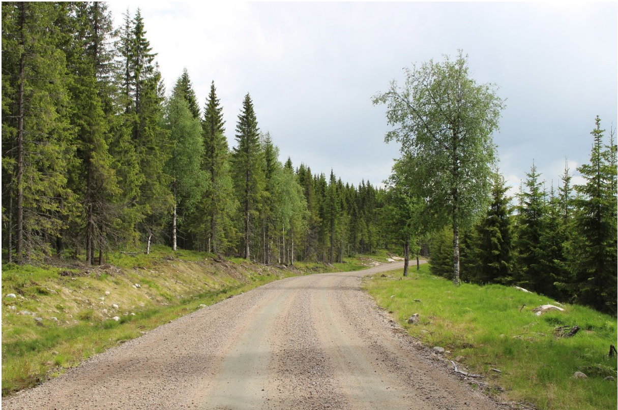
Figur 118. Vegparti med igjensatte trær på høyre side for å myke opp overgang mot uberørt sideterreng langs vegen.
