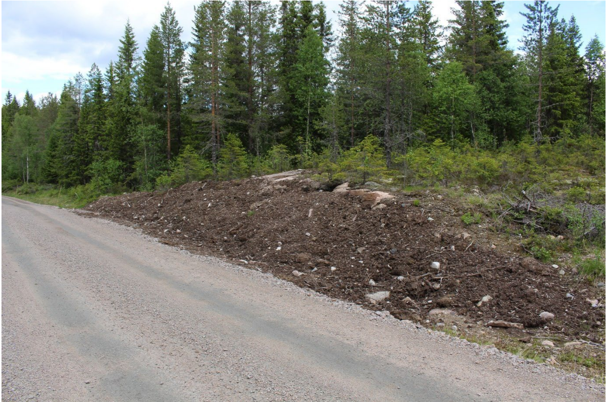
Figur 113. Istandsatt fjellskjæring ved nordre Enberget.
