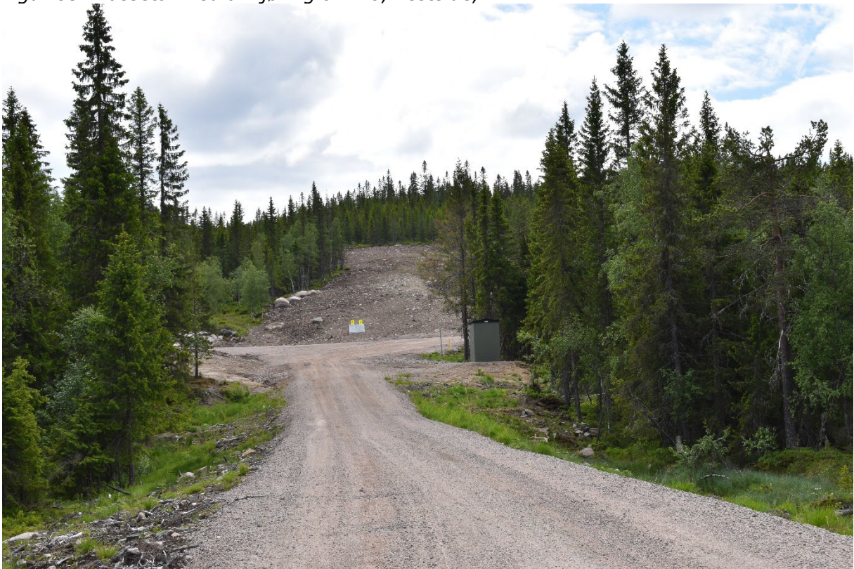
Figur 84. Vegparti inn mot massetak fra servicebygg. En koblingskiosk kan sees på høyre side av vegen.
