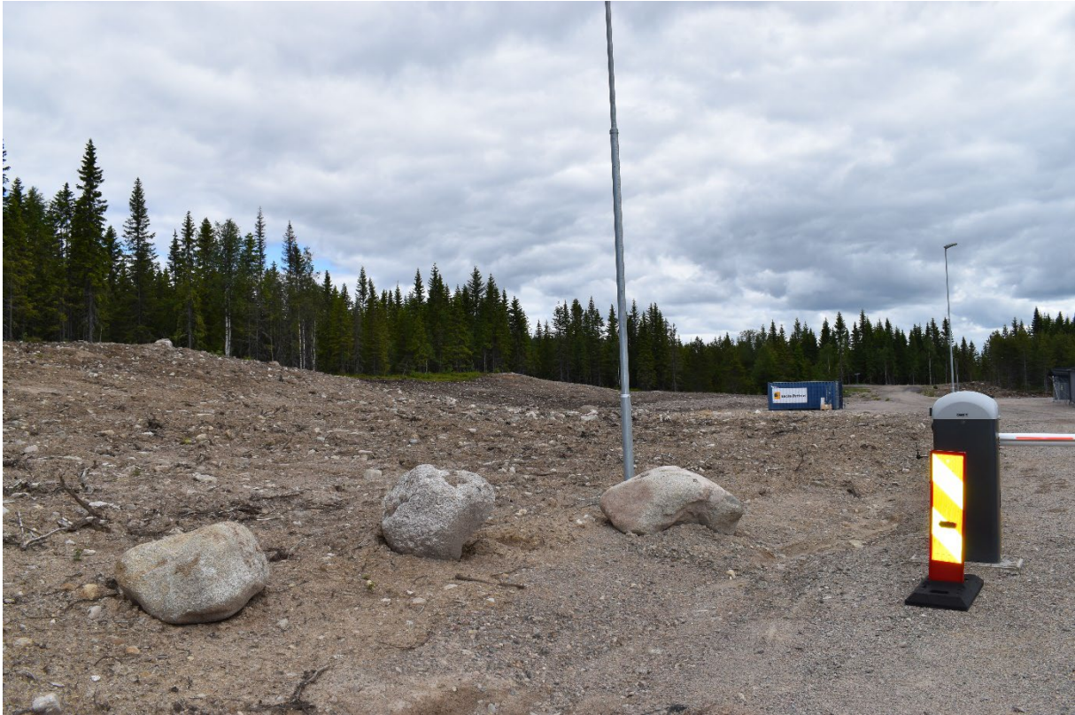
Figur 95. Serviceområde, nordside sett fra vest ved innkjøring til planområdet. Deler av elektrisk bom til høyre.
