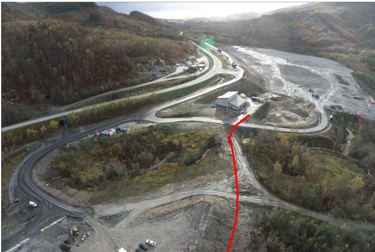
Figur 38. Kabeltraseen krysser over kulvert som vist med rød linje.
