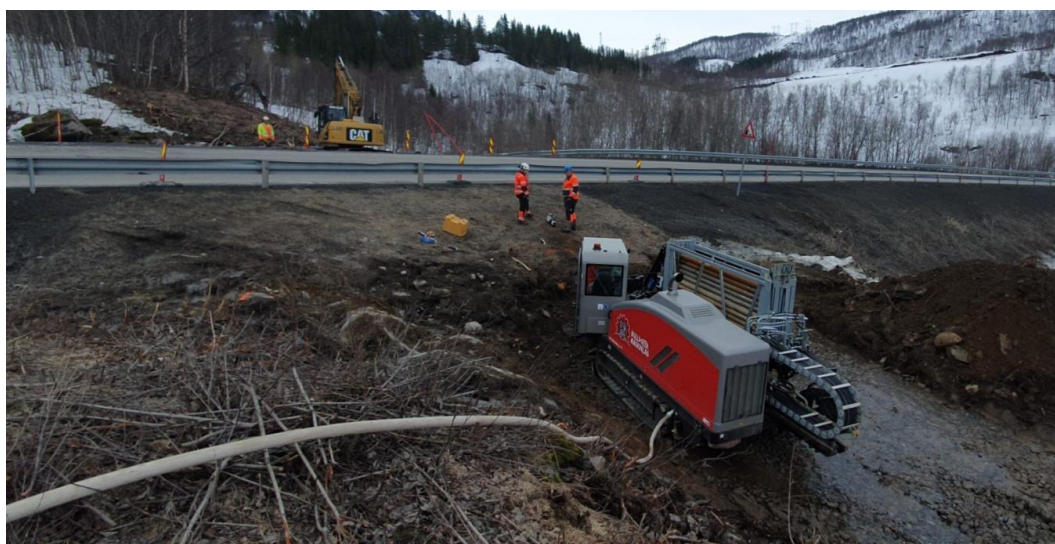
Figur 10. Boring ved krysningen av E6 for Skoglund 132. Krysningen for 420 kV-traseen er planlagt omtrent 150 meter fra trasekrysningen for Skoglund 132.
