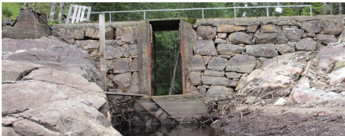
Figur 2. Fotografi av eksisterende dam viser at de nederste meterne av dammen ligger i en smal sprekke mellom to sider med fast fjell (kilde: Norconsult).
