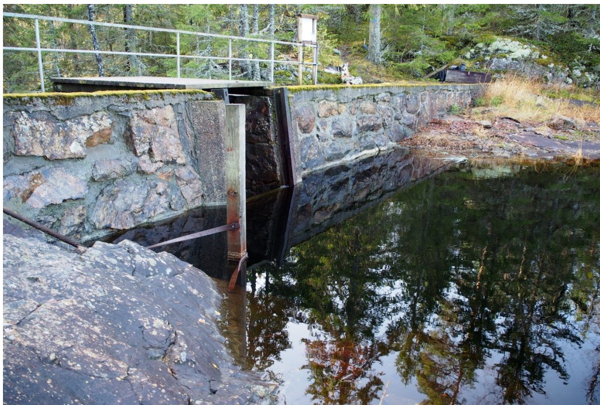
Risendammen er 4 m høy og 20 m lang. Foto: Ola Wergeland Krog 30.10.2021.
