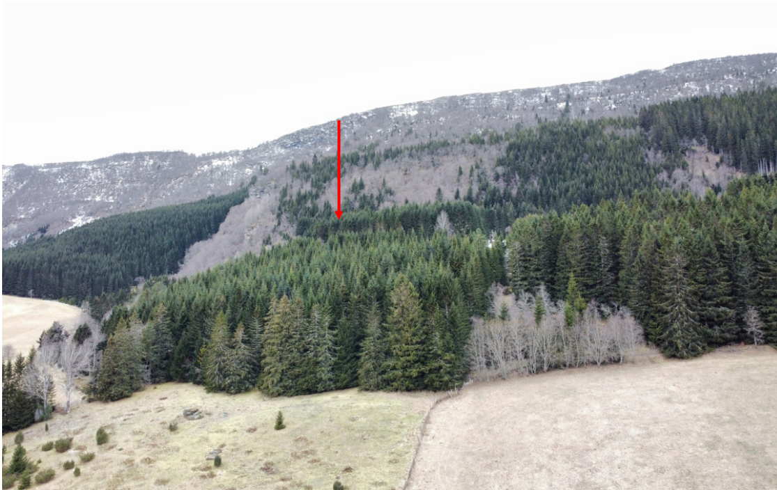
Figur 9-14 Oversikt over fjellsiden ved plasseringen til BM 8. Pilen viser omtrentlig maste-plassering.
