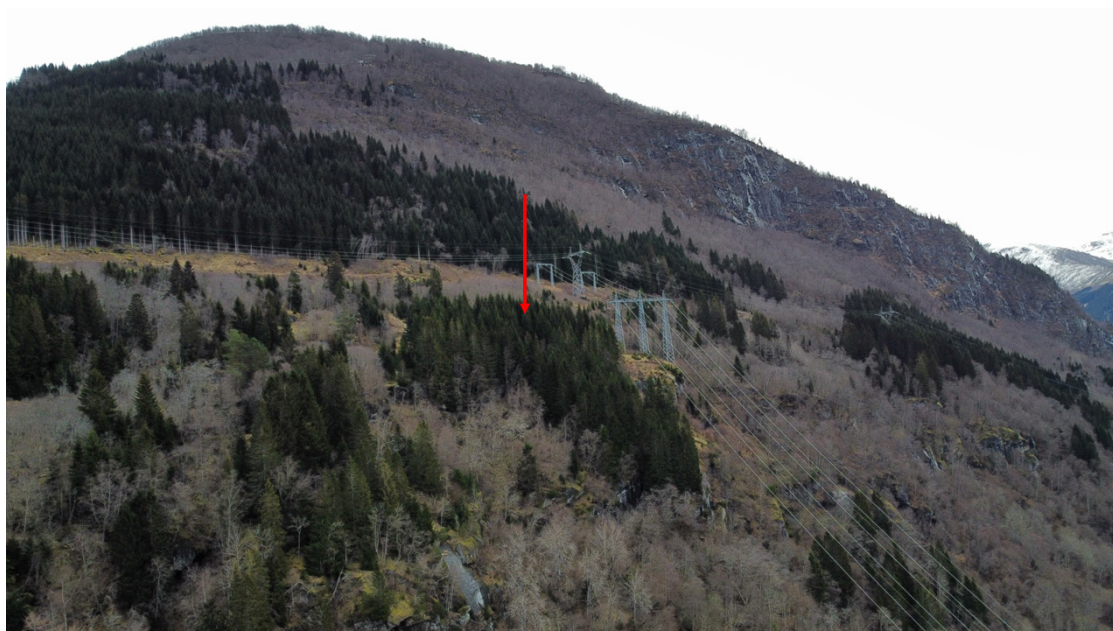
Figur 9-24 Oversikt over fjellsiden ved plasseringen til BM 17. Pilen viser omtrentlig maste-plassering.
