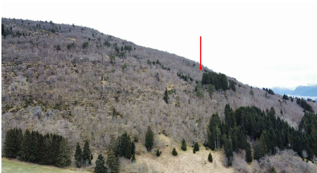
Figur 9-18 Oversikt over fjellsiden ved plasseringen til BM 13. Pilen viser omtrentlig maste-plassering.
