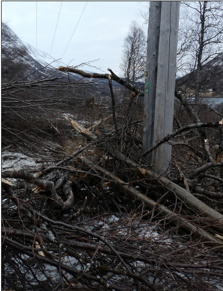
Figur 12-4 Eksempel på hvordan greiner og vegetasjon stuves opp rundt en mast (foto: Peter Gauer).
