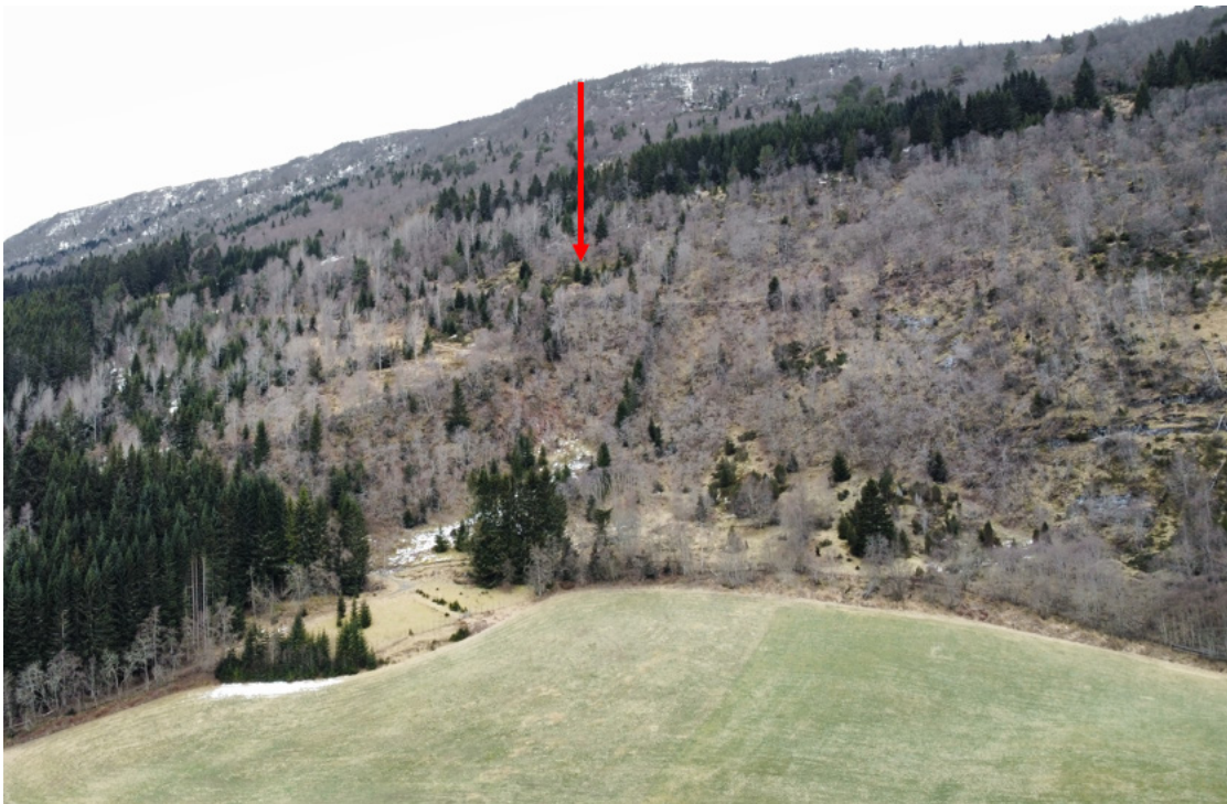
Figur 9-16 Oversikt over fjellsiden ved plasseringen til BM 11. Pilen viser omtrentlig maste-plassering.
