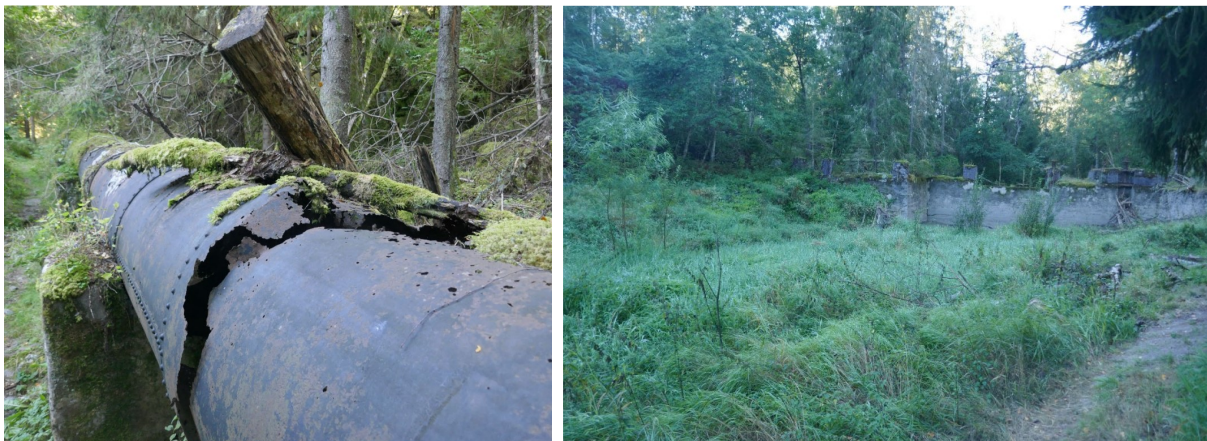
Bilde 1 Venstre foto illustrerer tilstanden til rørgaten. Bilde til høyre er tatt oppstrøms demningen og viser demning, terskel og vederlag på begge sider. Bildene er hentet fra meldingen.
