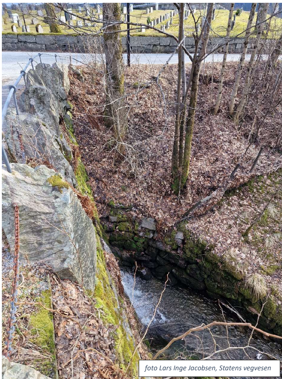
Figur 4 Mur/plastring i fot av bratt skråning ved ca. profil 210
