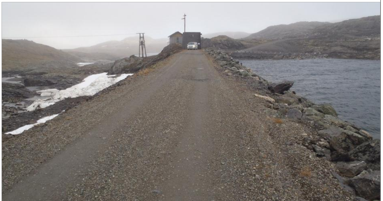
Figur 6-3. Bilde av damkrona tatt under befaring i september 2012.
