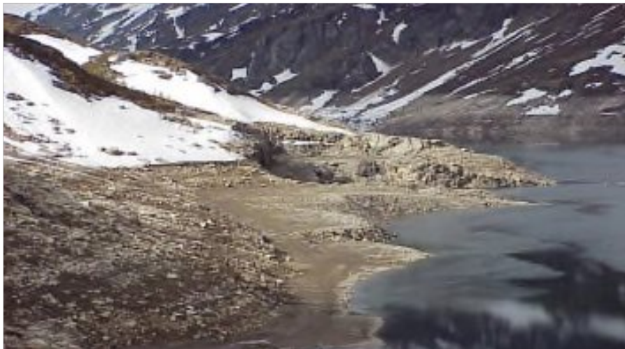
Figur 7. Bildet viser det gamle bruddet i magasinet ved østre damvederlag.
