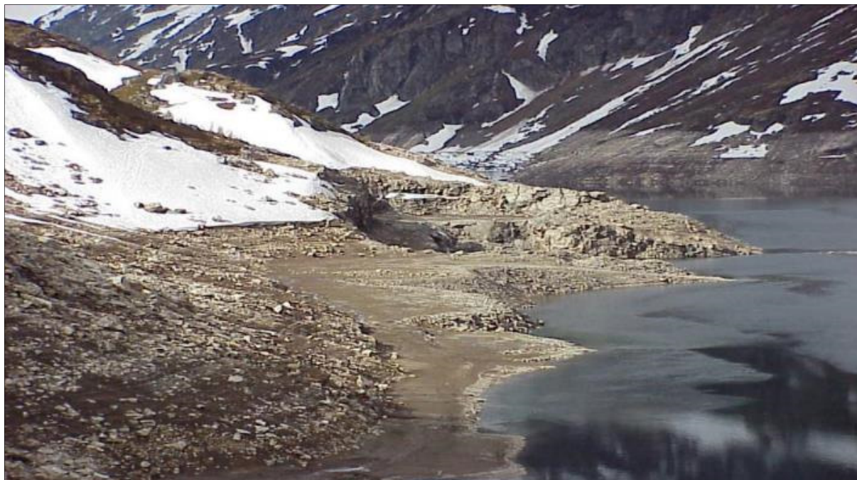
Figur 3-9. Bildet viser det gamle bruddet i magasinet ved østre damvederlag
