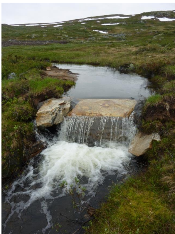
Figur 21. Øverst: sperre for ørekyt, etablert i utløpsbekken fra Bruddtjern ved Stolsvann. Nederst: Bruddtjern anno 2014.
