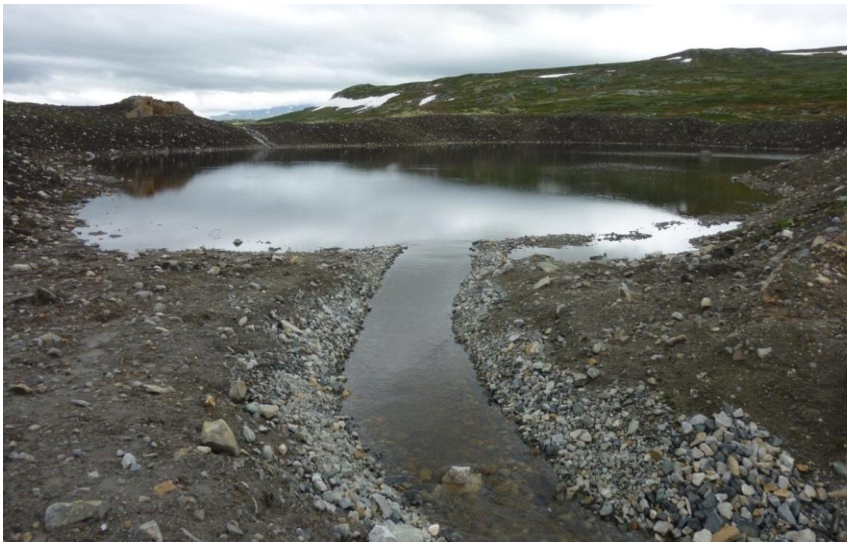
Figur 14. Øverst: Bruddtjern ved Stolsvann, tidlig sommeren 2011. Nederst: Tjernet tre år etter istandsetting, bærer preg av at revegeteringen går sin gang. Tredje sommeren etter istandsettelse er det registrert 42 karplantearter på torvjorda og 16 karplantearter på mineraljorda.
