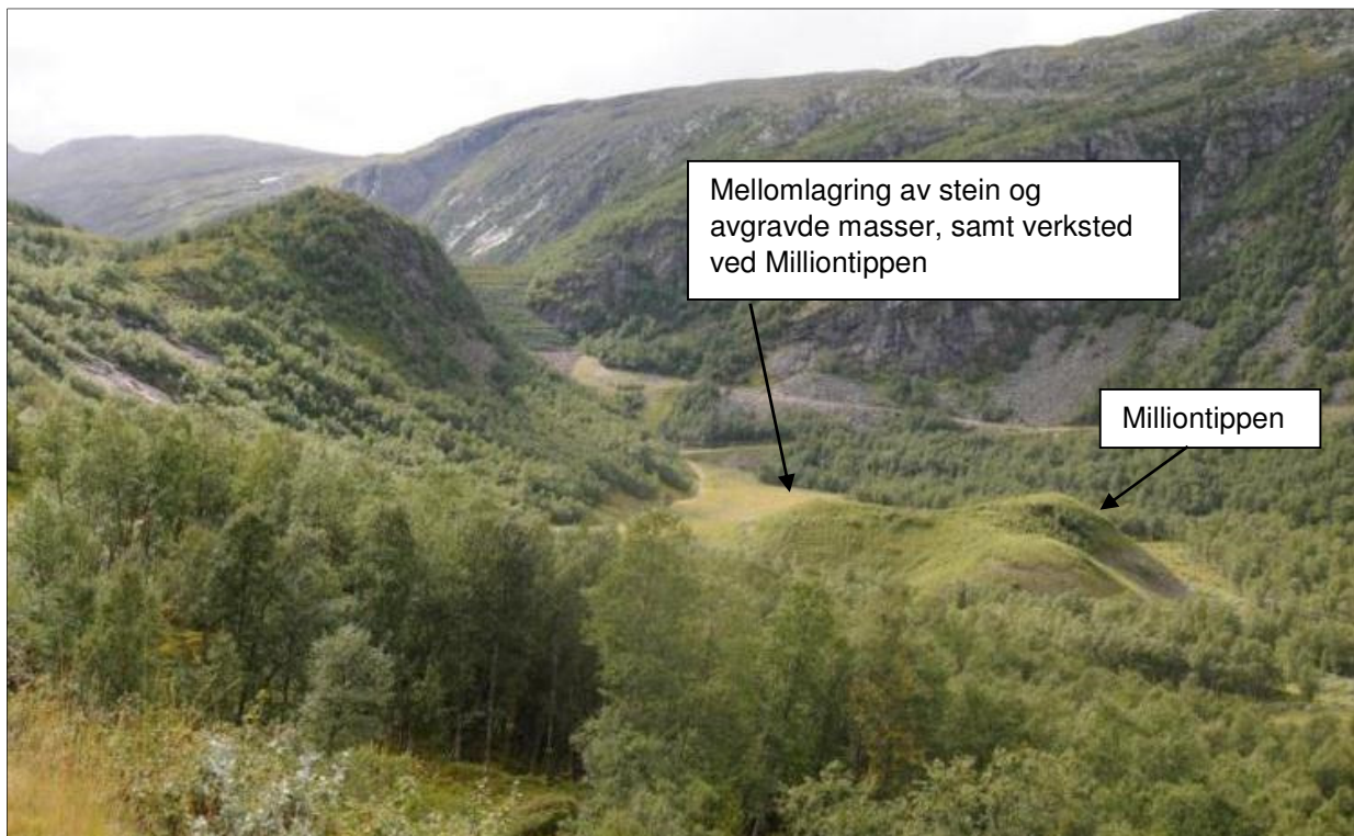
Figur 3-4. Oversiktsbilde som viser dam og arealene nedstrøms
