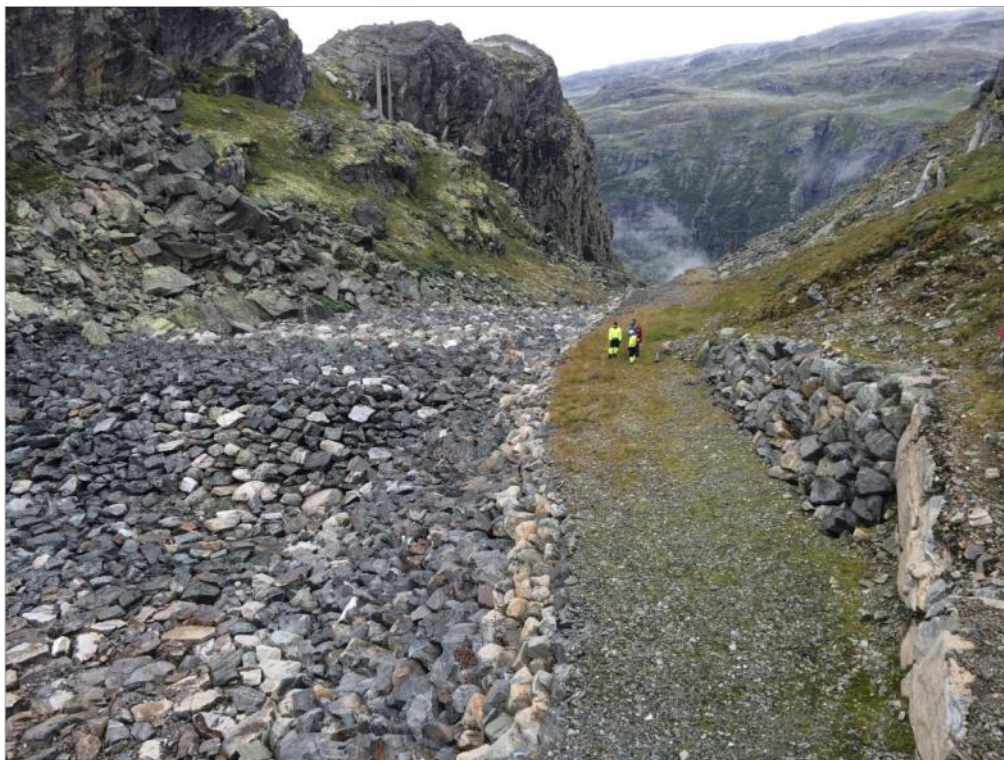
Figur 6-13. Bildet viser energidreper nedstrøms dammen, hvor det planlegges å plukke stein
