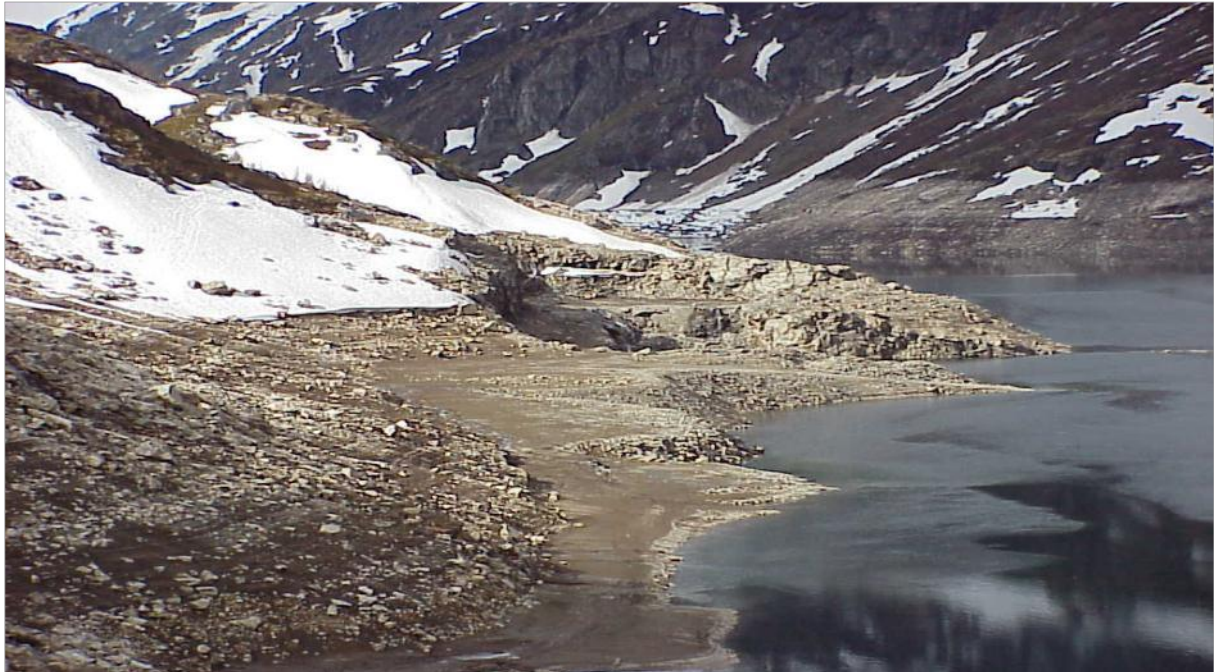
Figur 3-7. Bildet viser det gamle bruddet i magasinet ved østre damvederlag
