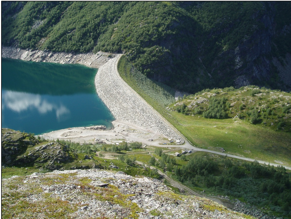
Figur 3-14. Områder for rigg ved Vidalsdammen. Det er aktuelt å ta i bruk arealer både oppstrøms og nedstrøms høyre damvederlag for rigg og parkering, delvis også for mellomlagring av stein fra uttak i eksisterende brudd i magasinet (gjelder oppstrøms areal). Rigg nedstrøms dammen vil bli liggende nedenfor fjellbjørkeskogen til høyre i bildet. Bildet viser også mesteparten av påtenkt steinbrudd ved Nuken i høyre del av bildet.
