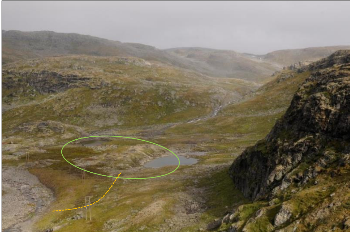
Figur 4-6. Ca. plassering av bruddtjern nedstrøms dam vist med grønn sirkel. Midlertidig anleggsvei i oransje
