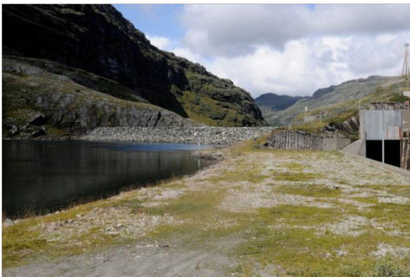
Figur 5-3. Situasjon oppstrøms dam
