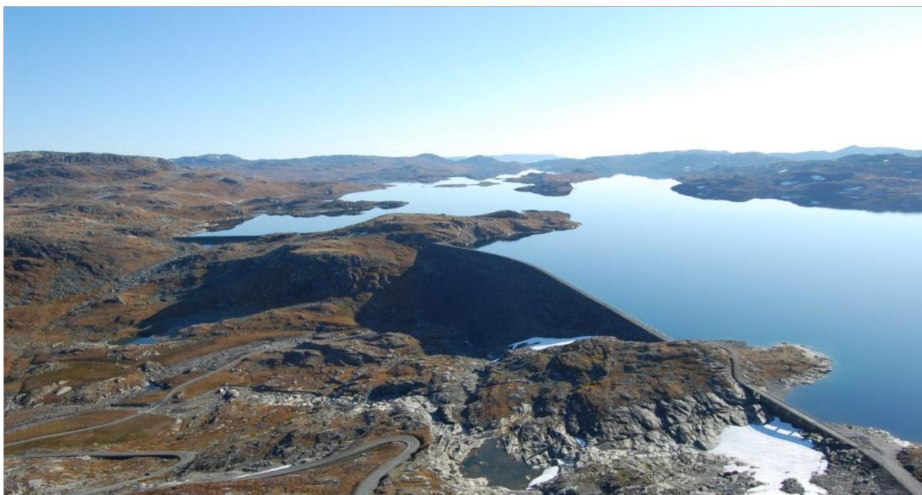
Figur 4-1. Oversiktsbilde Nyhellerdammene Foto: E-CO
