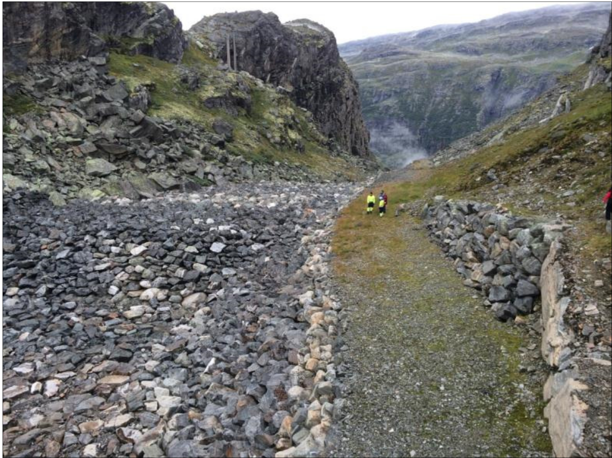
Figur 7-2. Bildet viser energidreper nedstrøms dammen, hvor det planlegges å plukke stein. Rigg til høyre i bildet.
