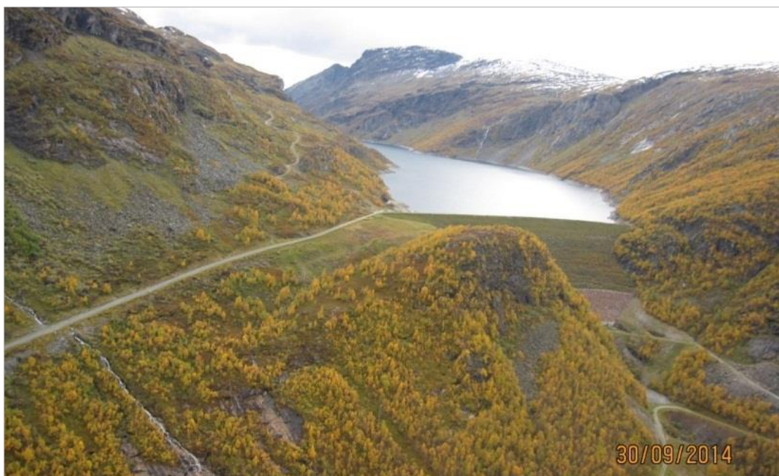
Figur 3-1. Oversiktsbilde Viddalsdammen Foto: E-CO
