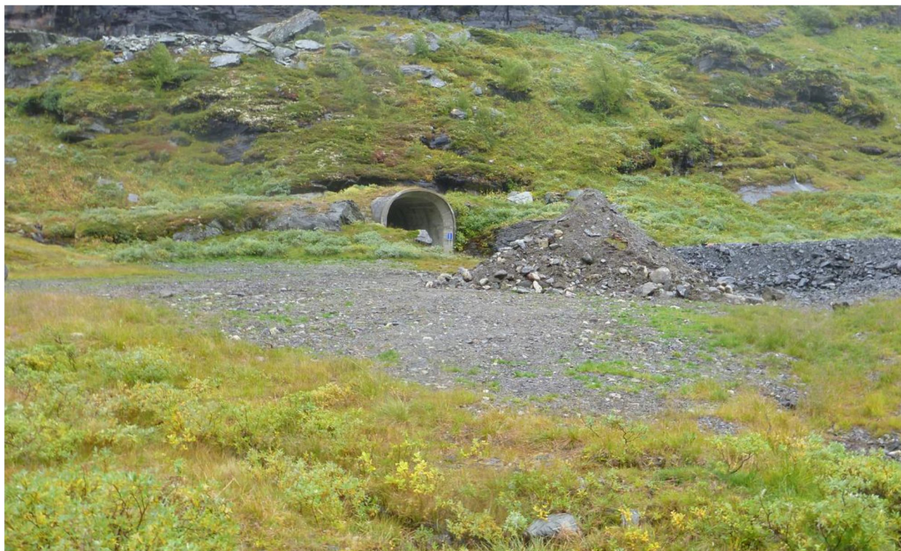
Figur 5: Store deler av området bærer preg av å ha blitt benyttet som riggplass tidligere.
