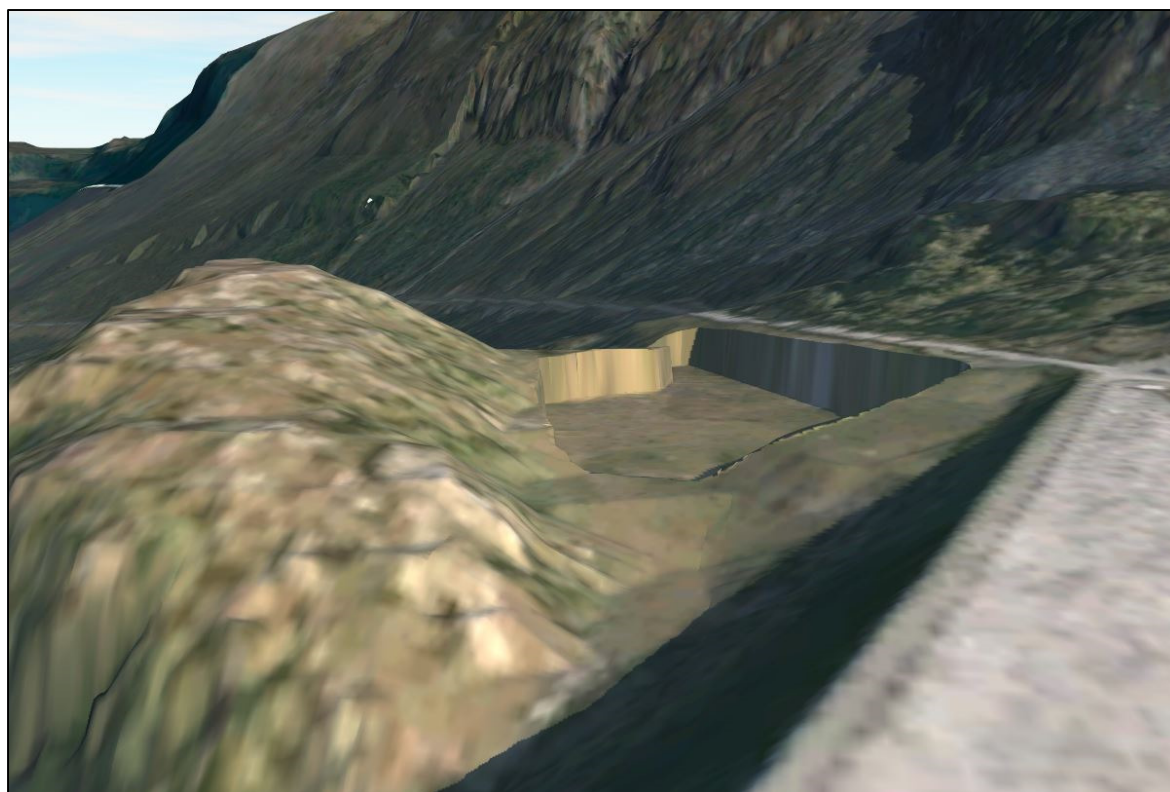
Figur 3-7. Visualisering av brudd Nuken i uttaksfasen. Sett fra dammen
