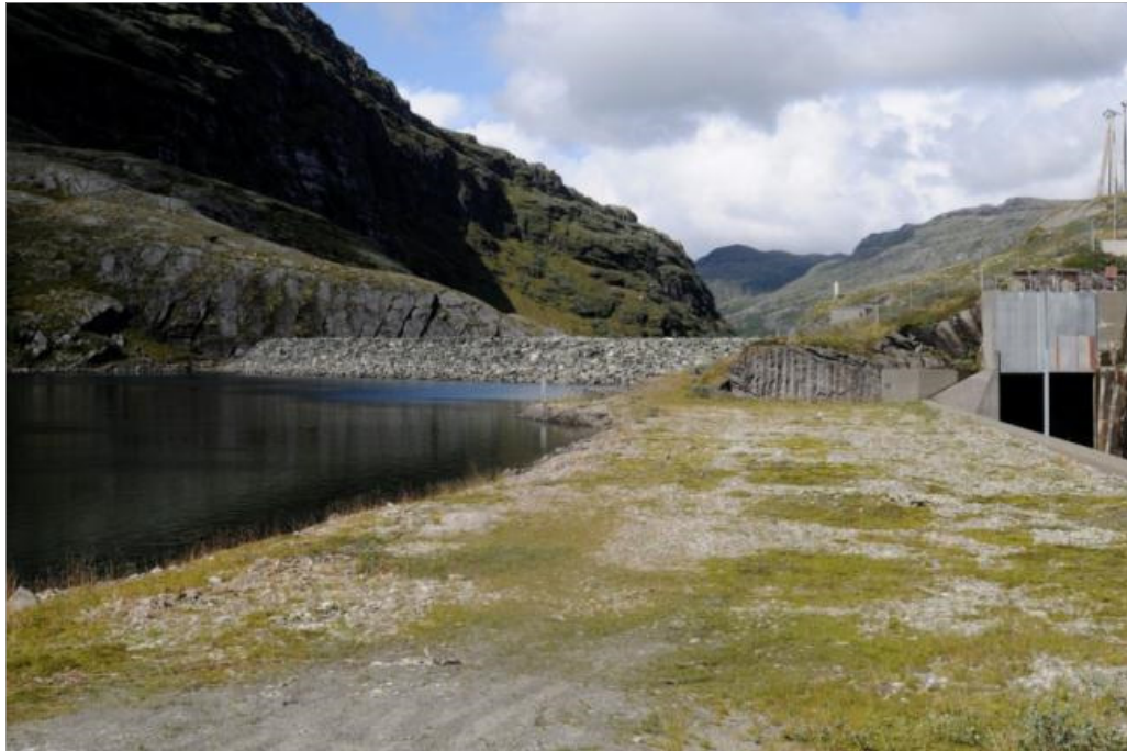
Figur 5-2. Situasjon oppstrøms dam.
