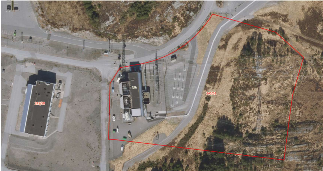
Kollsnes transformatorstasjon med eiendomsgrense
