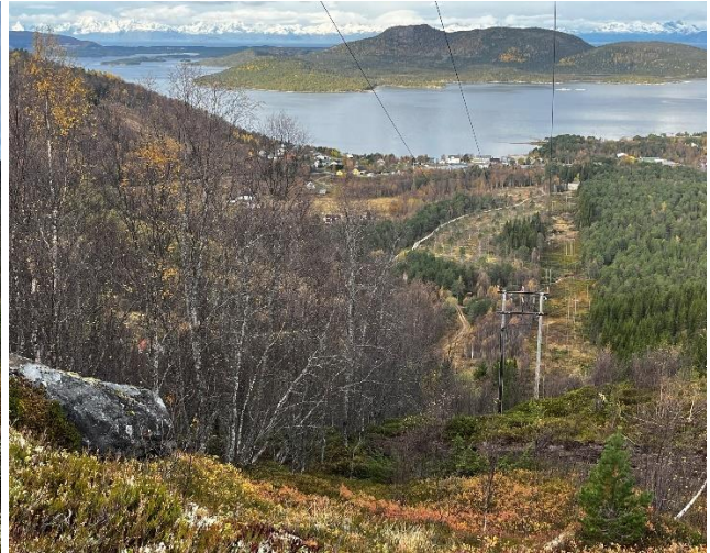
Figur 2-10: Inngangen til Ulsvåg transformatorstasjon (hvit bygning i skoggrensen) enten som luftledning på østsiden eller som jordkabel i vegen på vestsiden.
