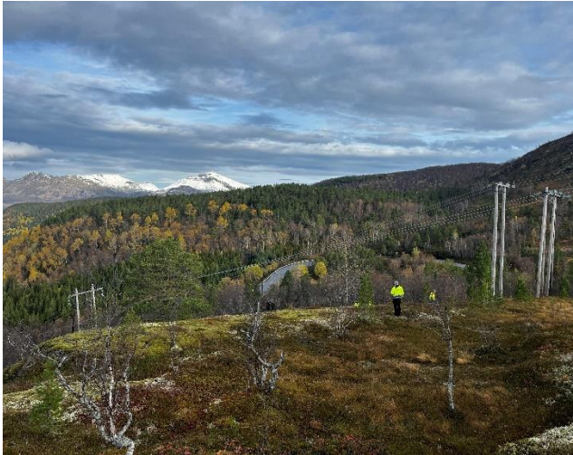
Figur 2-9: For alt. 1.1 vil ledningen krysse 22 kV/66kV ledninger i dette området innen siste kryssing av E6 (som ses i bakgrunnen i bildet). Alt 1.2 vil fortsette på vestsiden.
