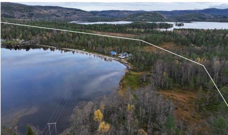
Figur 5-13. Ny 66 kV-ledning forbi Tverråsvatnet markert med hvit linje. Dagens 22 kV-ledning krysser vannet til venstre.
