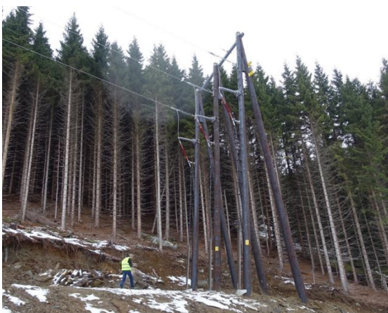
Figur 2-18: Eksempel på kabelendemast med trestolper.
