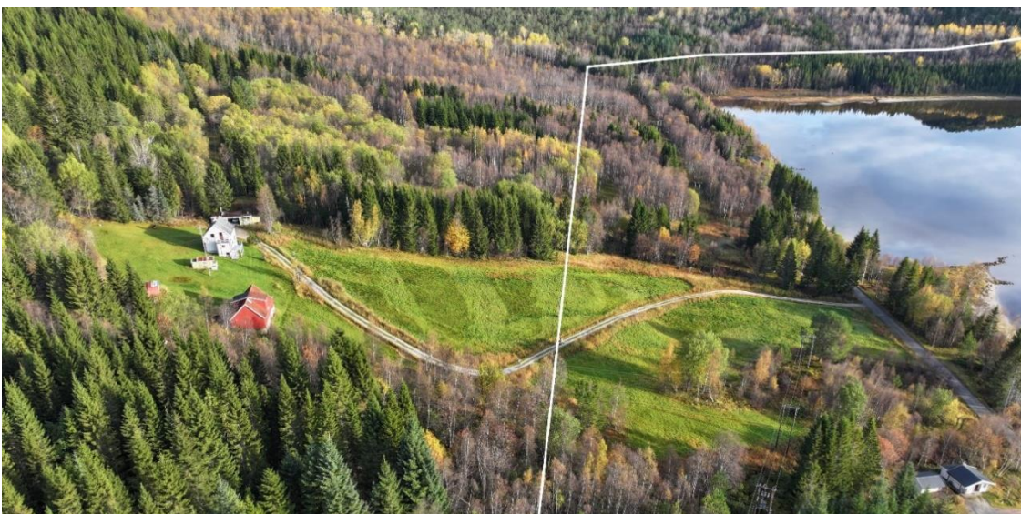
Figur 5-11. Ny ledning forbi Solli. Trase for ny 66 kV-ledning markert med hvit linje. Eksisterende 22 kV-ledning til høyre i bildet.
