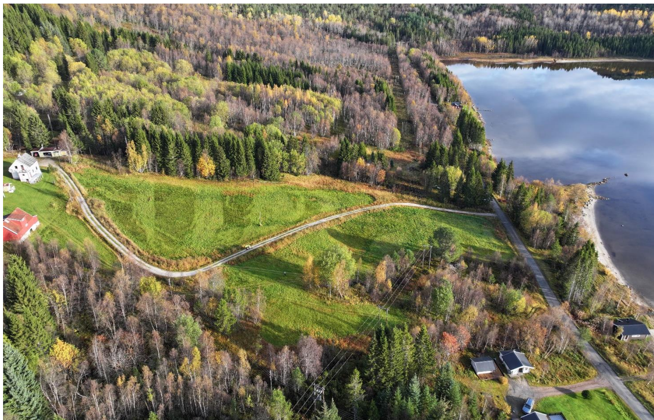
Figur 2-4: Dronefoto fra Solli. Eksisterende 22 kV-ledning ses til høyre i bildet. Ny 66 kV-ledning vil krysse gårdsvegen sør om svingen (i området hvor det står folk med gul arbeidsjakke på bildet). Dronefoto: Kystnett.
