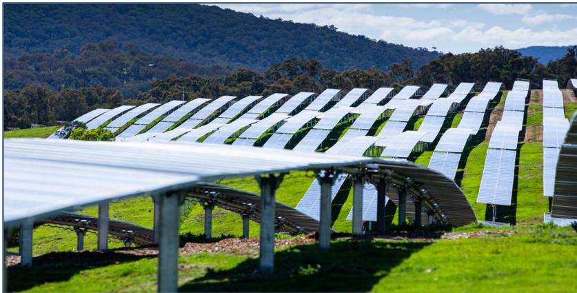
Figur 5.1 Illustrasjonsfoto av én-akse system. Kilde: Nextracker
