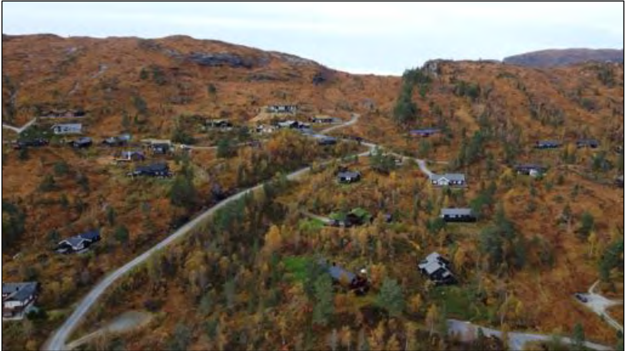
Figur 33: Dronebilde av den nordlige delen av området Furedalen. Bildet er tatt mot nordvest.
