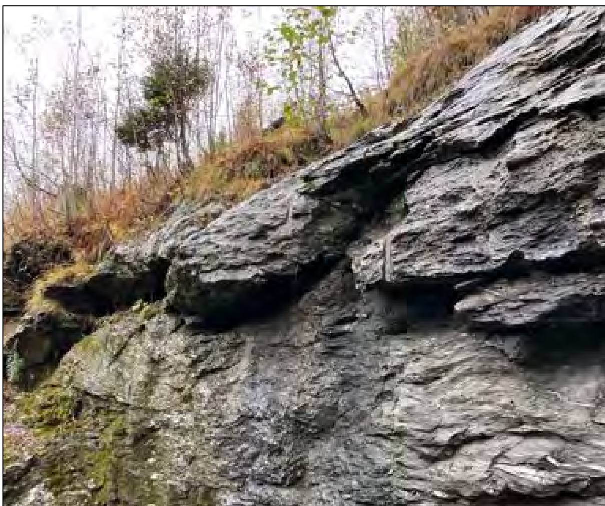
Figur 42: Bilde av en skjæring med en blokk som tydelig har beveget seg i den østlige delen av området Kvinnhovden-Alhovden. Bildet er tatt mot vest.
