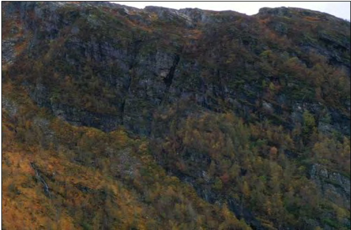
Figur 14: En ganske bratt klippe nordøst for planområdet. I underkant av klippen sees urmasser som er sammenhengende tettest på og mer usammenhengende lenger ute.
