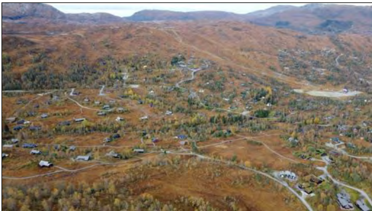
Figur 37: Dronebilde av den sørlige delen av området Furedalen. Bildet er tatt mot nordvest.
