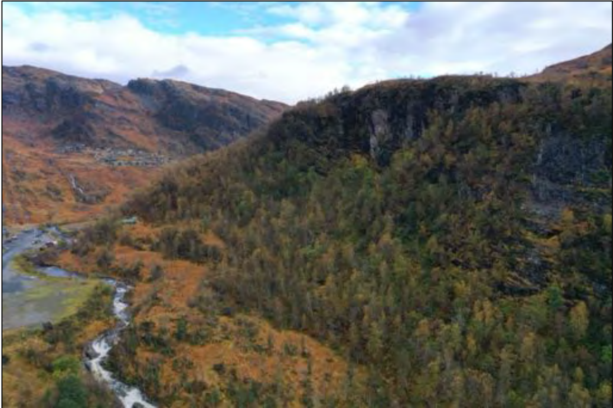
Figur 7: Dronebilde av den nordlige delen av skråningen i området. Bildet er tatt mot nordøst.
