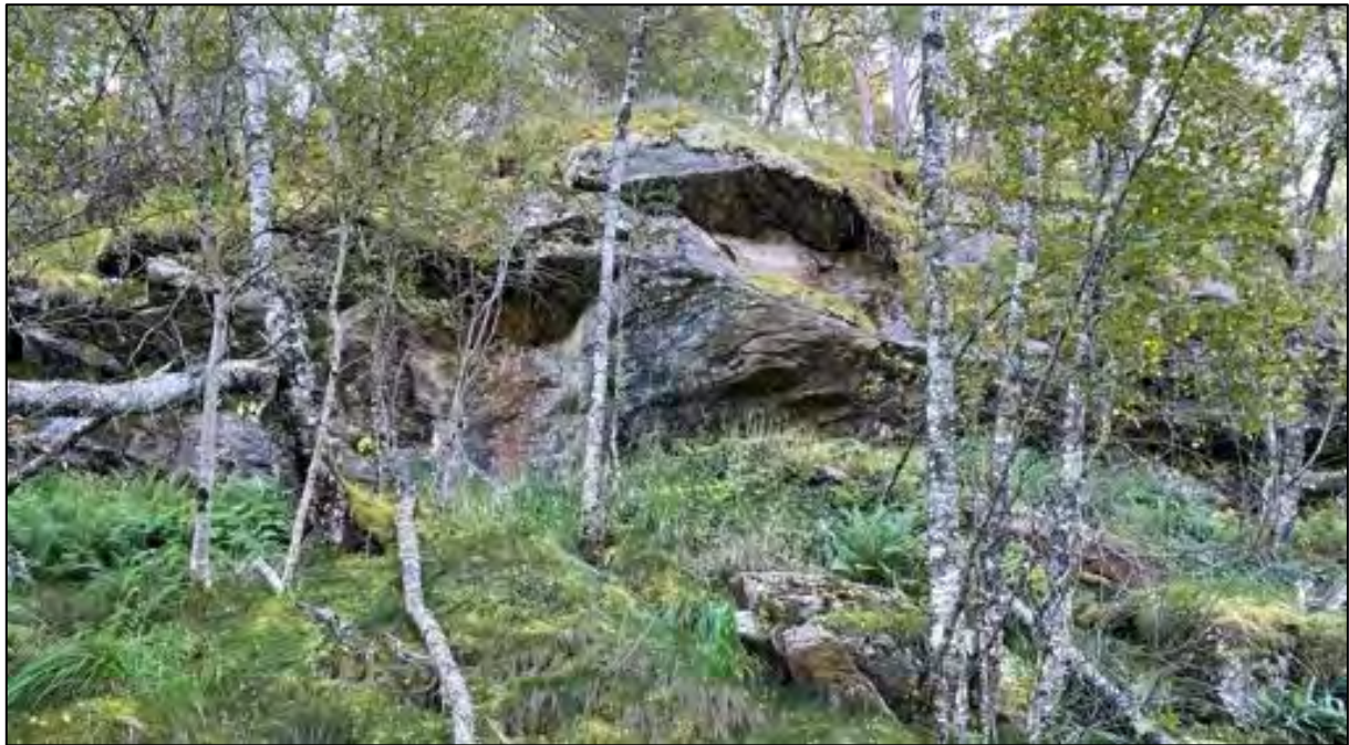
Figur 28: En skrent sentralt i området hvor berget er forholdsvis massivt, men stedvis med noe overheng. Noen steinblokker har falt ut av skrenten og lagt seg rett i underkant.
