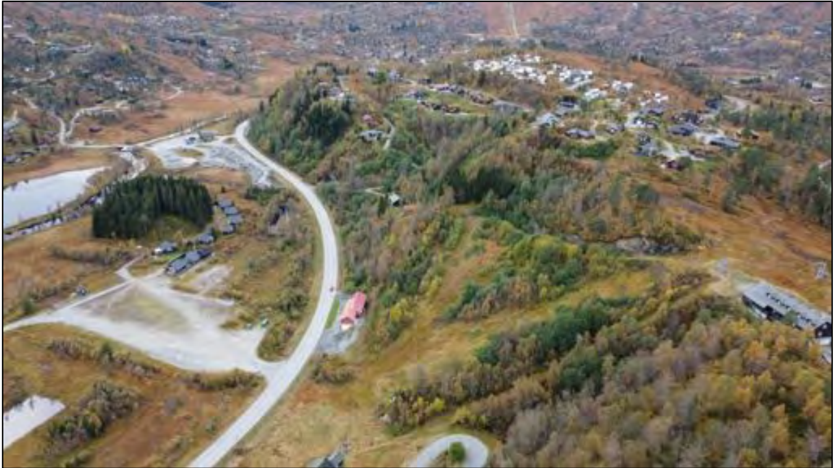
Figur 39: Dronebilde av den østlige delen av området Kvinnhovden-Alhovden. Bildet er tatt mot sørvest.
