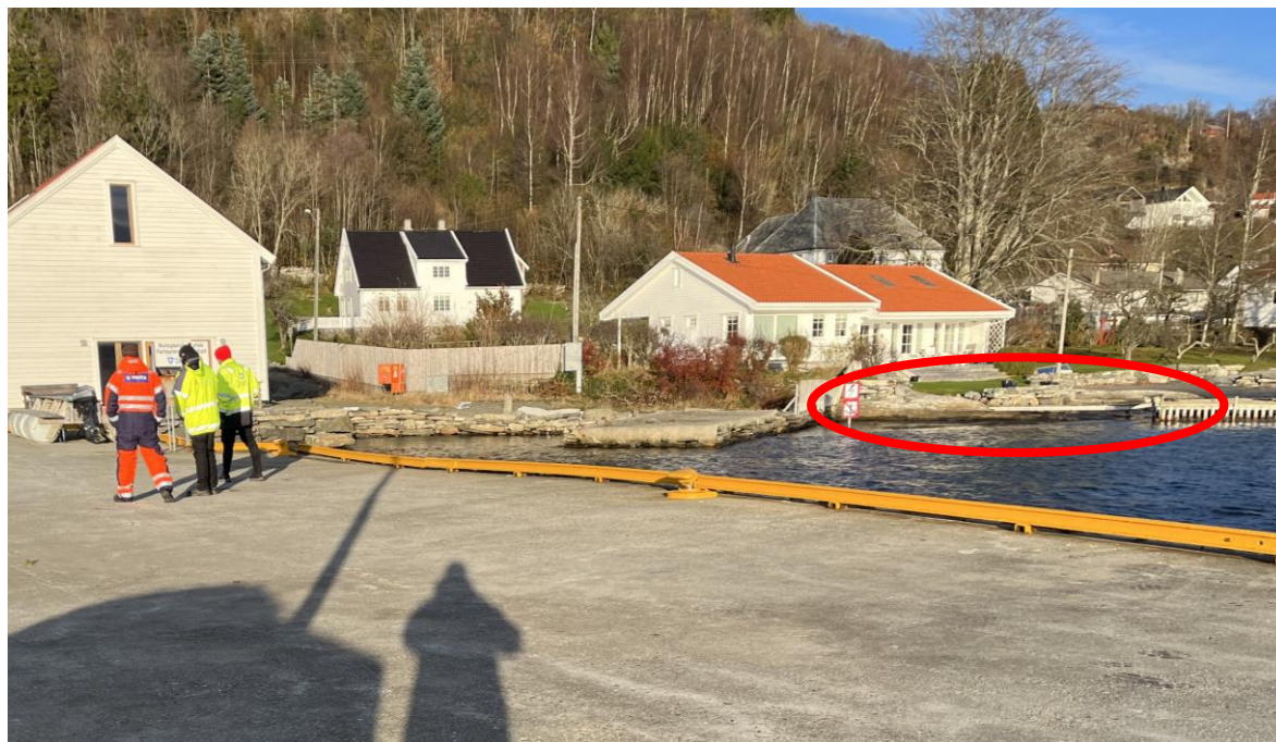
Figur 6-10: Berg i dagen ved bebyggelsen øst for tilleggskaia.
