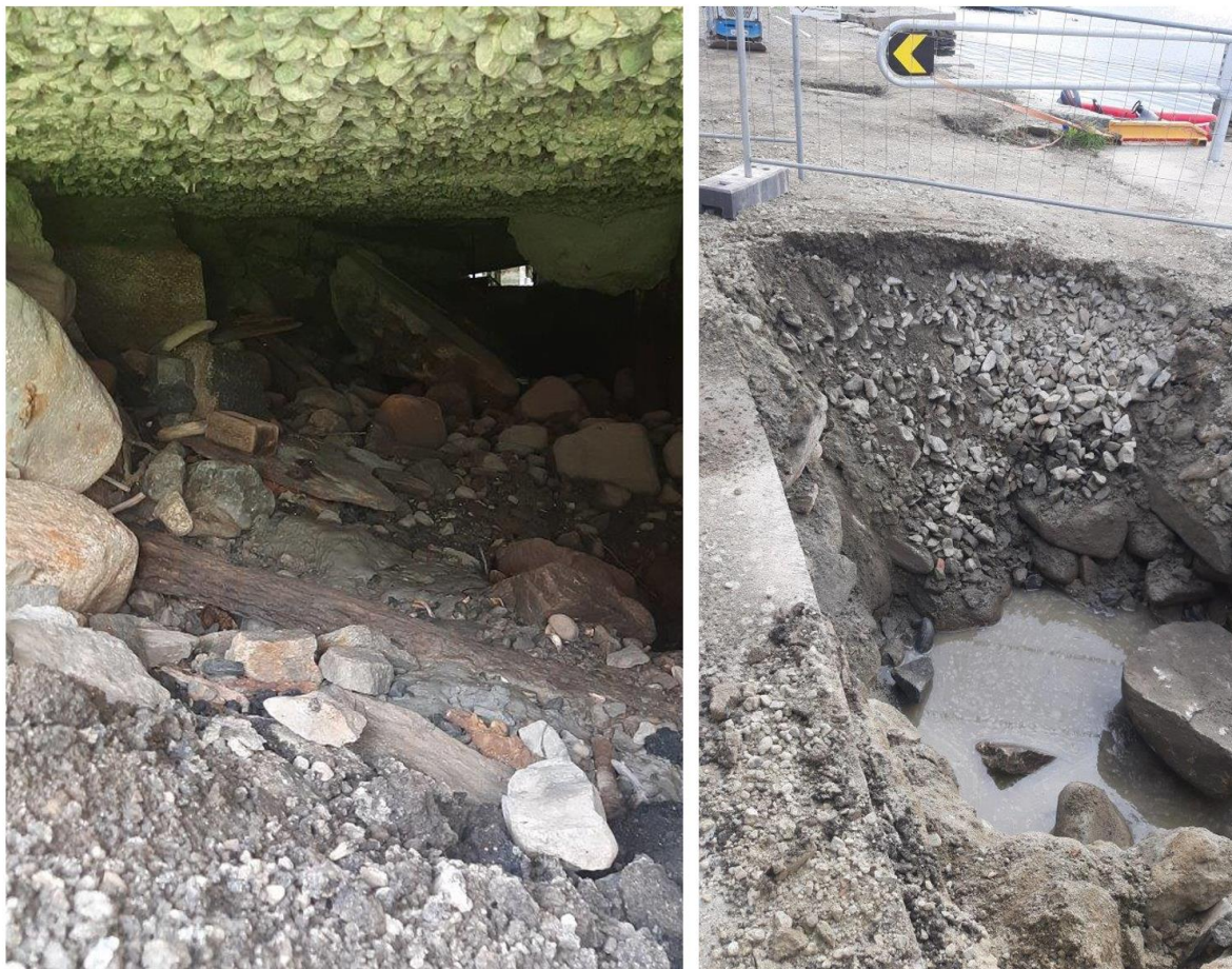
Figur 6-11: Underside av Nedstrand ferjekai (venstre) og observert lagdeling fra prøvegraving (høyre).
