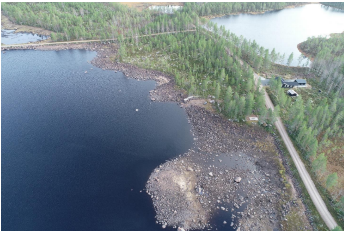
Figur 7. Foto litt øst for hoveddam Nordre Røgden med vannstand på kote 368,32 (fra dok. 46).
