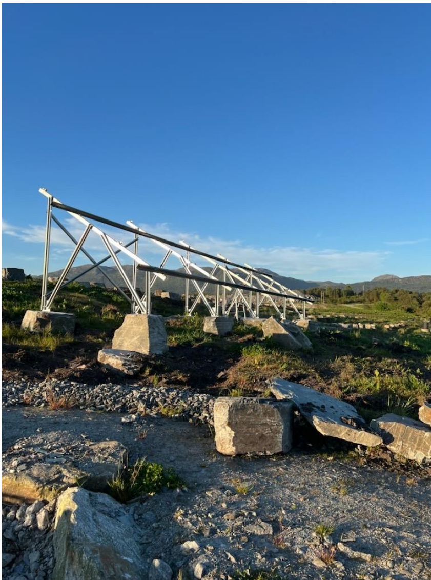
Figur 11: Illustrasjon av solcellestativ som er feste til naturstein som ballastvekt. Bilde: HIM Toraneset solkraftverk våren 2025.
