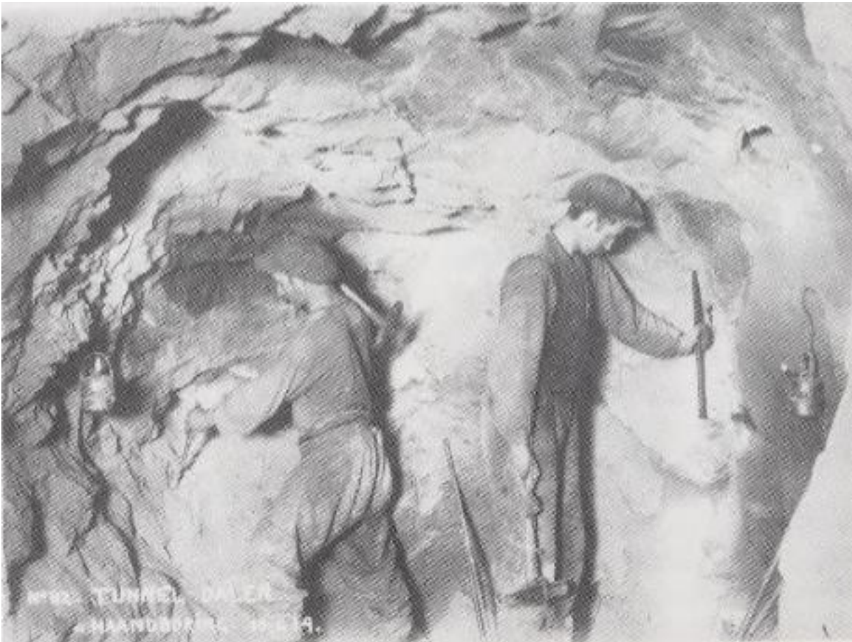
Figur 3-1 I den første tiden etter anleggsoppstart i 1913 foregikk tunnelboringen for hånd. Det var viktig å få på plass et midlertidig kraftverk som lettet anleggsarbeidet, og Dalen 1 ble bygget på Dalaråa 1913-1916. Anleggsjernbanen var nødvendig for å få frem utstyr og mannskap til de ulike arbeidsstedene i fjellet. Foto fra tidlig fase med tunnelldriving ved Dalen, med enkelt utstyr. Kilde: Flaa, 1990: 16.
