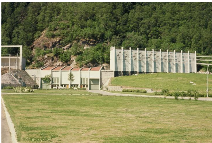
Figur 4-22 Aura kraftstasjon, portal og uttakshus, ca. 1970. Foto: Statkraft.
