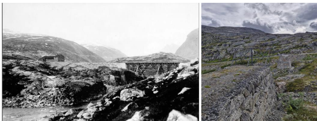
Figur 4-17 Venstre: Den gamle jernbanebroen på Holbu, med Aurabanen innover fjellsidene i bakgrunnen. Kilde: Flaa, 1990: 111. Høyre: Brohodene til jernbanebroen står igjen like foran Holbudammen, bilveien er lagt om og følger ikke banelinjen i dette partiet.
