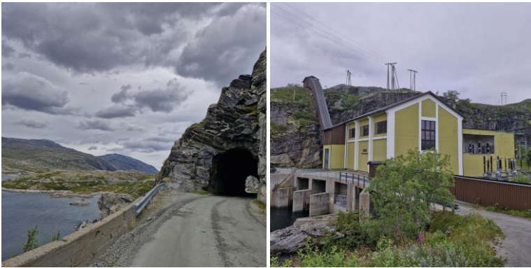
Figur 4-18 Venstre: Jernbanetunnelen i Vakkerdalsbakken er en del av Aurabanen. Høyre: Osbu kraftverk (1958), som skal legges ned og rives. Osbu var «endeholdeplassen» til Aurabanen.
