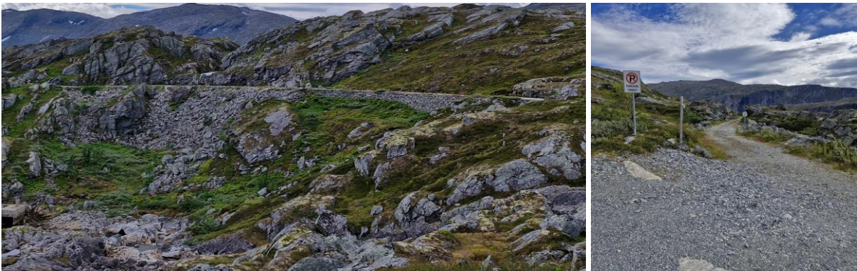
Figur 4-19 Venstre: Parti av Aurabanen (Dalsbygdvegen) like sør for Reinsvasselva, i dag bilvei, men med tørrmurer, utfyllinger og skjæringer som trolig er del av jernbanens oppbygning. Høyre: Aurabanen sett fra krysset ved Reinsvasselva og krysset ved Dalsbygdsvegen.
