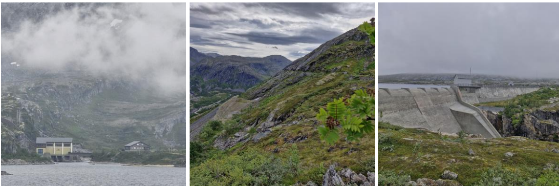
Figur 4-4 Venstre: Osbu kraftverk. Midten: Utsikt over Eikelitippen, Aurabanen og Litldalen. Høyre: Holbudammen.
