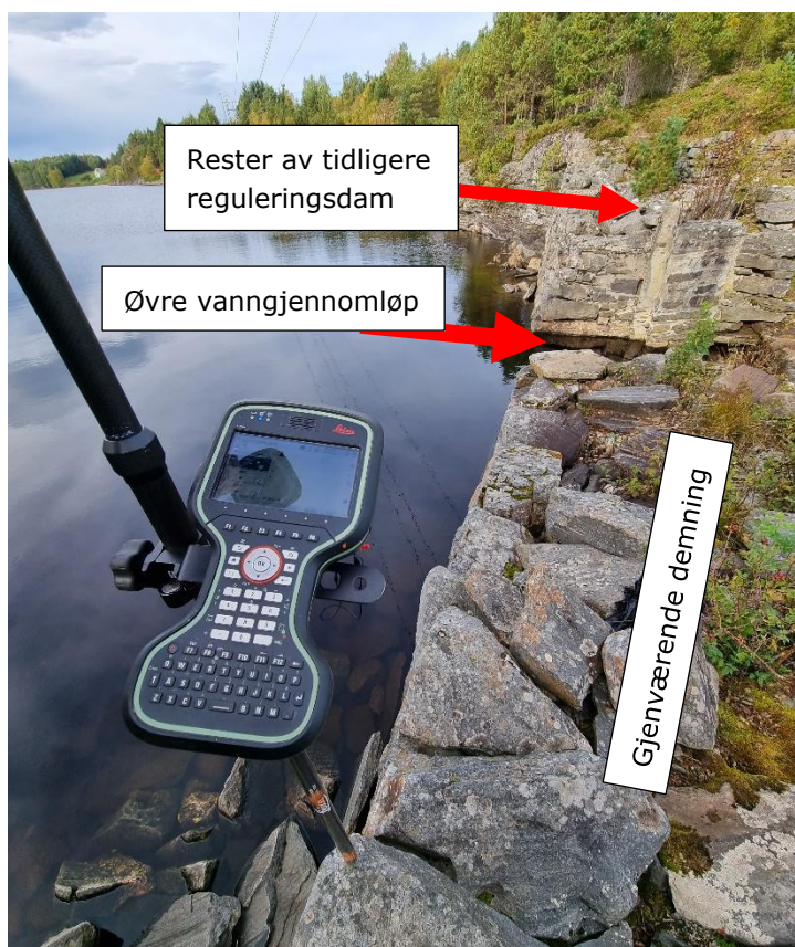
Figuren viser dagens demning sør for utløpet. Over utløpet kan også rester av anleggsflate for tømmerstokker i gammel reguleringsdam sees.
