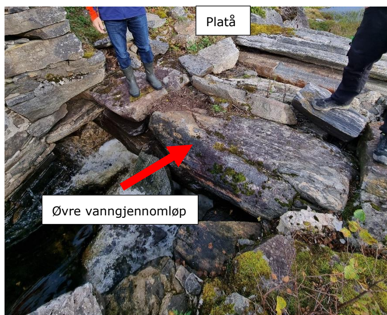
Figuren viser innløpet i sjakten og platået over. Platået over sjakten er målt til å ha en høyde på ca. kote +26,6.
