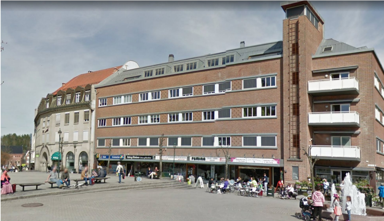
Figur 4.21 Bryggerigården vest for tomten vil danne en hindring for et eventuelt skredutløp.
