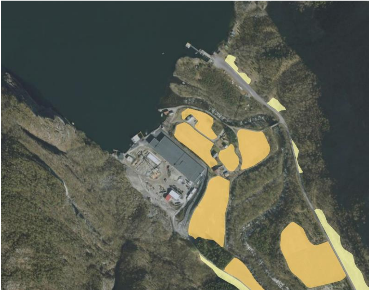
Figur 27: Jordbruksareal i nærleiken av tiltaket. Oransje farge er fulldyrka jord, lysegul farge er innmarksbeite (NIBIO, 2022).
