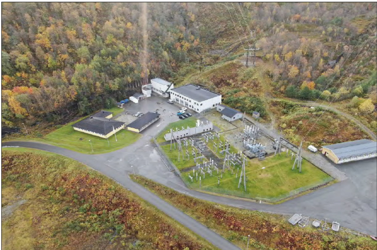
Figur 52: Viser bilde av Sundsfjord trafostasjon 40/8 (Gildeskål kommune) som kan benyttes til vinsj/trommelplass.
