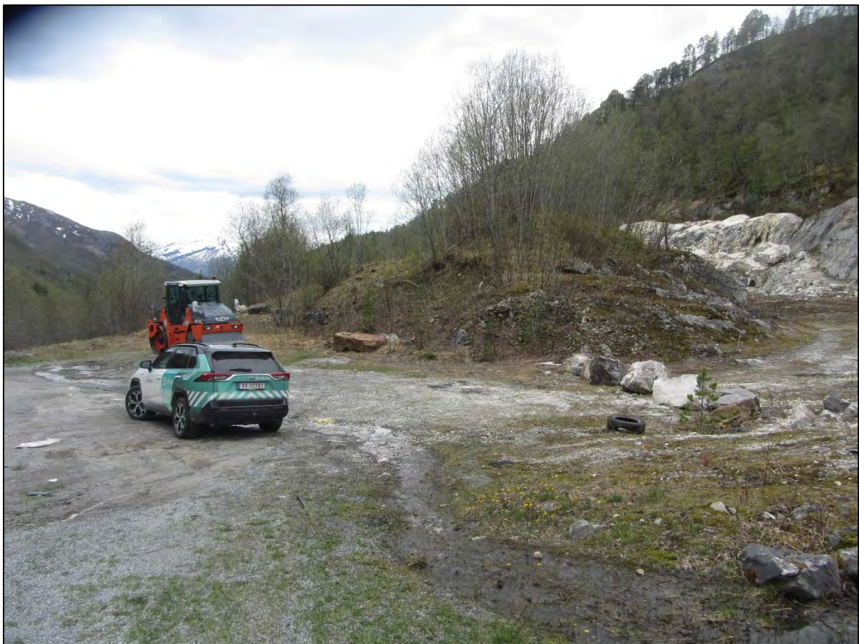
Figur 40: Viser et bilde over eiendom 54/2 (Gildeskål kommune) som kan benyttet som vinsj/trommelplass (Alternativ 1).
