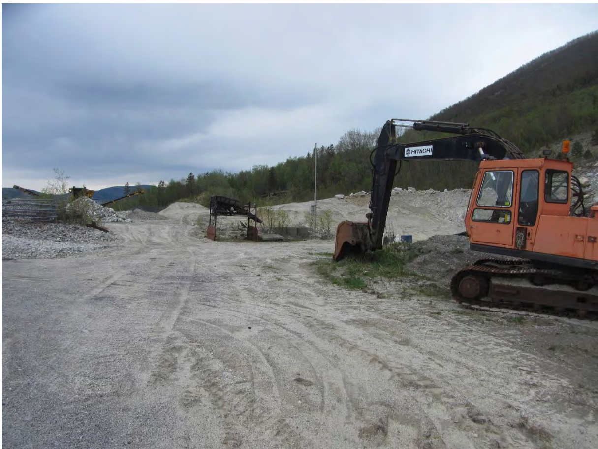
Figur 11: Viser oversiktsbilde over eiendom 100/2.
