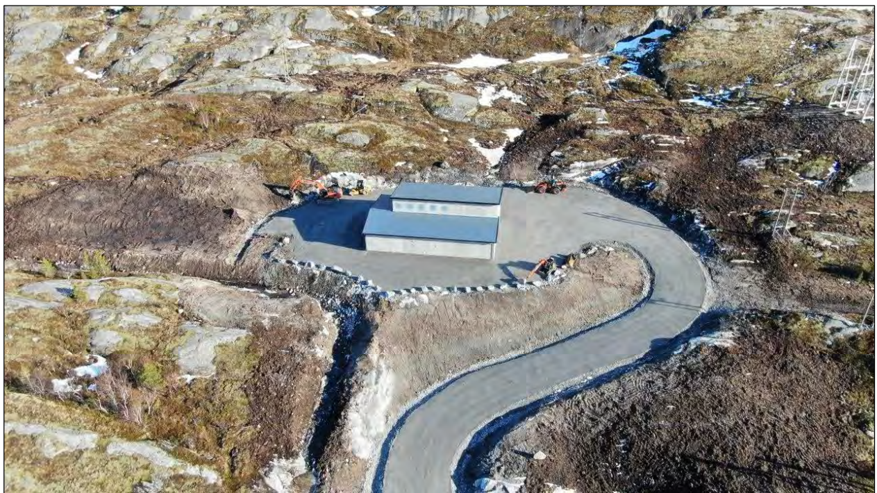
Figur 46: Viser bilde av Kjelling transformatorstasjon 49/19 (Gildeskål kommune) som kan benyttes til vinsj/trommeplass.
