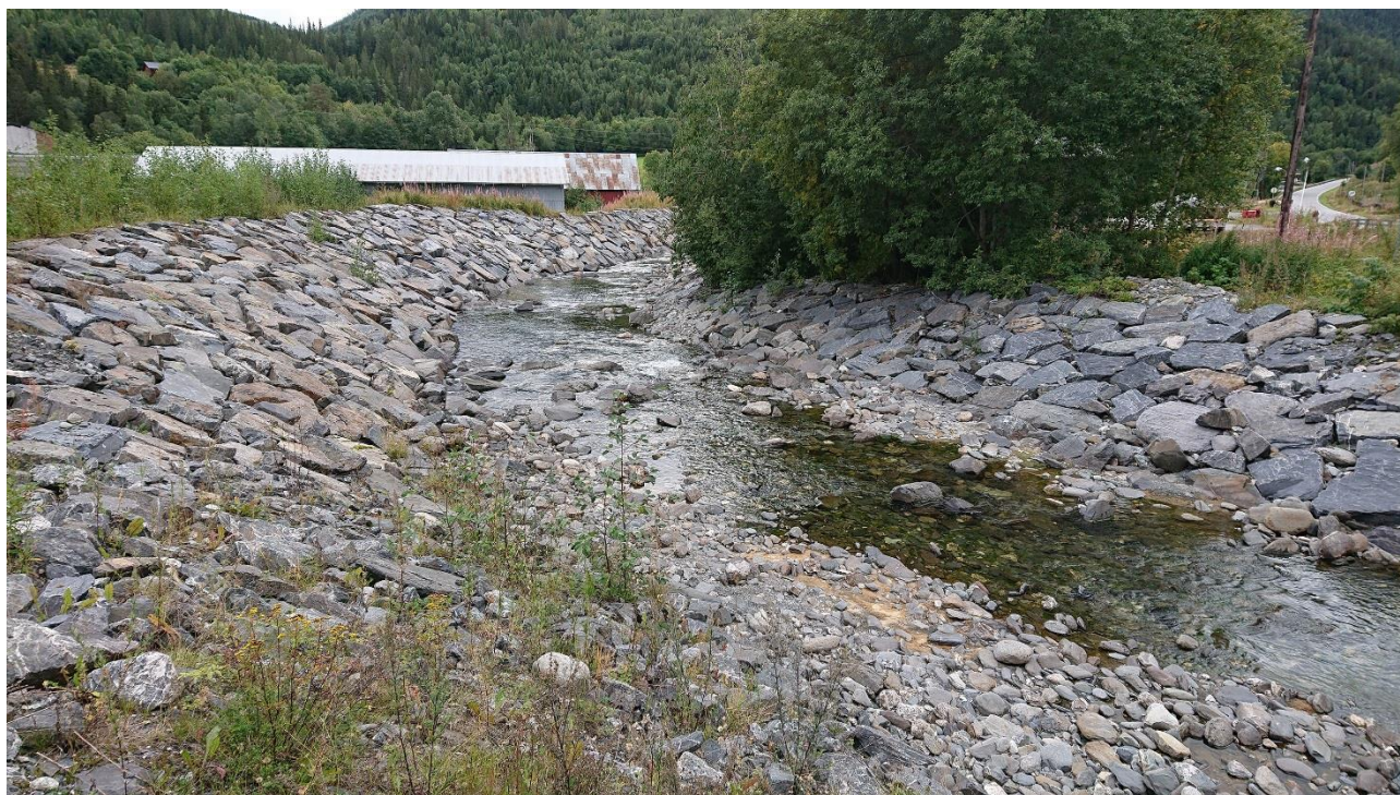
Figur 2. Den nedre delen av Dørja, ned mot utløpet til Jøra, er elva sterkt forbygd med klassisk glatt plastring. Denne form for forbygning anses å være lite gunstig for vannmiljøet da vannhastigheten gjerne blir veldig høy i hele tverrsnittet.
