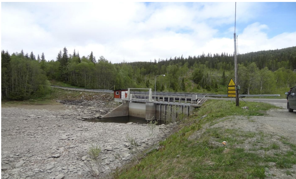
Figur 11: Dam Limingen ved lav vannstand. Foto: NVE
