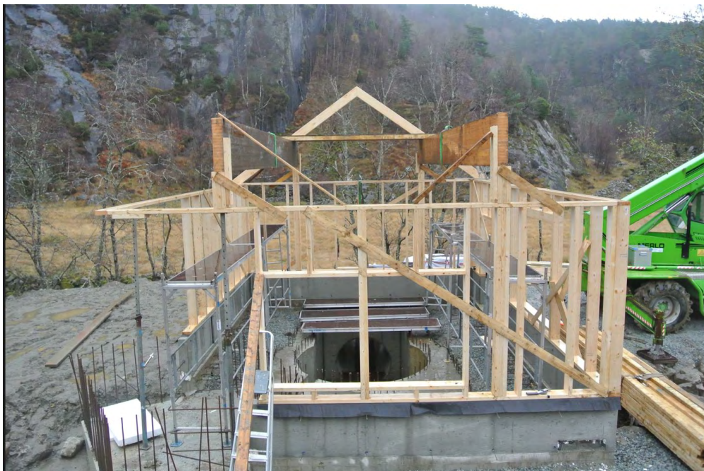
Fig 16. Eks. på en tilsvarende kraftstasjon (her under bygging).
