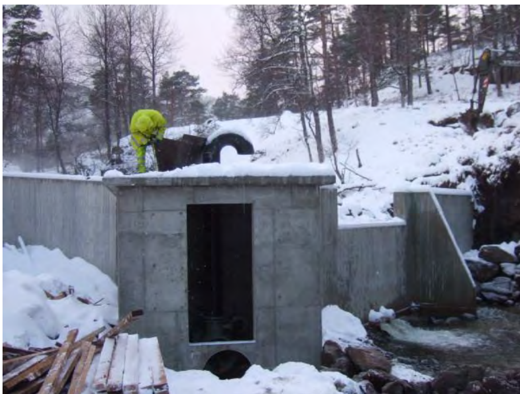
Fig 8. Eks på et inntak under bygging
