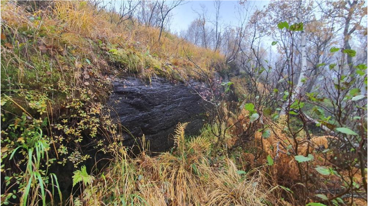
Figur 21: Mindre skrent observert nordvest for kartleggingsområdet. Berget er glatt polert og lite oppsprukket. For aktuell lokalitet er det ikke observert tidligere utfall.
