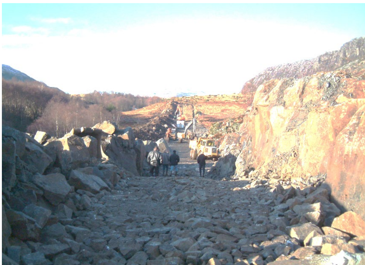
Figur 3Bilde fra byggearbeidet like oppstrøms VP50
