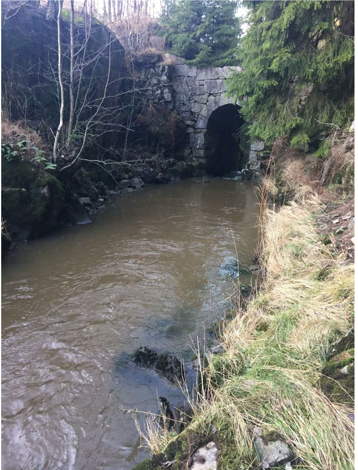
Figur 9 Bro 4. Møllebro krysser Slorabekken (befaring 10.12.2015)
