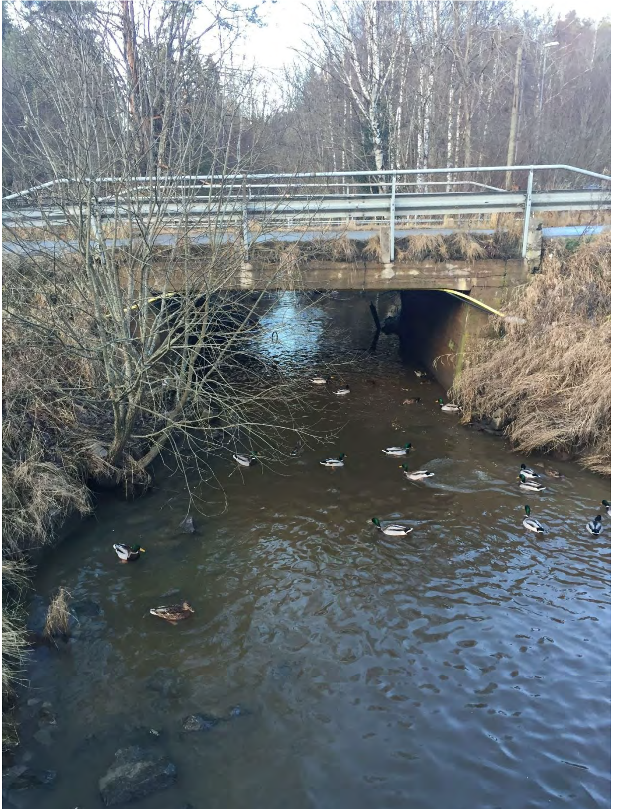
Figur 8 Bro 3. Krysser Slorabekken ved parkeringsplass (befaring 10.12.2015)
