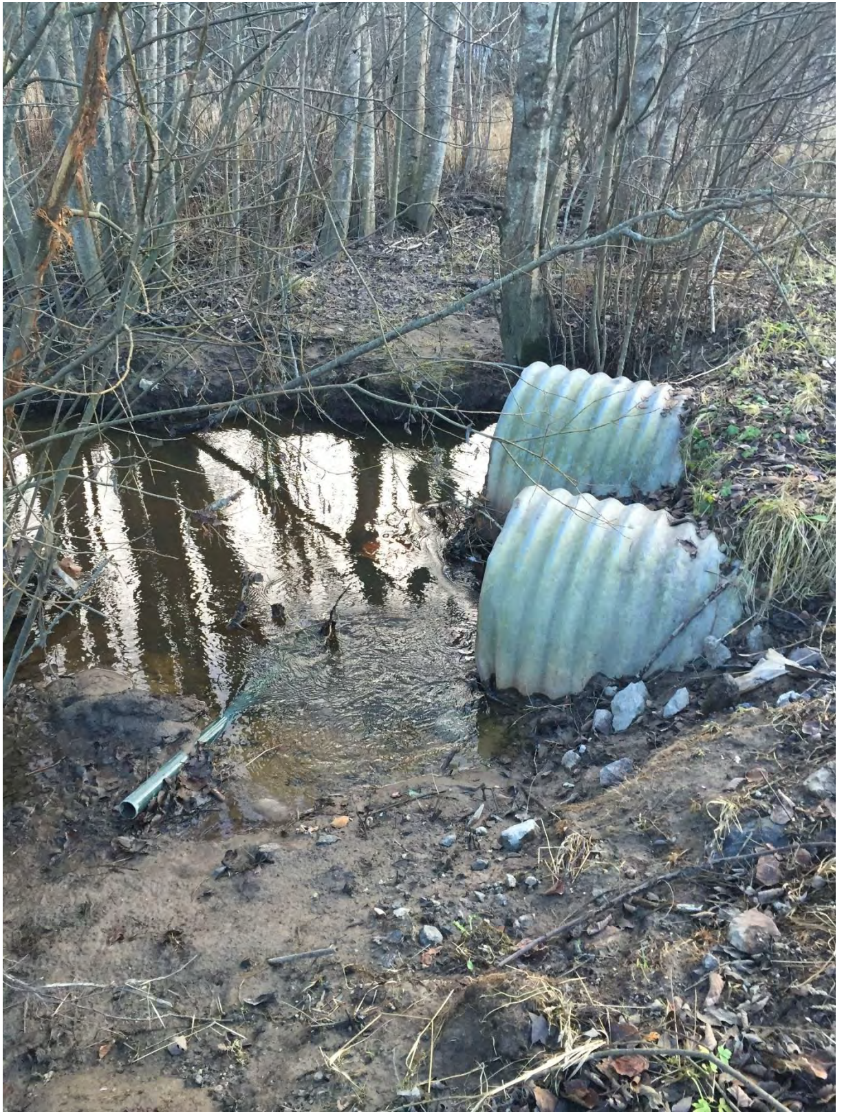
Figur 6 Bro nummer 1 viser to kulverter (befaring 10.12.2015)
