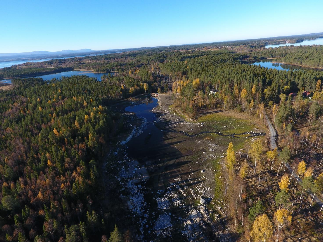
Figur 7. Bildet fra Ävjandammen viser fremspring av vegetasjon på blottlagte løsmasser i kantsonen i samme sesong som nedtapping. Foto: Norconsult Sverige.
