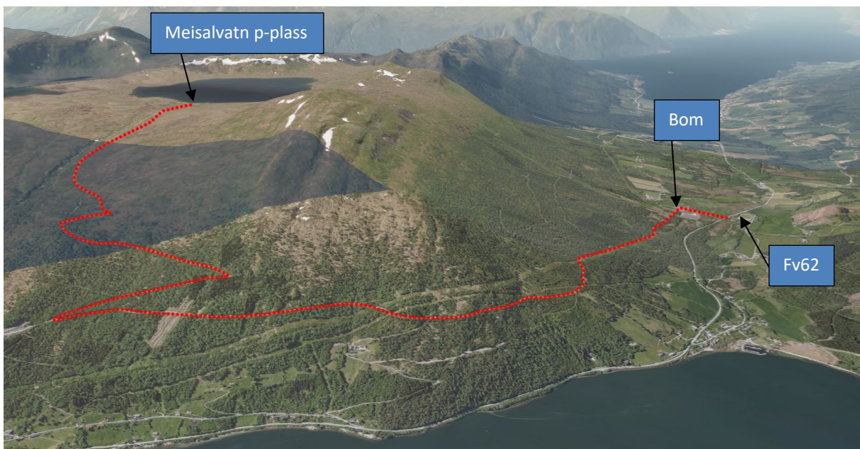
Figur 2-4 Illustrasjonsbildet av adkomstvei fra Fv62 til p-plass ved Meisalvatn dam.
