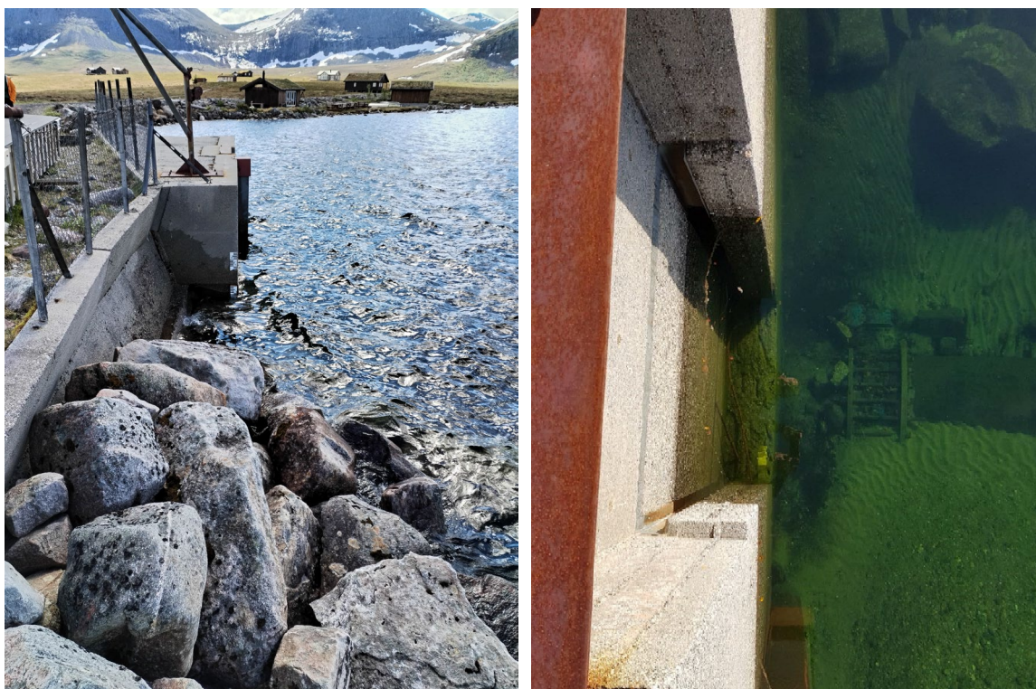
Figur 2-7 Viser inntak i betong til venstre og inntaksrør inn i reservoaret til høyre.
