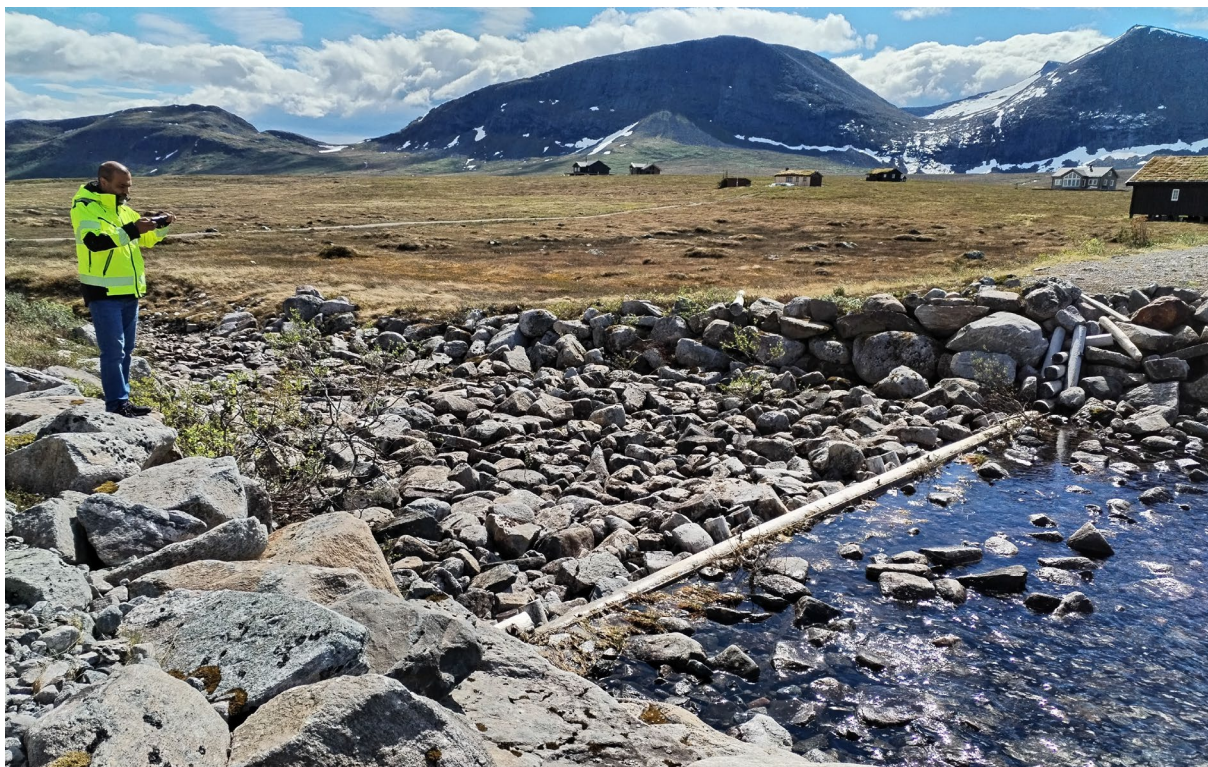
Figur 2-6 Viser flomløpskanal og overløpsterskel i tre.
