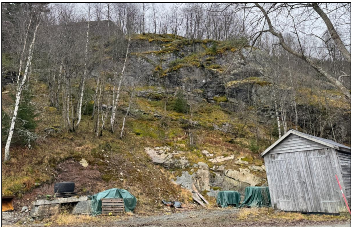
Figur 5: Berget i en skråning sør for kartleggingsområdet, sett mot sørøst. Det finnes sprekker med fall ut langs skråningen, men berget fremstår likevel som ganske massivt og sprekkene virker ikke veldig gjennomgående.
