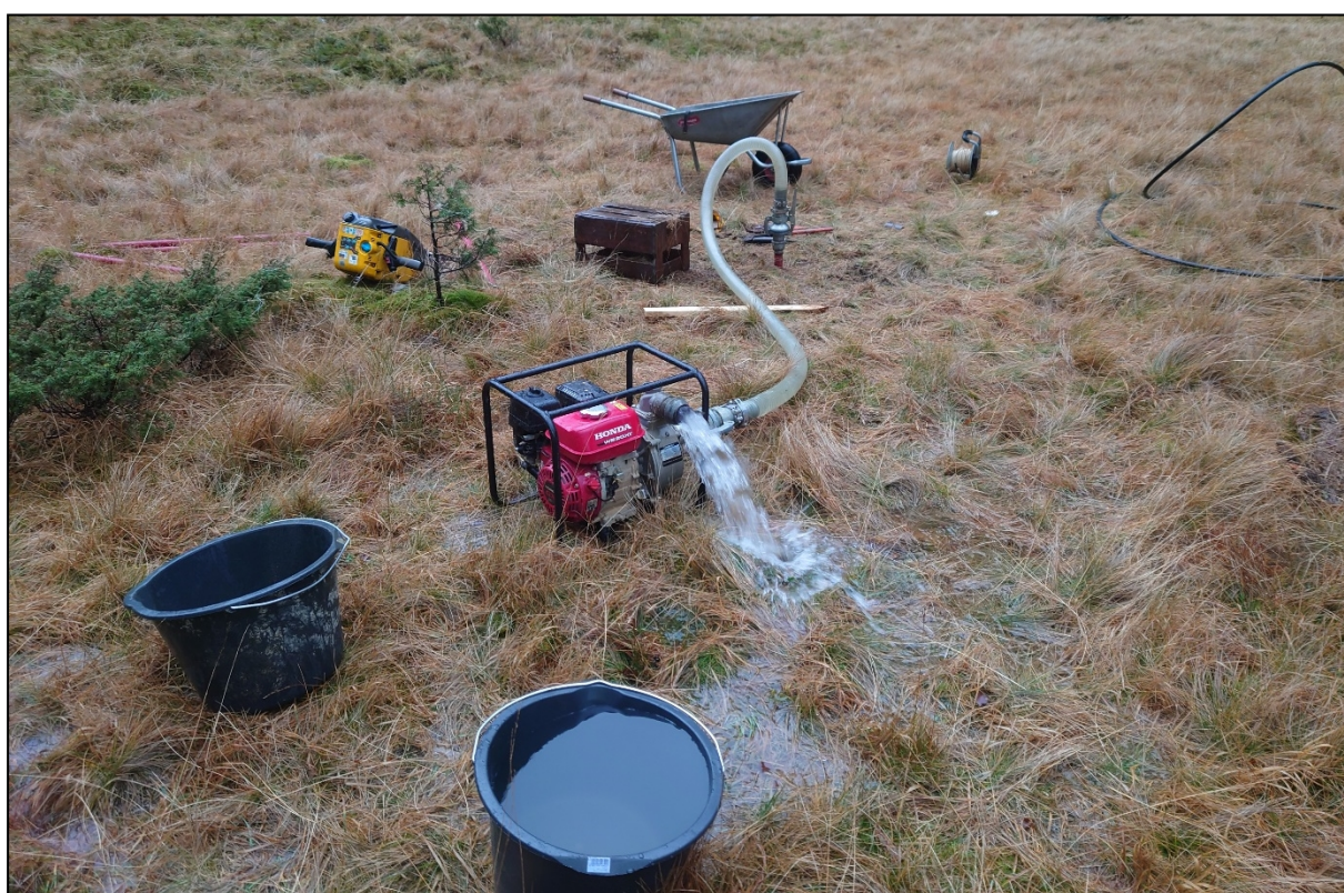
Figur 24. Testpumping av 5/4" undersøkelsesbrønn-1. Uttak av 4 l/s med slisset spiss i nivå 6-7,5 meter.
