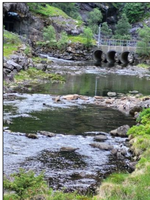
Figur 2-33. Foto fra 21.05.24 mot utløp kraftstasjon til venstre og elveløpet til høyre (Foto: G. Molland)
