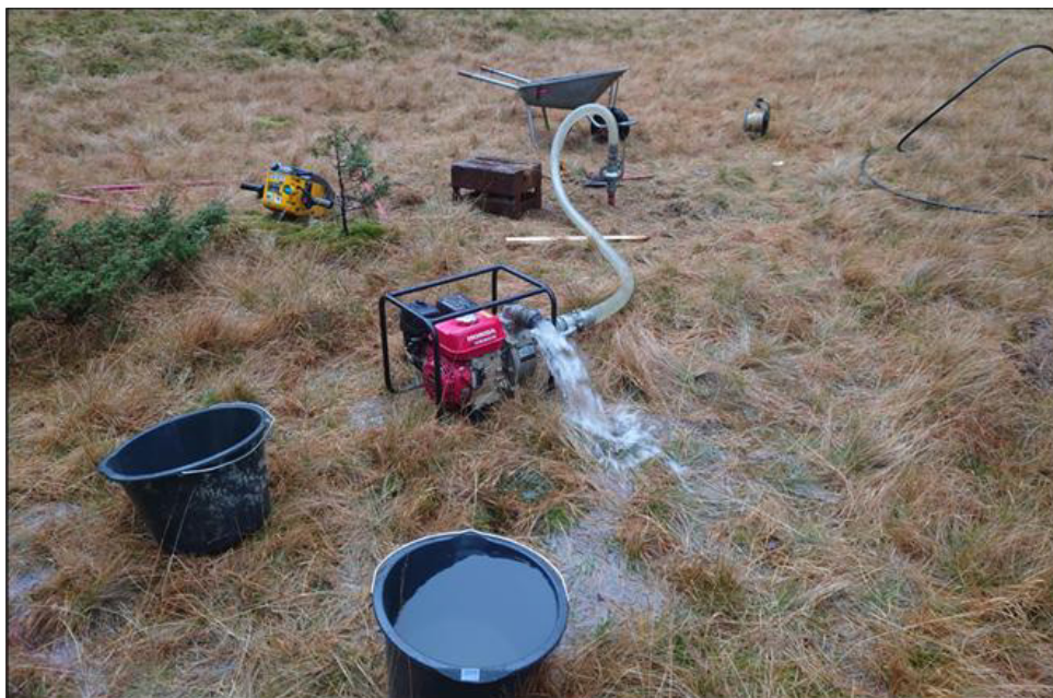
Figur 2-10. Testpumping av Ub-1. Uttak av 4 l/s med slisset spiss i nivå 7,5-9 meter (Asplan Viak nov-21).
