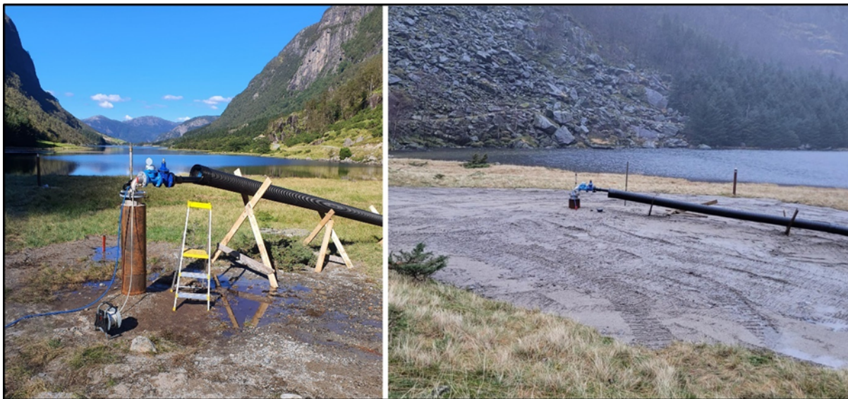
Figur 2-25. Venstre: B2 før oppfylling (Topp 1,5m o/ terreng). Høyre: B2 etter oppfylling (0,44m o/ nytt terreng).
