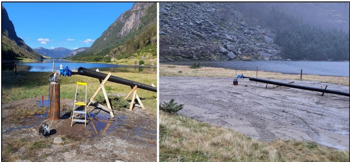
Figur 2-4. Venstre: B2 før oppfylling (Topp 1,5m o/ terreng). Høyre: B2 etter oppfylling (0,44m o/ nytt terreng).
