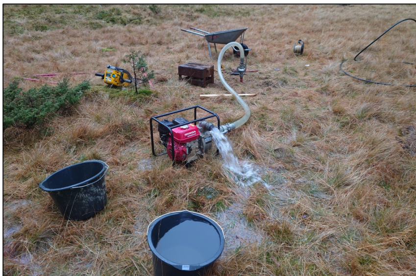
Figur 2-5. Testpumping av Ub-1. Uttak av 4 l/s med slisset spiss i nivå 7,5-9 meter (Asplan Viak nov-21)
