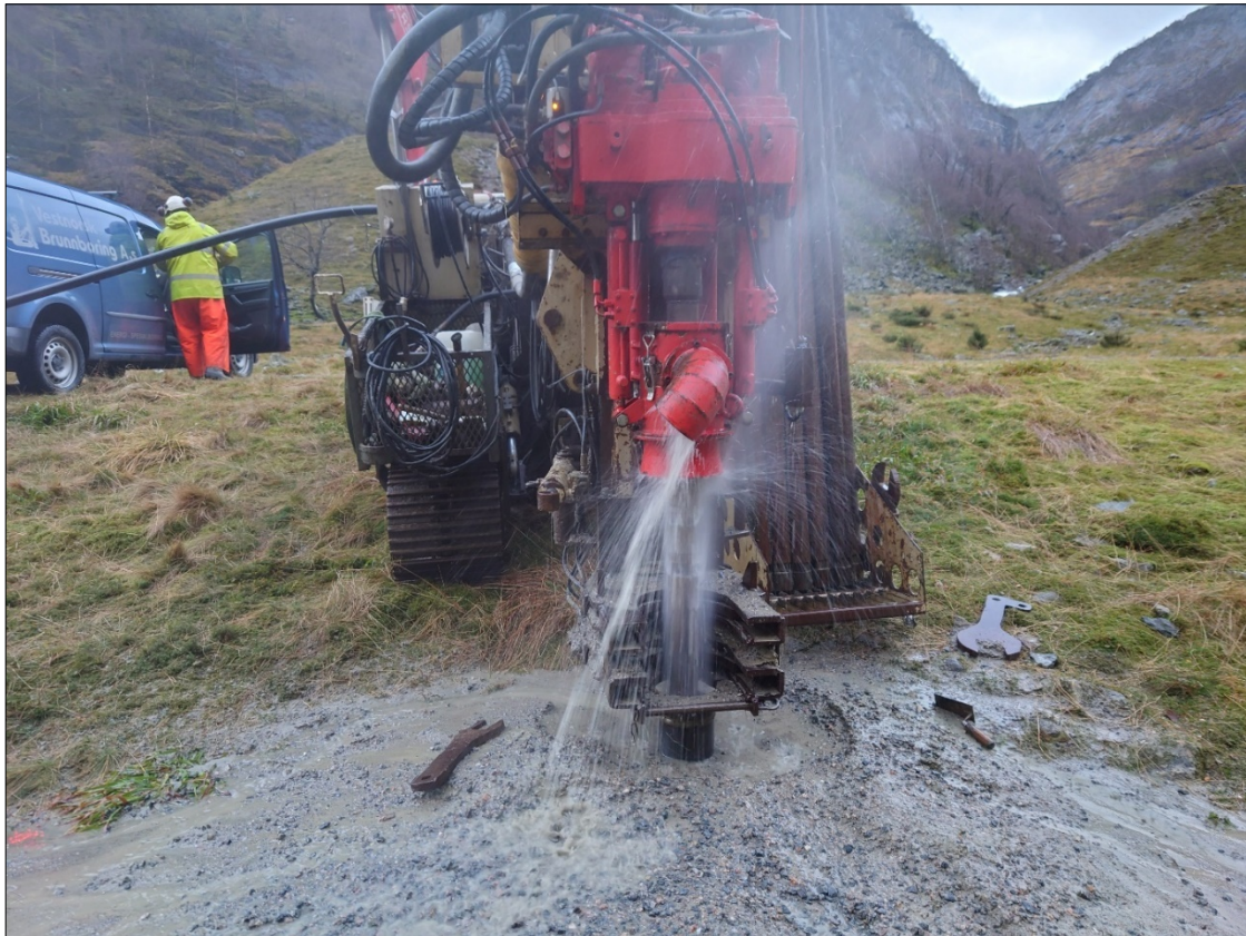
Figur 27. Uttak av grunnvannsprøve fra 18 meters dyp under boring av Odex-A.
