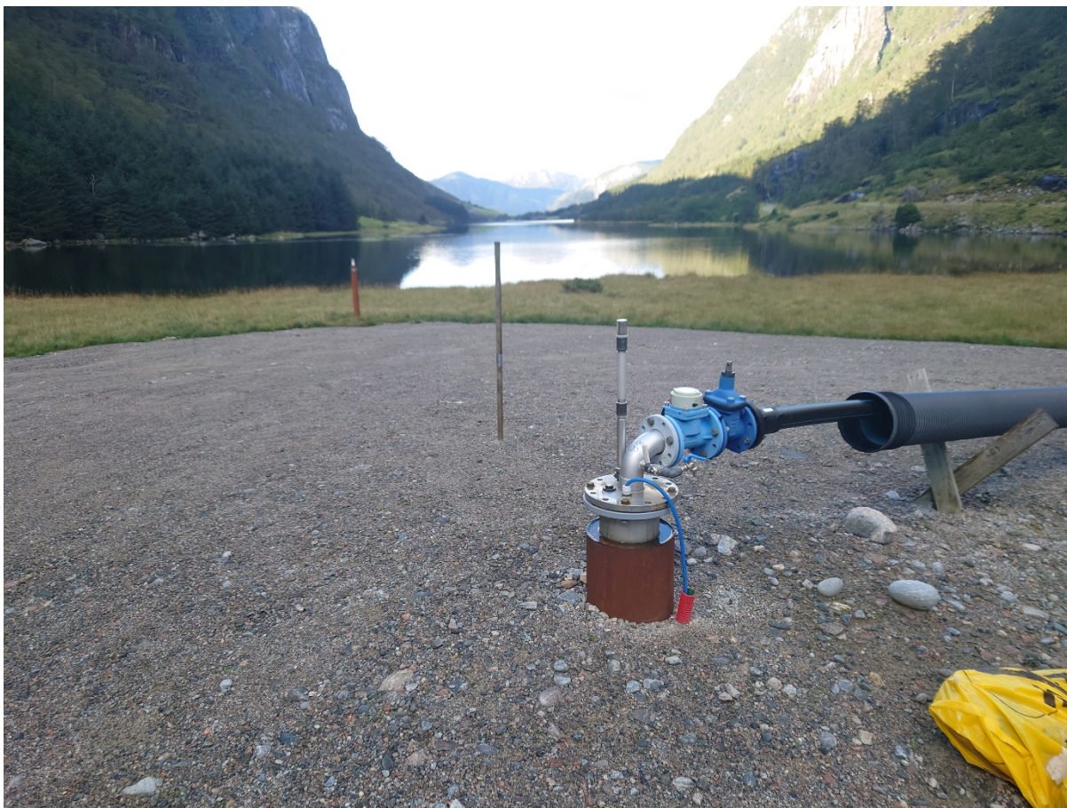
Figur 2-26. Sikring av B2 med tilkjørte sandmasser og lufting 0,5m høyere enn brønntopp.
