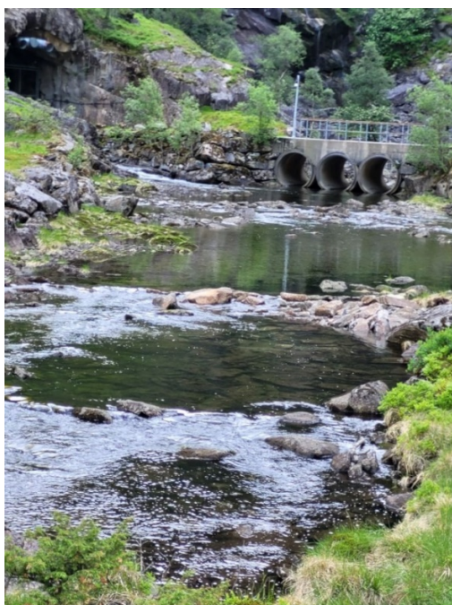
Figur 2-12. Foto fra 21.05.25 mot utløp kraftstasjon til venstre og elveløpet til høyre (Foto: G. Molland)
