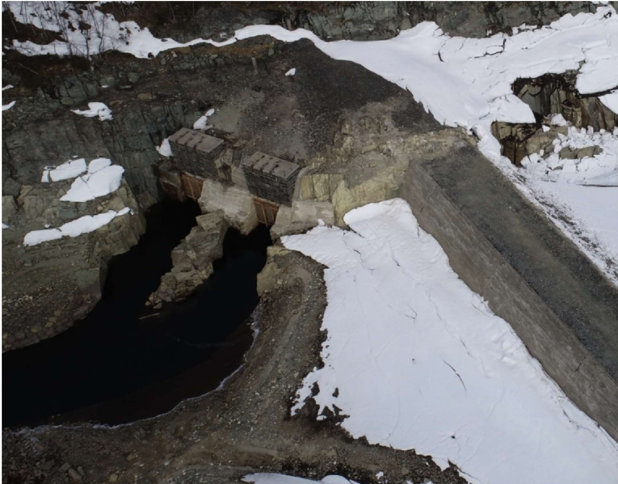
DRONEBILDE AV DAGENS SITUASJON. BILDET ER TATT 14. MAI 2020 VED VANNSTAND KOTE 900,55 moh.
