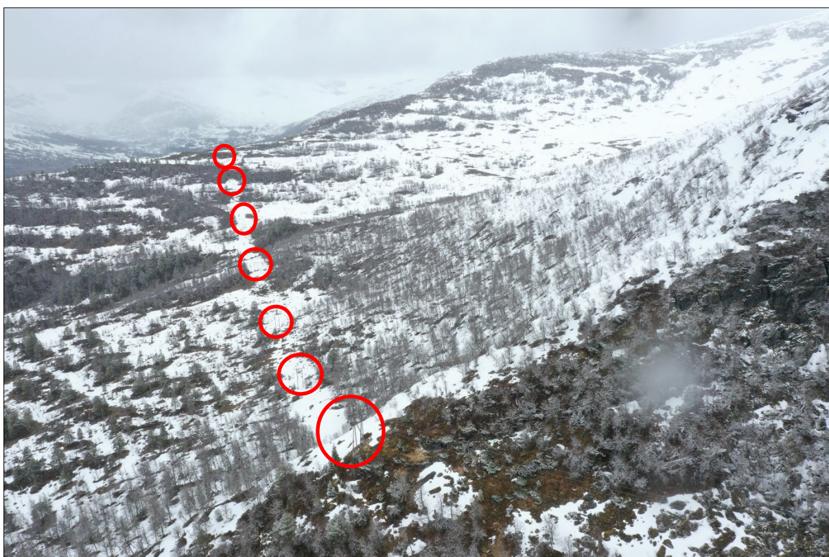
Figur 42: Dronebilde av mastepunkt M58 – M64, med M58 på ryggen nærast i bildet
