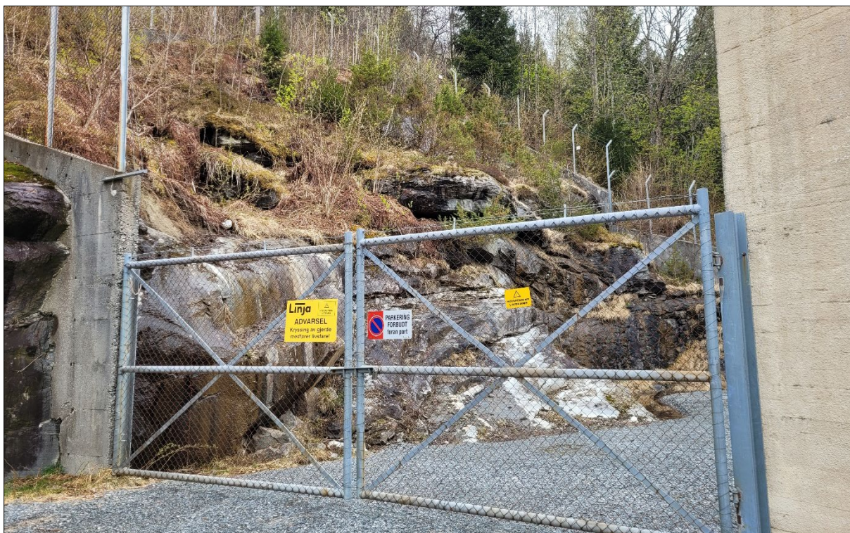
Figur 27: Skjering og små knausar over eksisterande stasjon på Bø. Ingen losneområde for skred med skadepotensiale i skråninga ovanfor. Infopunkt 1.
