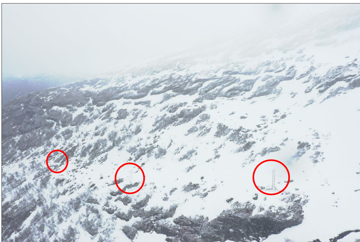
Figur 36: Dronebilde av mastepunkt M51, M52 og M53 frå høgre mot venstre.
