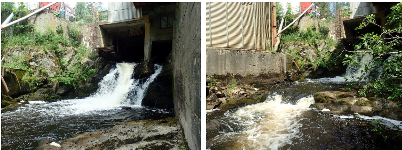
Figur 8. Hovedløpet slik det er i dag med vannet strømmende ut av opprinnelig kanal under møllebygget og ned i en stor kulp i fjellet. Bildene viser fra venstre utløpet av kanalen og grunnmuren i kjelleren der vannet vil komme ut i et rør gjennom veggen; og enten bøyes ned i kulpen eller «dempes» mot fjellet på motsatt side. Bildet til høyre viser utløpet av den naturlige kulpen der strykepartiet begynner. Foto: Kjell Sandaas 2020.
