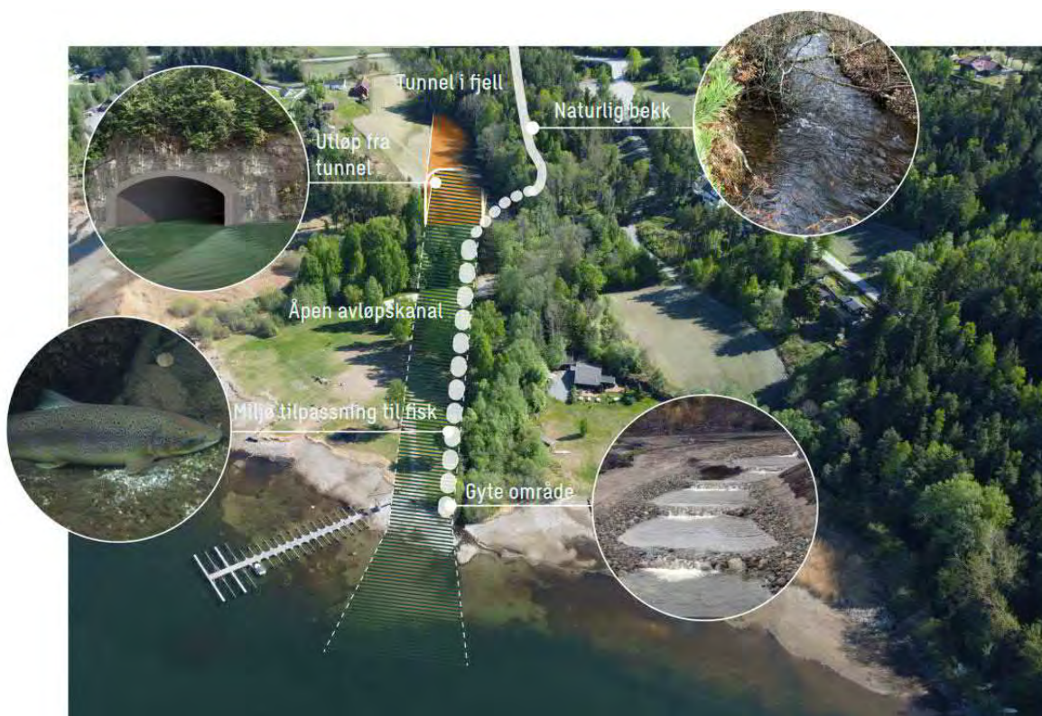
Figur 4-6 Utløpstunnelen og åpen kanal
