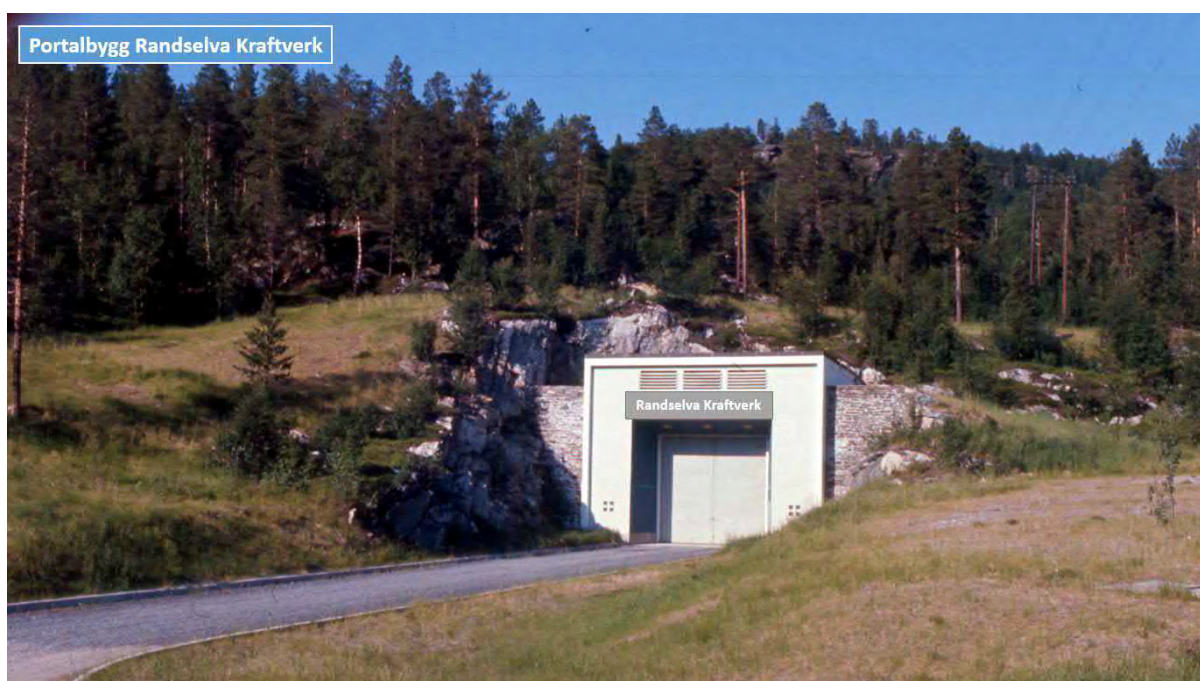
Figur 4-5 Eksempel på portalbygg
