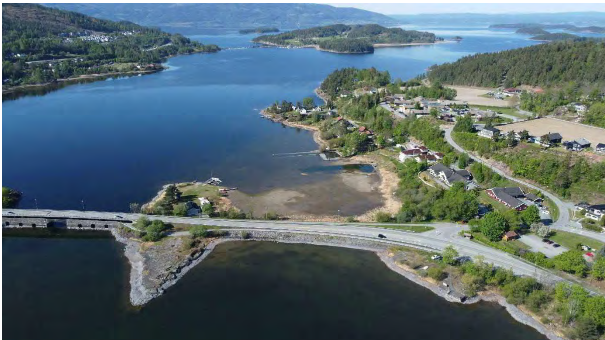
Figur 4-8 Dagens vei over Krosund går på en fylling, som vist i dette bildet. Ved utbygging av Randselva kraftverk vil fyllingen åpnes opp og veien krysse med bru.
