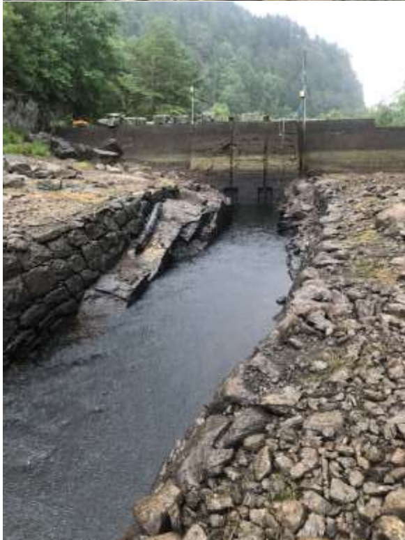
Lukekanal sett mot dammen. Vannstand=LRV=101,50
