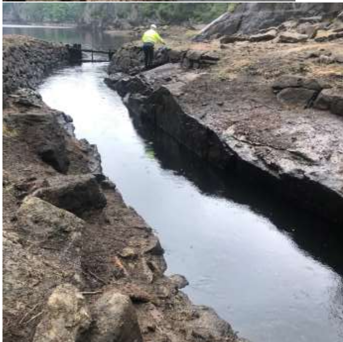
Lukekanal sett mot magasin(rester av gammelt bjelkestengsel fra 1901 kan sees) - Vannstand er LRV=101,50
