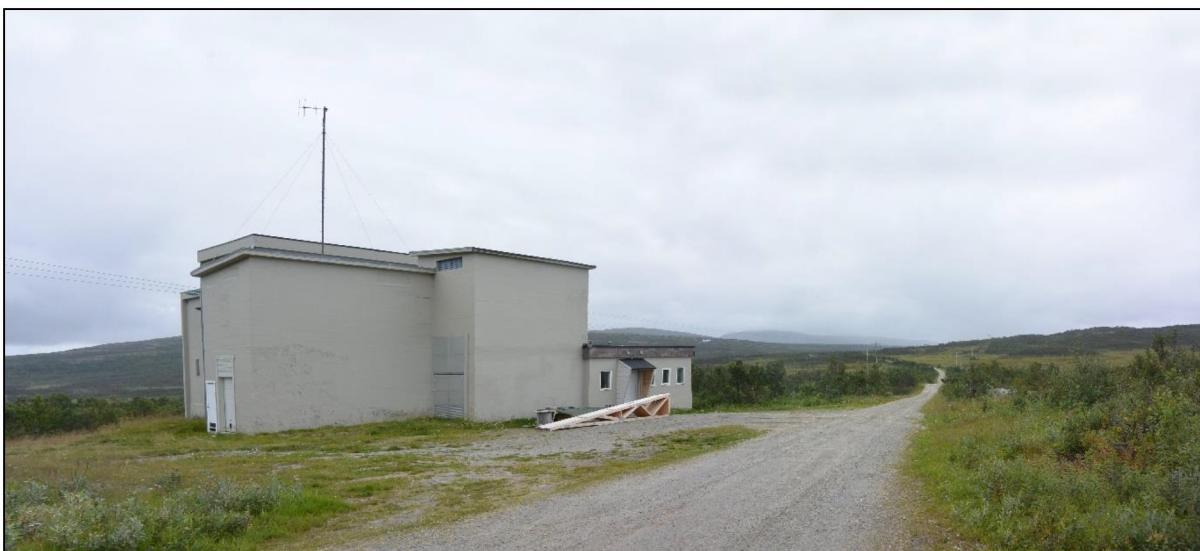
Figur 4-32. Smørffjord transformatorstasjon før utvidelse.
