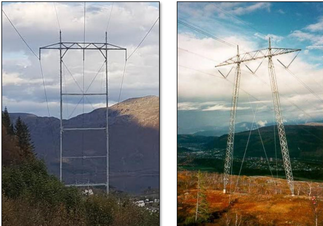
Figur 2-2. Bilder av aktuelle mastetyper, til venstre selvbærende stålmast, til høyre utvendig bardunert mast (M-mast).
