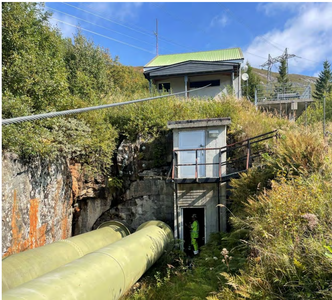
Figur 4-10 Tunnelinnslag/rørbruddskammer ved Nova (Pålugg tunnel)
