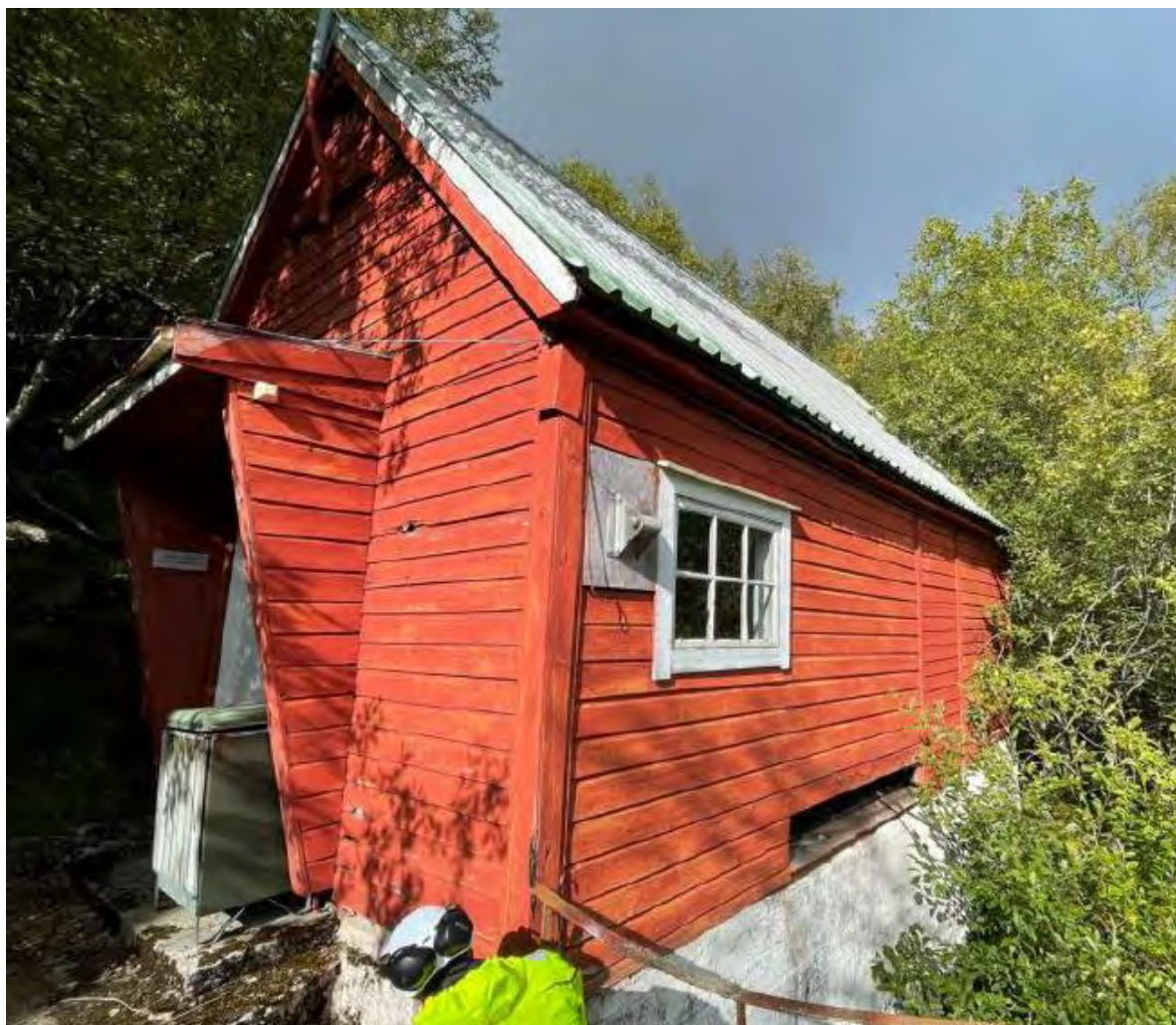
Figur 3-3. Spillverkshuset ved K1
