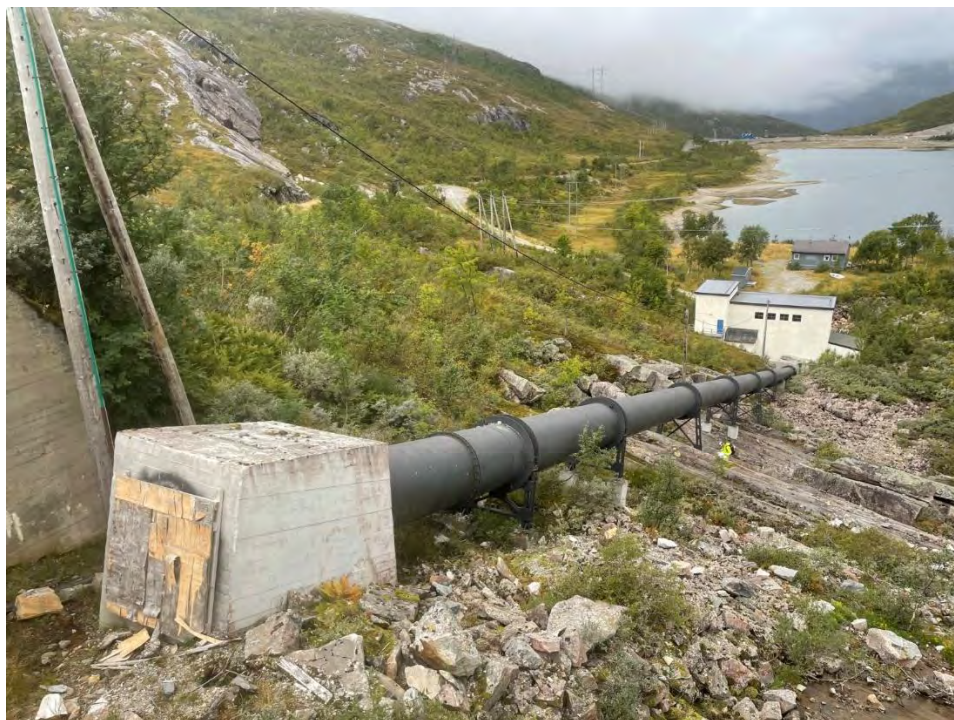
Figur 5-4. K3 Rørgate. Roesvatnet kan sees i bakgrunnen.
