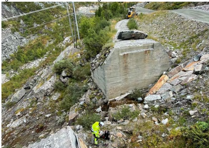
Figur 5-5. Brukar fjernes. Det er lett adkomst med gravemaskin på eksisterende vei.
