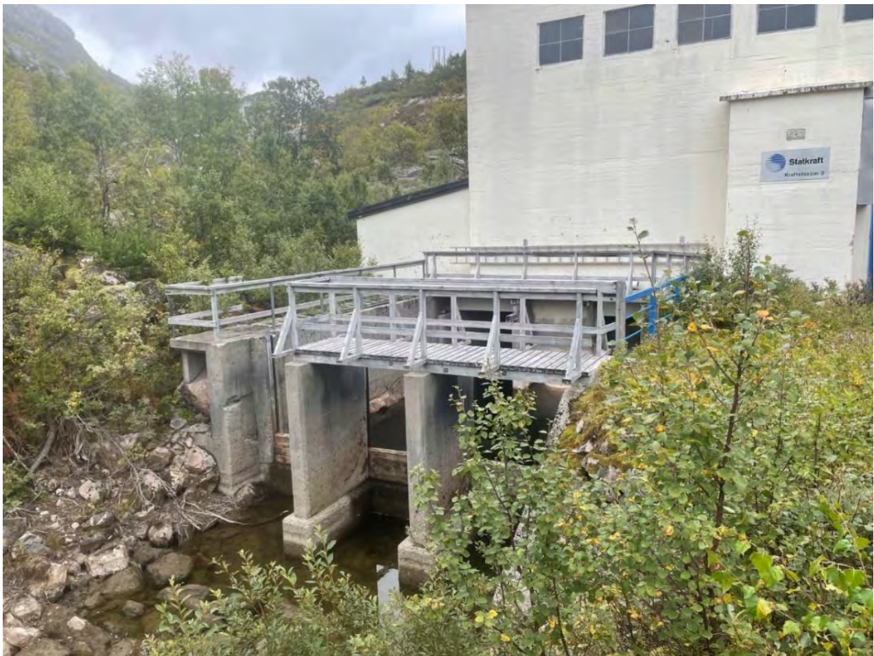
Figur 5-2. Utløpskanal fylles igjen med rene masser
