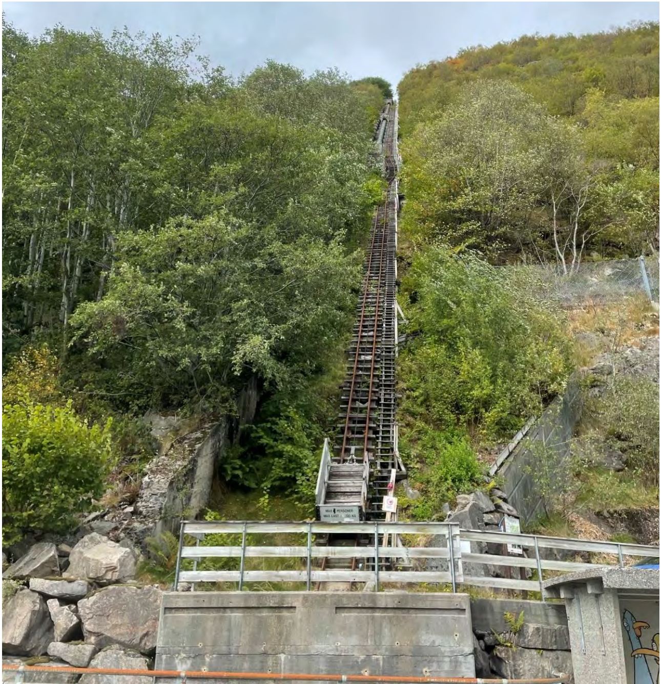
Figur 3-2 Trallebana fra Rv 55 ved Høyanger
