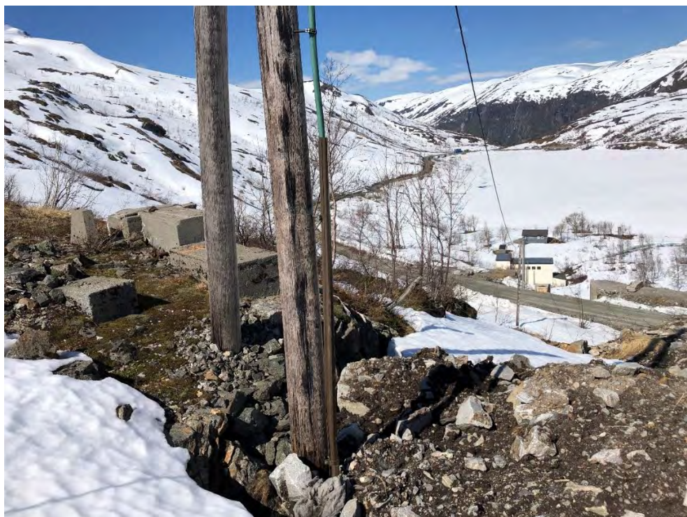
Figur 5-6. Fundament ved lekkasjemålehus.
