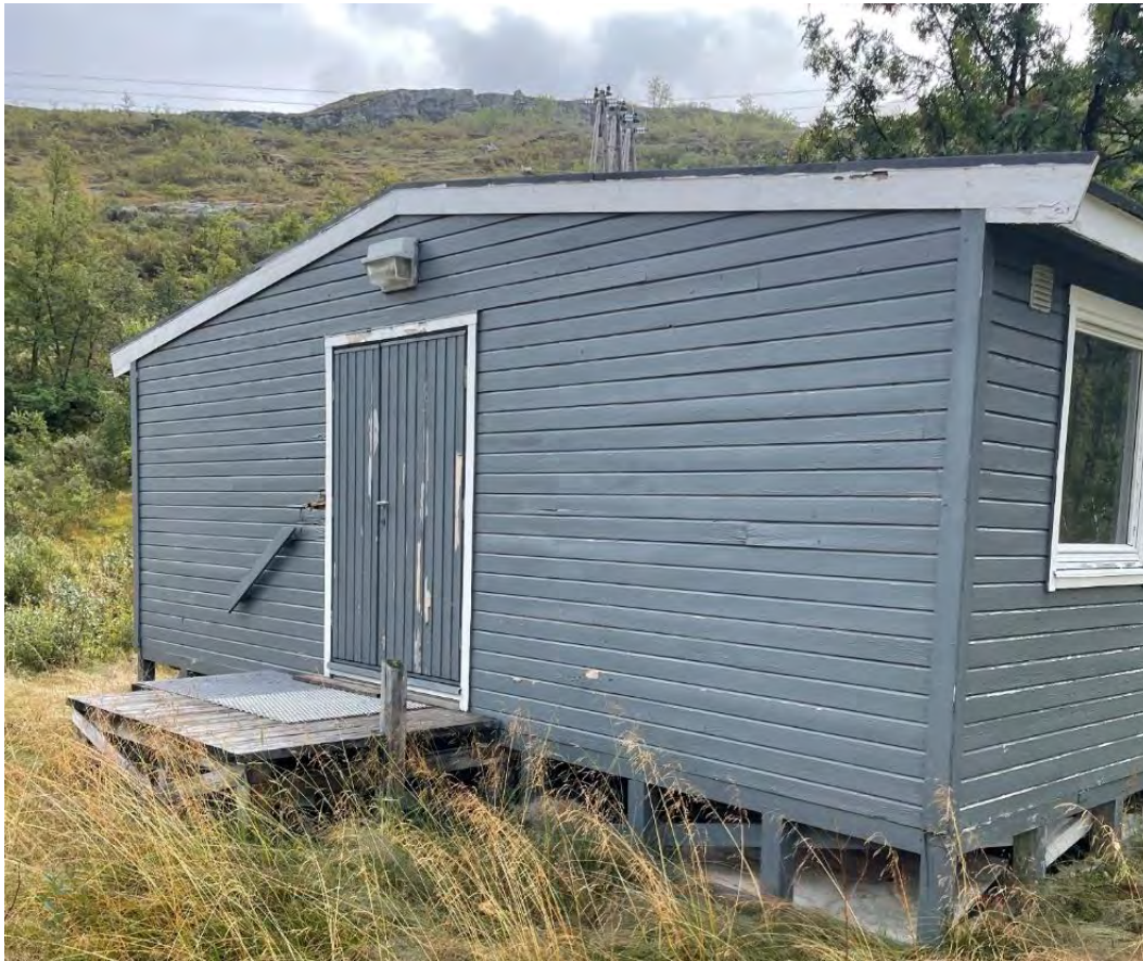
Figur 5-3. Enkel brakke ved K3 som skal rives
