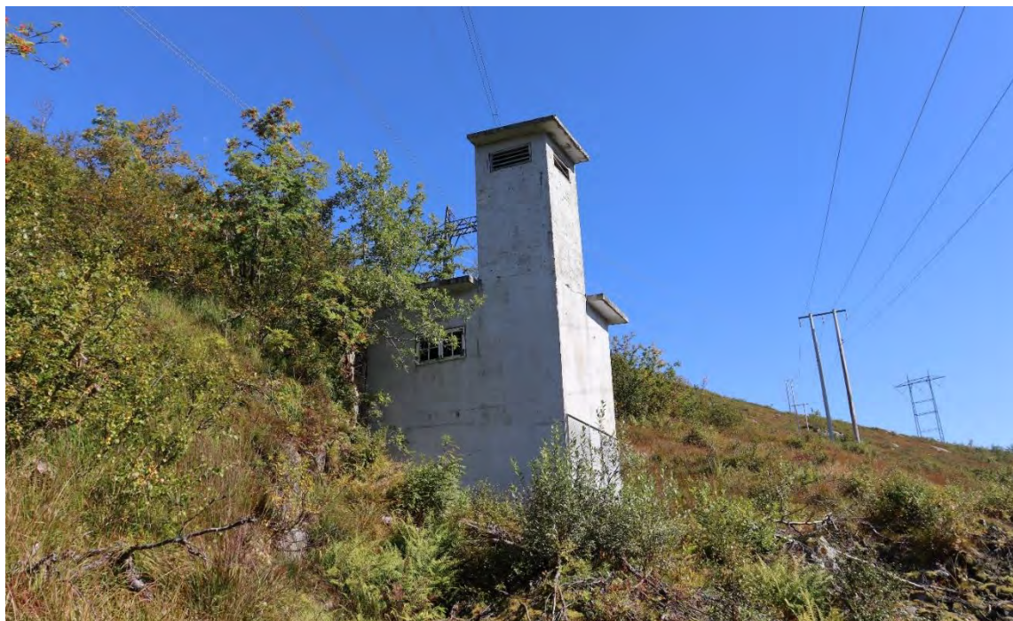
Figur 4-5 Svingkammerhus/luftesjakt
