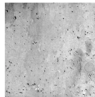
Fasade Alternativ 1: Betongelement (Ubehandlet)
