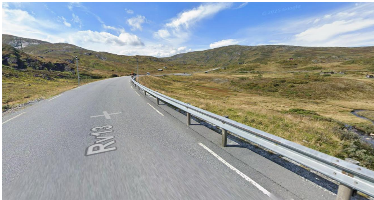
Figur 4-14 Trekpassasje for villrein over Rv13 ved Hestavollen sett mot sør. Målsetvatn ligger til høyre utenfor bildet. Tiltaksområdet er lokalisert midt i bildet. Foto er hentet fra Google Street View, og er tatt i august 2025.
