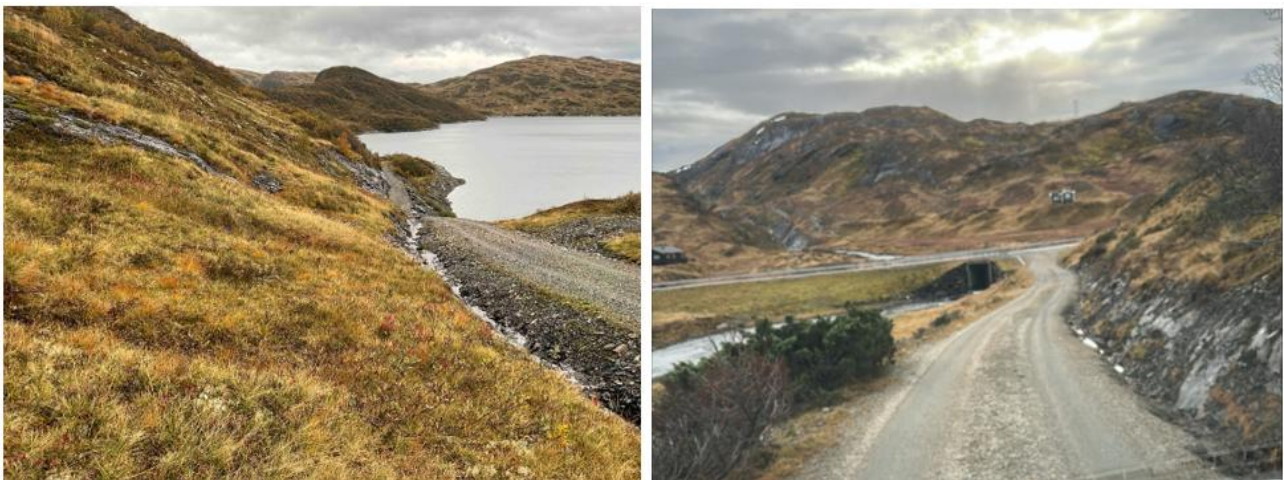
Figur 3-2: Venstre: Bildet viser eksisterende anleggsvei langs Målsetvatn mot nord. Høyre: Bilde tatt mot Rv13 sett fra eksisterende anleggsvei nord for riksveien.
