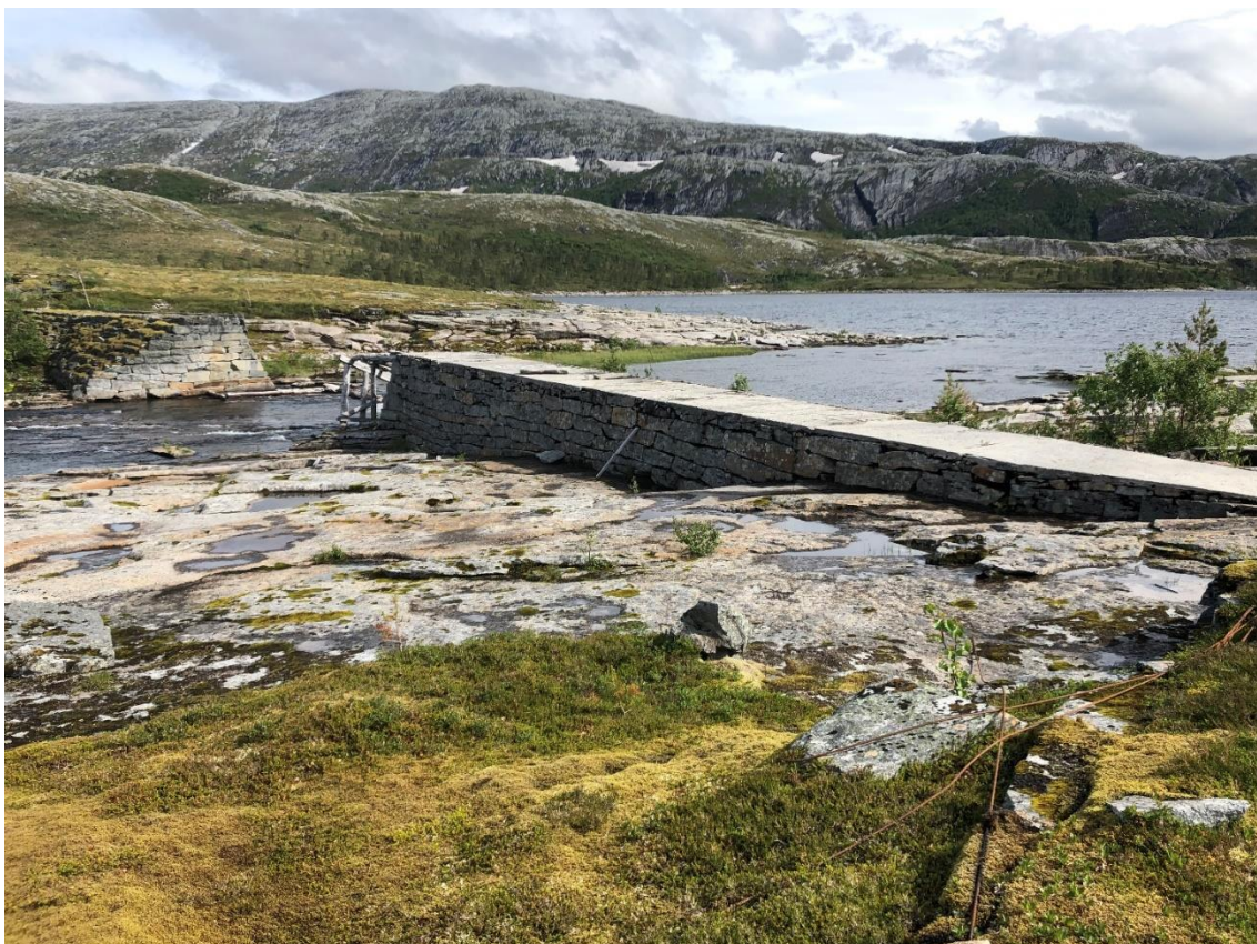
Dam Mellavatnet. Nedstrøms side.
