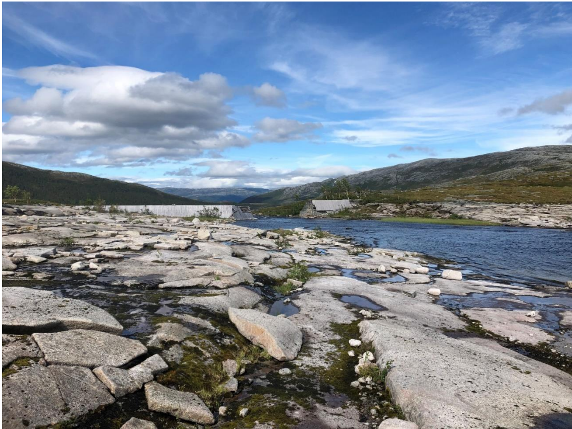
Dam Mellavatnet oppstrøms side med deler av magasinområde.
