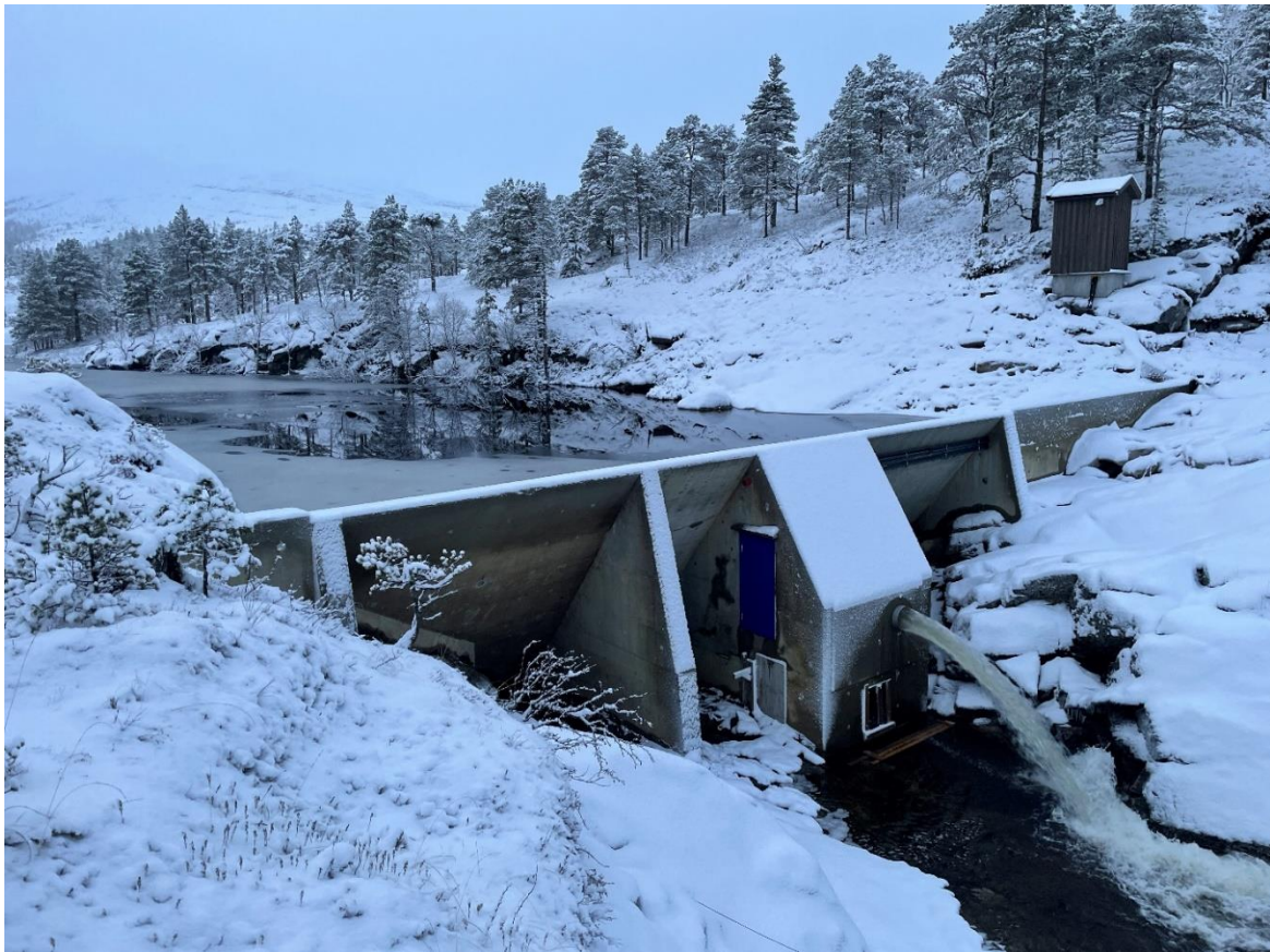
Dam Nervatnet, tilknyttet Hellifossen kraftverk
