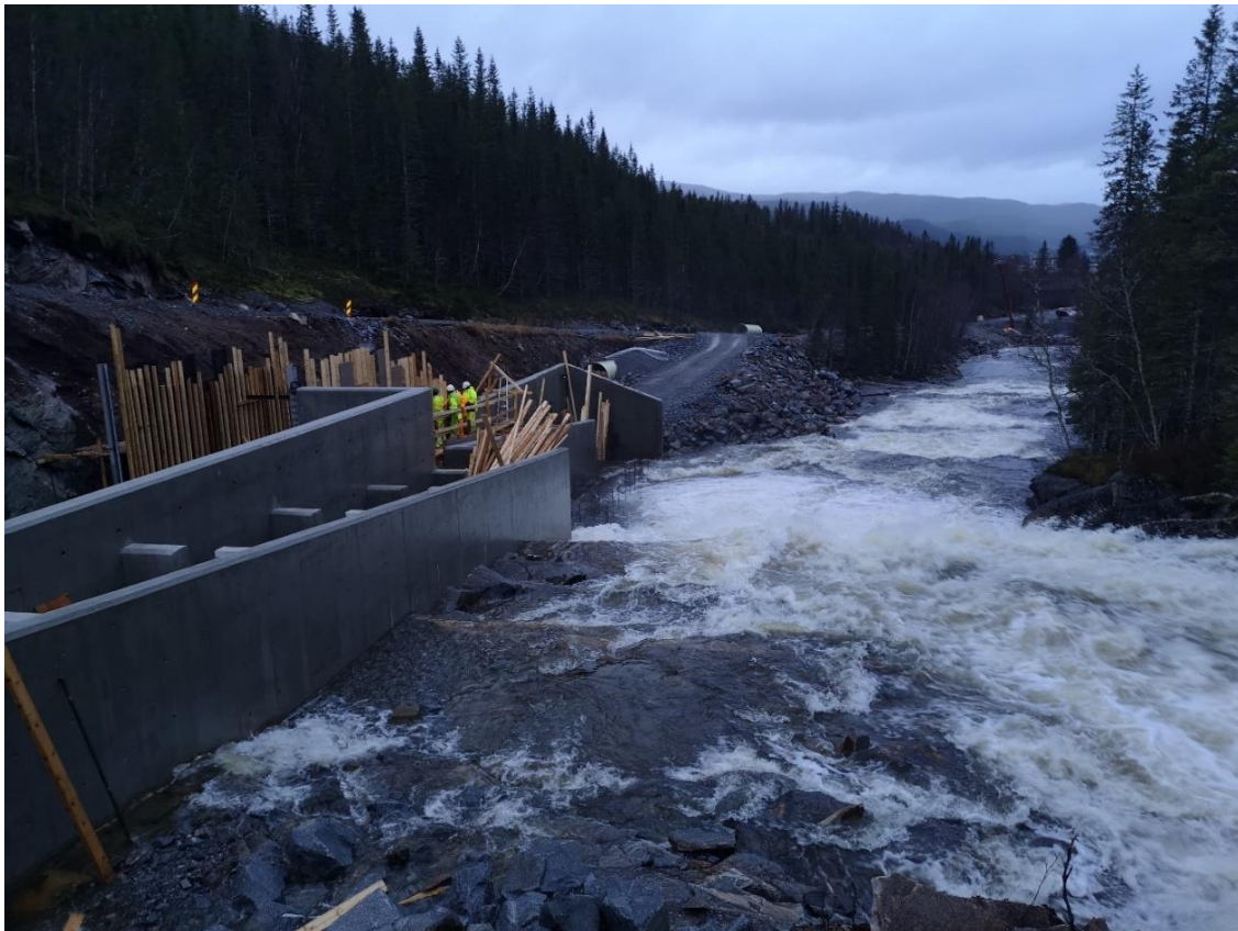
Figur 1-5 Fisketrapp og inntaksdam Kvernhusfossen kraftverk under bygging
