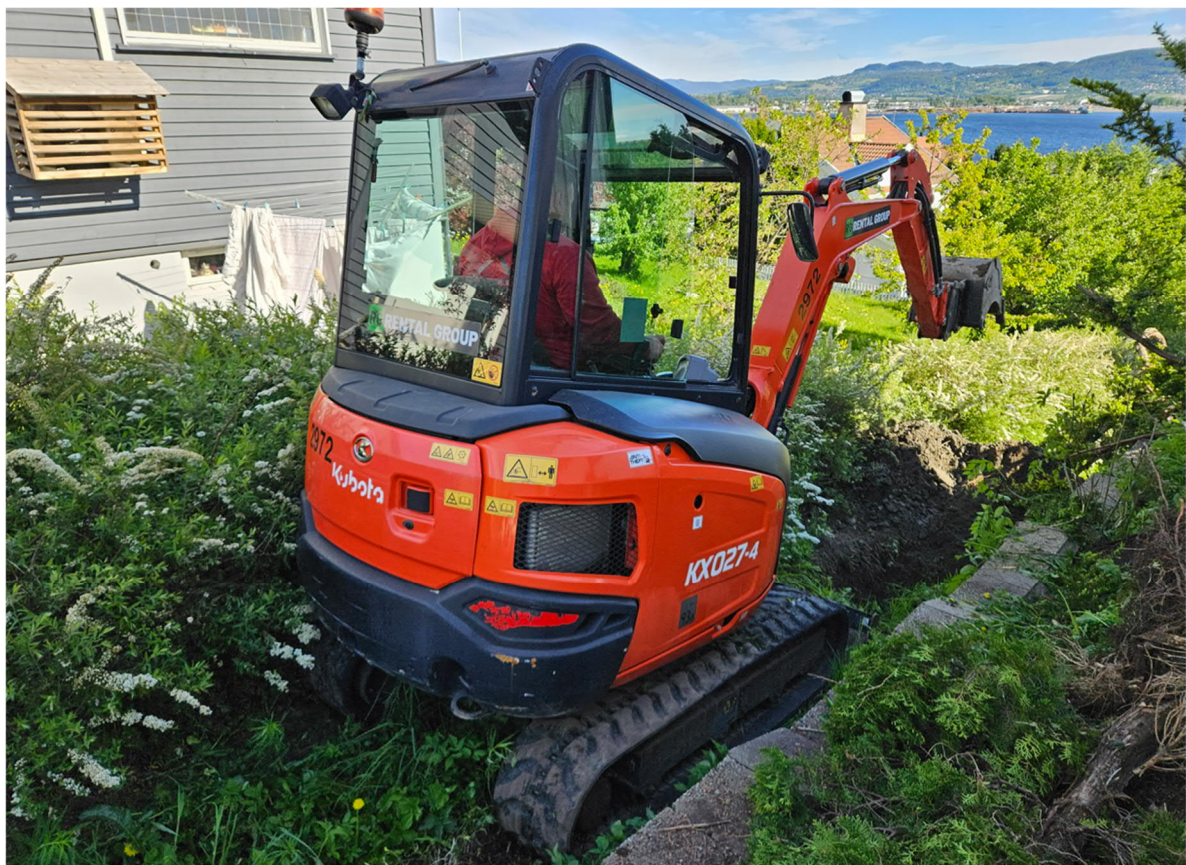
Bilde av gravemaskinen som ble brukt
