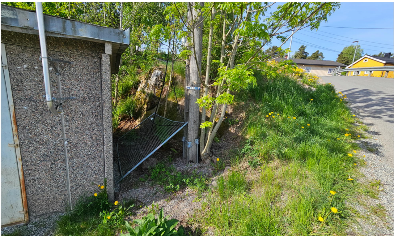
Berg i dagen bak trafostasjonen ved lekeplassen (Iversbakken 5) som antas å være et antatt gammelt steinbrudd.
