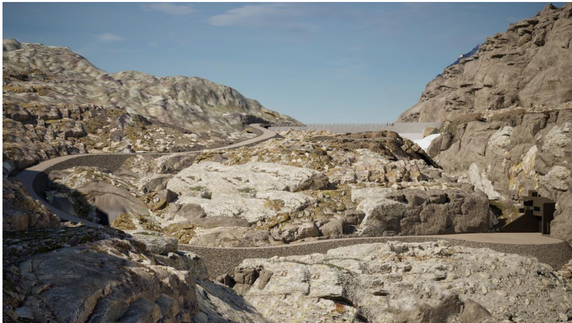
Figur 1-4: Portalkonstruksjon for adkomst til pumpehallen.
