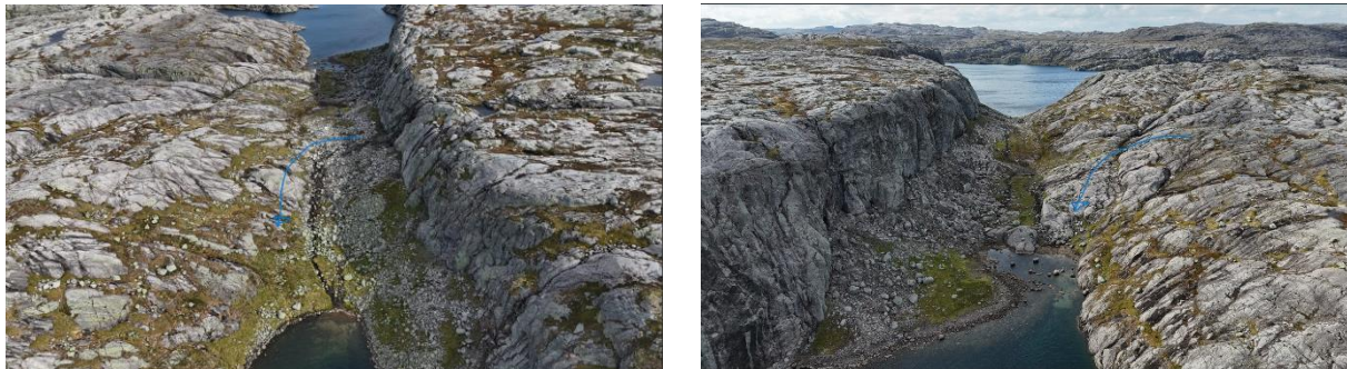
Figur 3-7: Bilder av start- og mottaksgrop til overføringstunnel K41. Blå piler indikerer ca. plassering. Bildene er tatt fra hver sin ende. Venstre bilde tatt fra sørvest mot nordøst.
