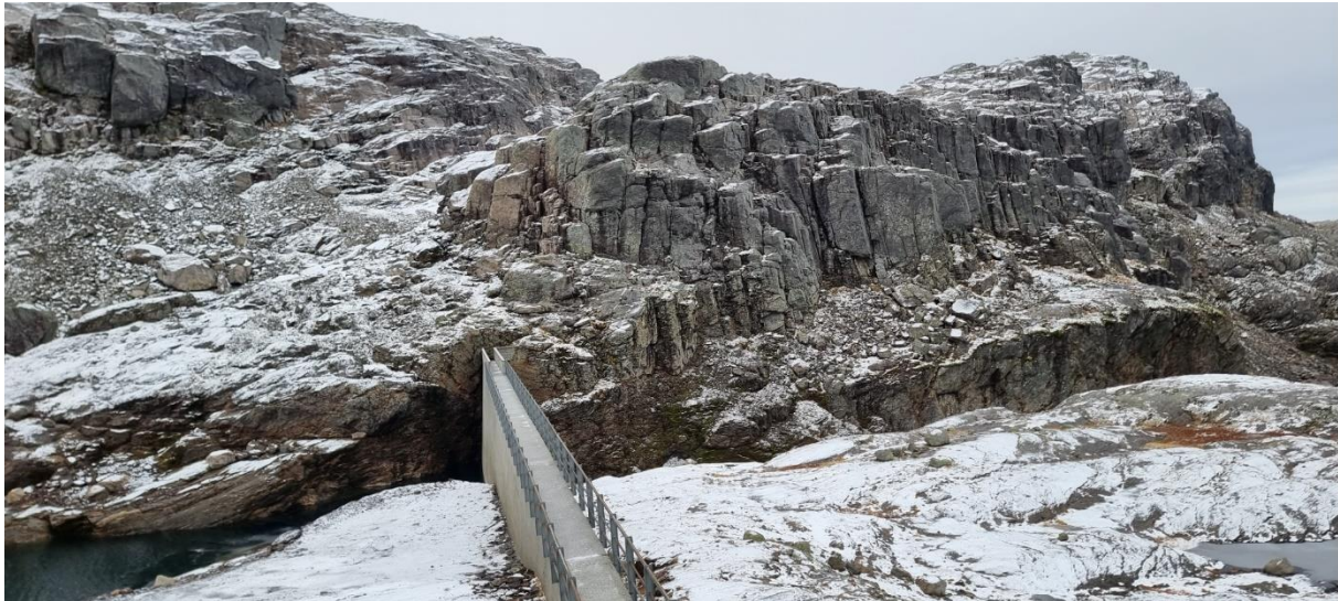
Figur 3-1: Oversiktsbilde mot skrentrekkene over påhugget ved portalbygget.
