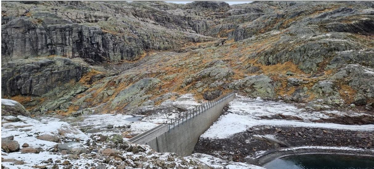
Vedlegg 5: Gilavassdammen sett fra sør mot nord. Adkomstveg kommer på bortsiden av eksisterende demning.
