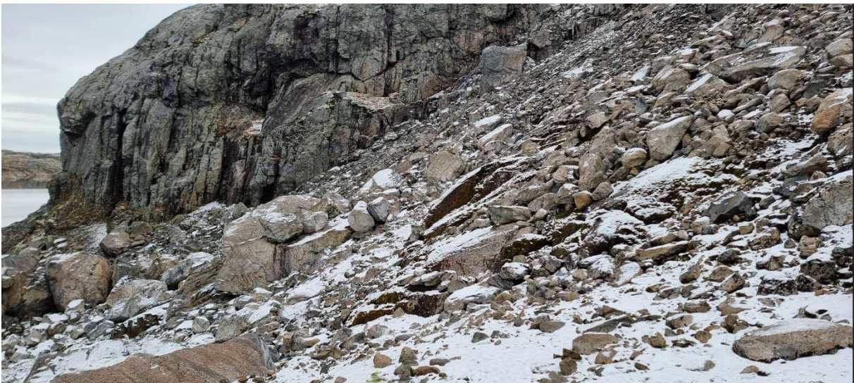
Vedlegg 8: Urmasser og skrent ovenfor planlagt utløpskonstruksjon.
