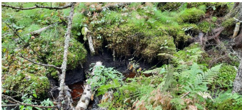
Figur 21 Sørlig kant av bekkeløpet, mellom punkt 8 og 9. Her er det en del utvasking, men ingen tegn til leire. Bilde tatt mot sør.
