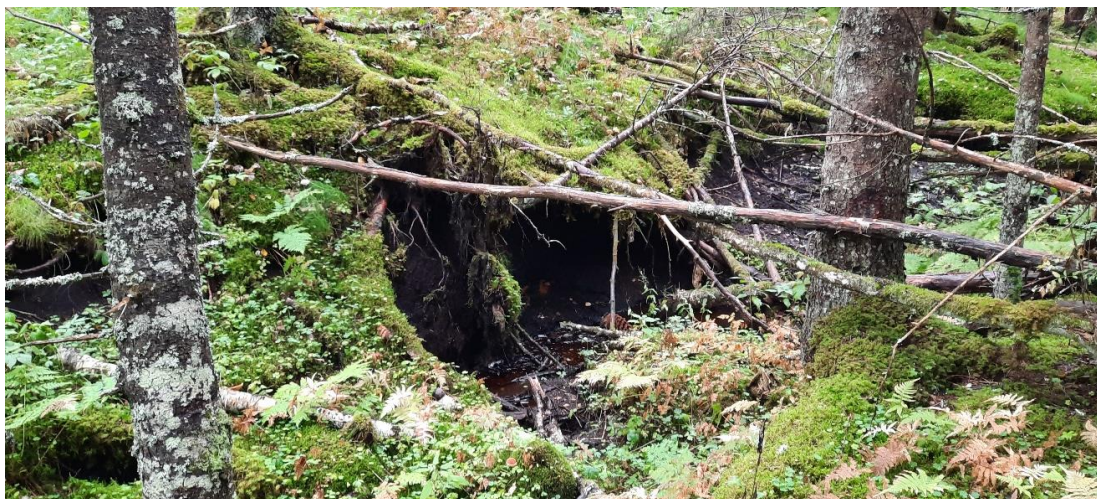
Figur 20 Siden av bekkeløpet er utvasket i partiet rundt punkt 8. Bildet er tatt mot vest.
