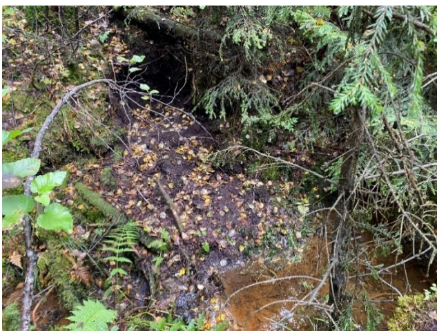
Figur 4 Sidekantene på bekken i nordre bekkeløp er svært bløte/våte og stedvis sklir massene ut i bekkeløpet. Bildet er tatt rett nedenfor bildet i Figur 3.
