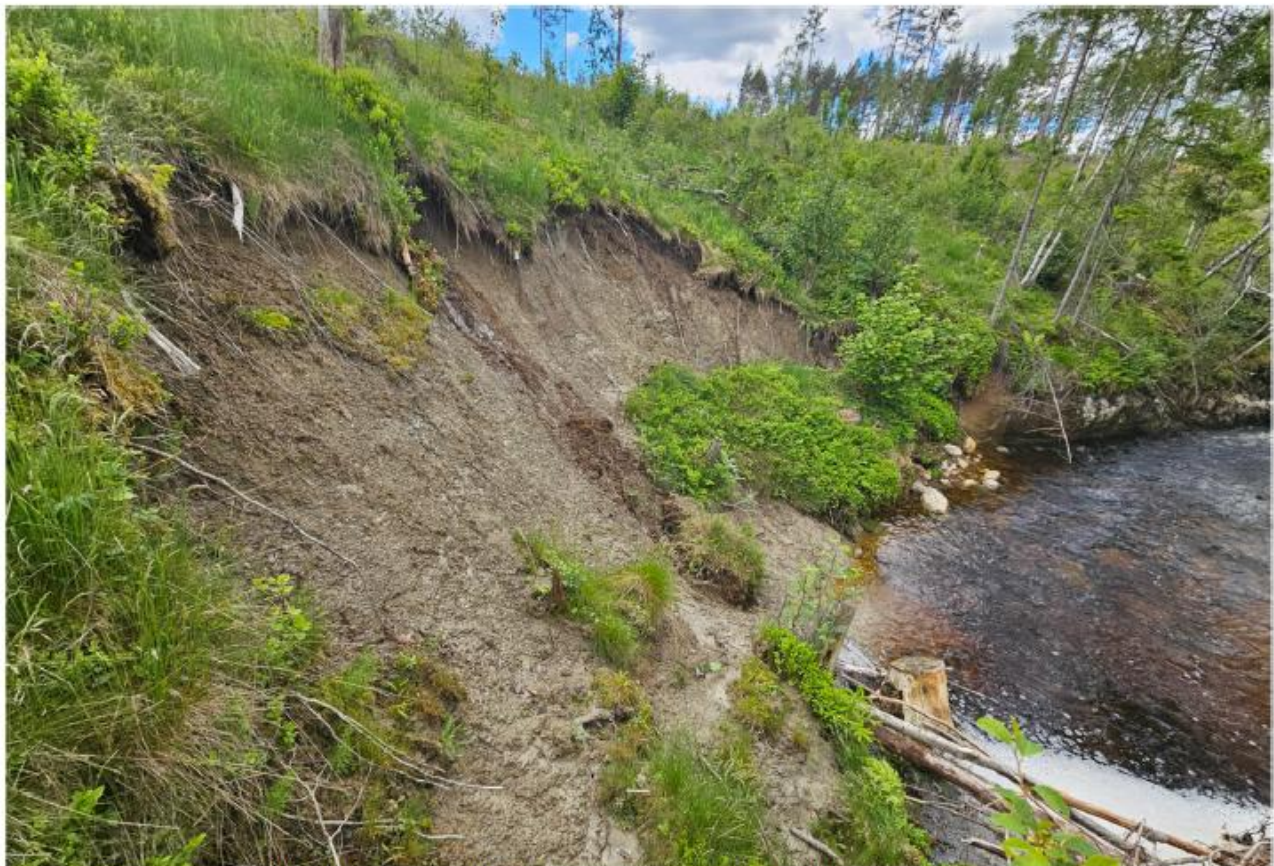
Skråning ned mot Nukebekken i det nordøstre hjørnet av planområdet. Det er berg i dagen ved bekkebredden.
