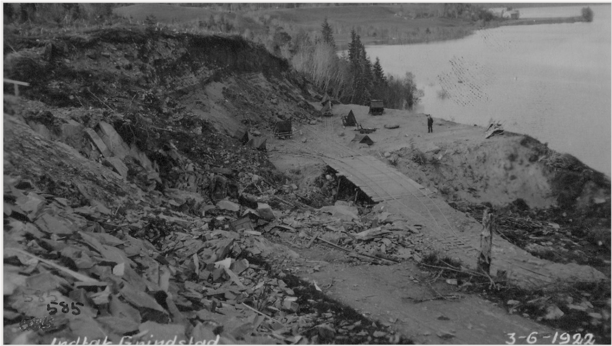
Figur 10. Inntaksområdet sett mot nordøst. 1922. Kilde: Statkraft
