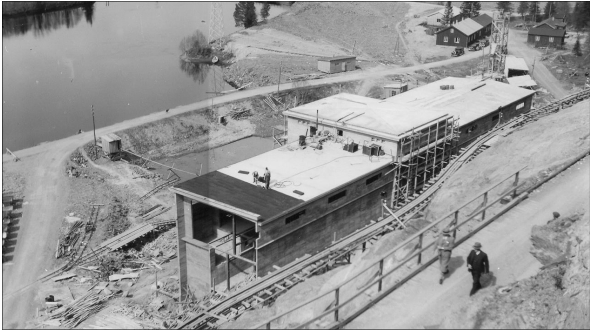
Figur 6. Svean kraftverk under bygging. Kilde: Statkraft
