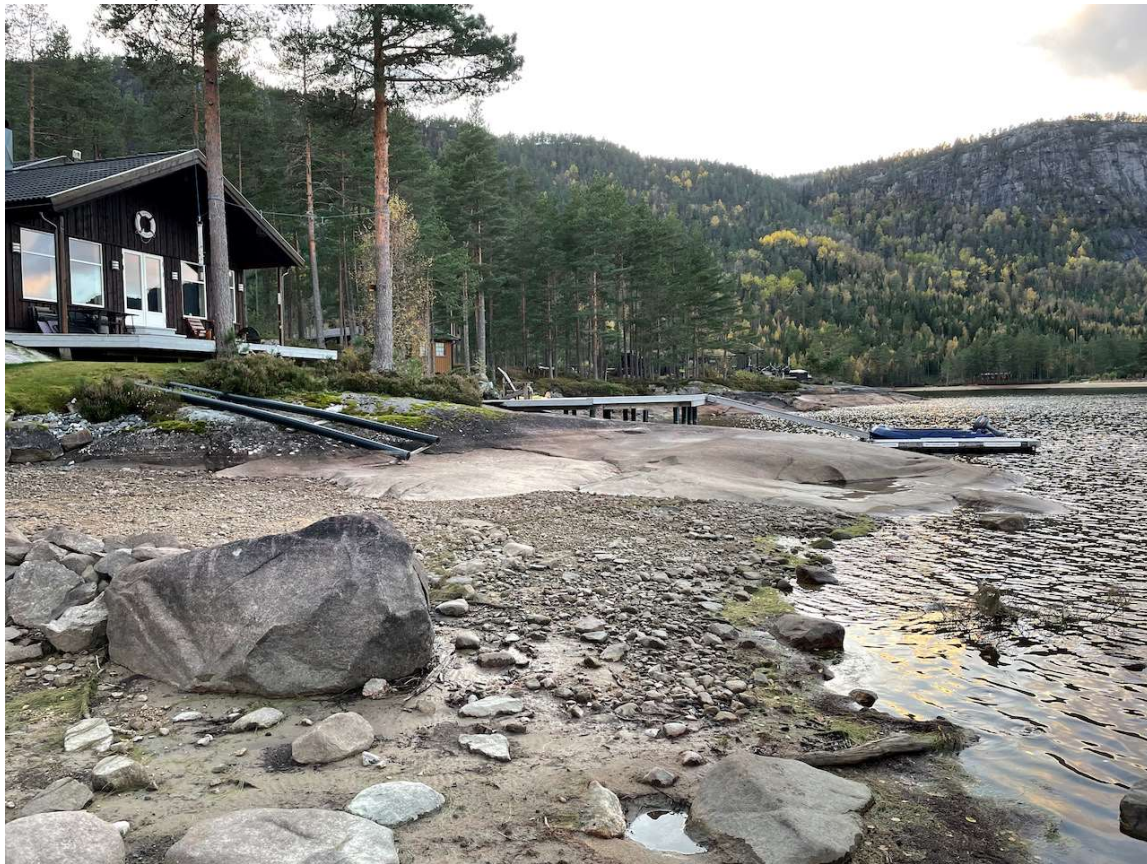
Fra kulvert over fra land, sett mot NV:
