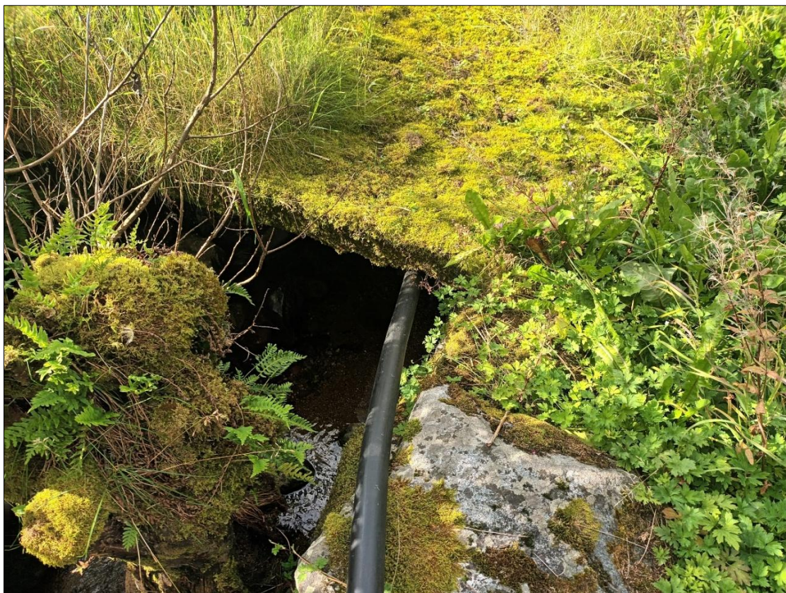
Figur 11: Lysåpningen til broen B2 sett fra oppstrøms side.
