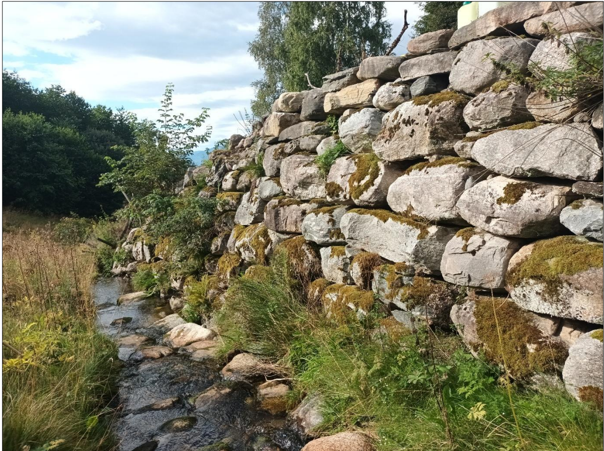
Figur 23: Eksisterende sikringsmur langs redskapshuset like oppstrøms for det kartlagte området.
