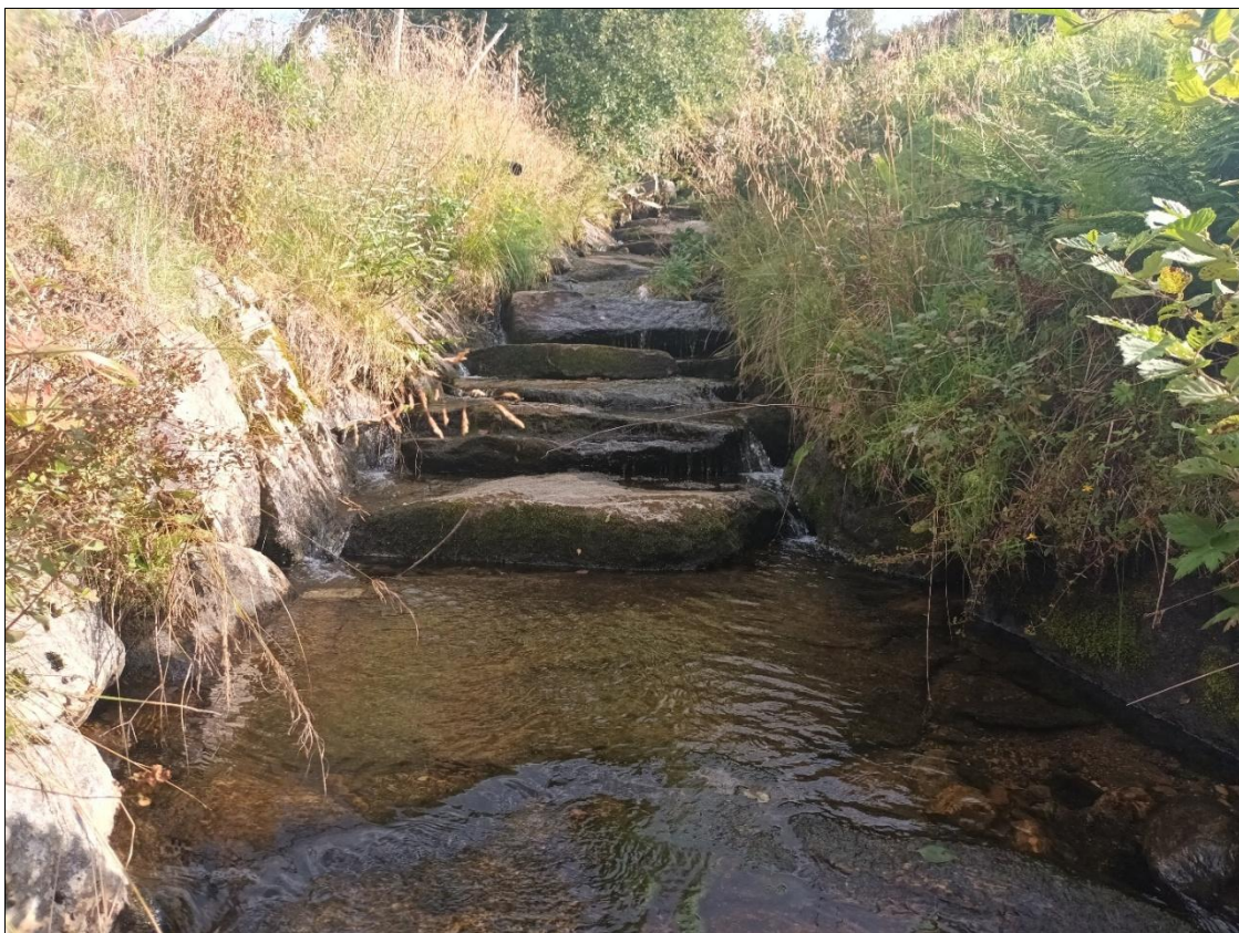
Figur 22: Plastret bunn som er inntakt og fri for blokader på tidspunktet for befaringen.
