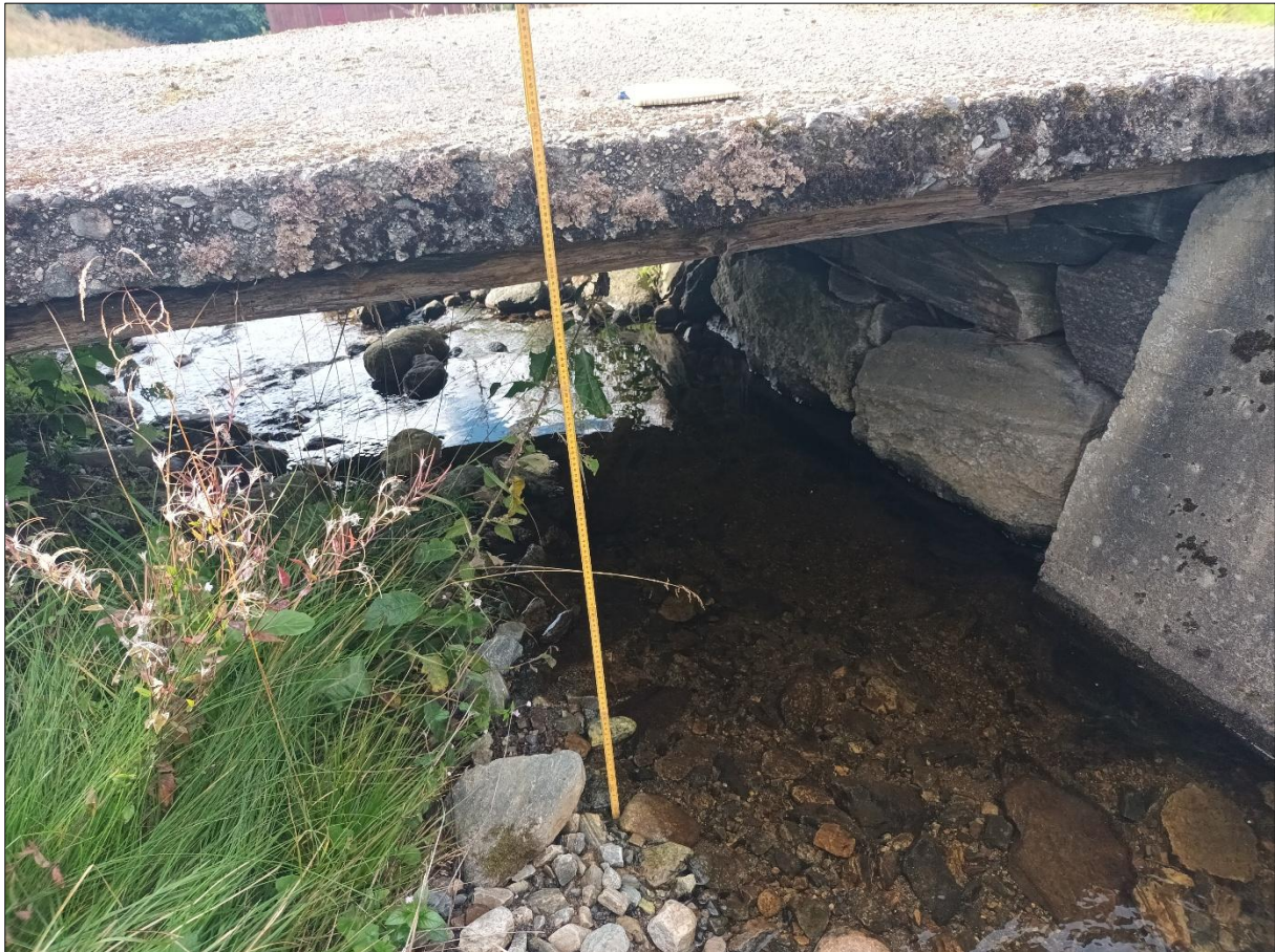
Figur 10: Lysåpningen til broen B3 sett fra oppstrøms side.
