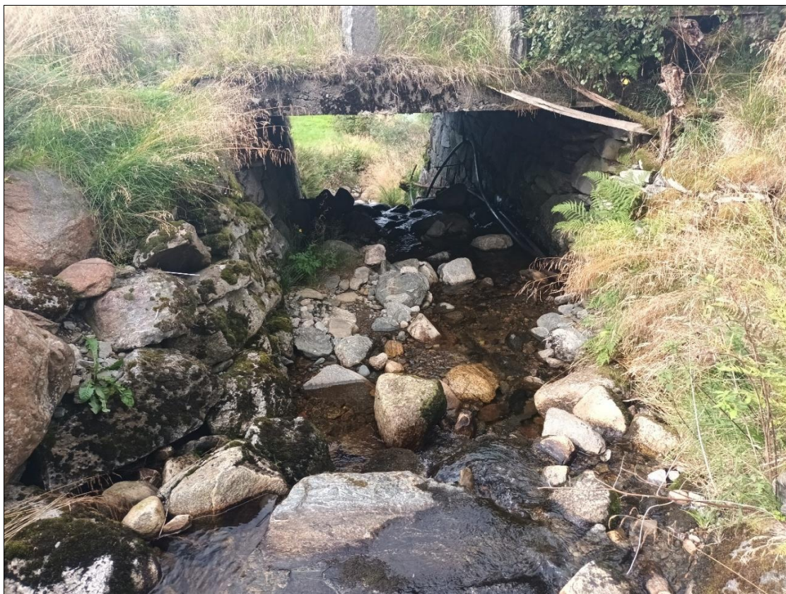
Figur 12: Lysåpningen til broen B1 sett fra oppstrøms side.
