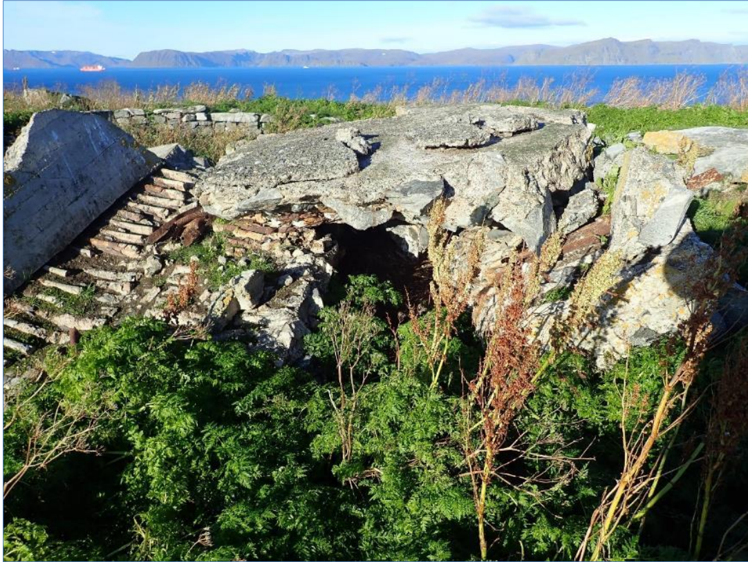
Figur 5-39. Bakkant av kanonstilling 3 (nr.6). Foto: NIKU 2020
