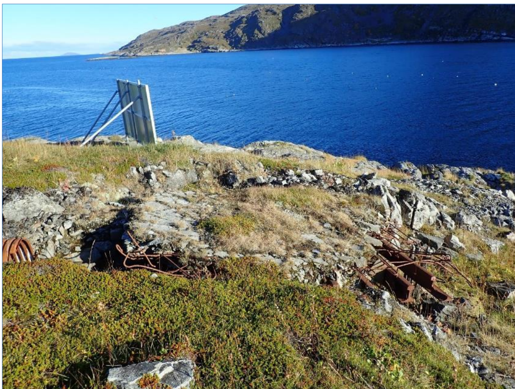
Melkøyneiset. En naturlig sprekk i berget er benyttet til en våpenstilling. Ødelagt armert betongplate til høyre. Utsikt mot Melkøysundet og Kvaløya.
