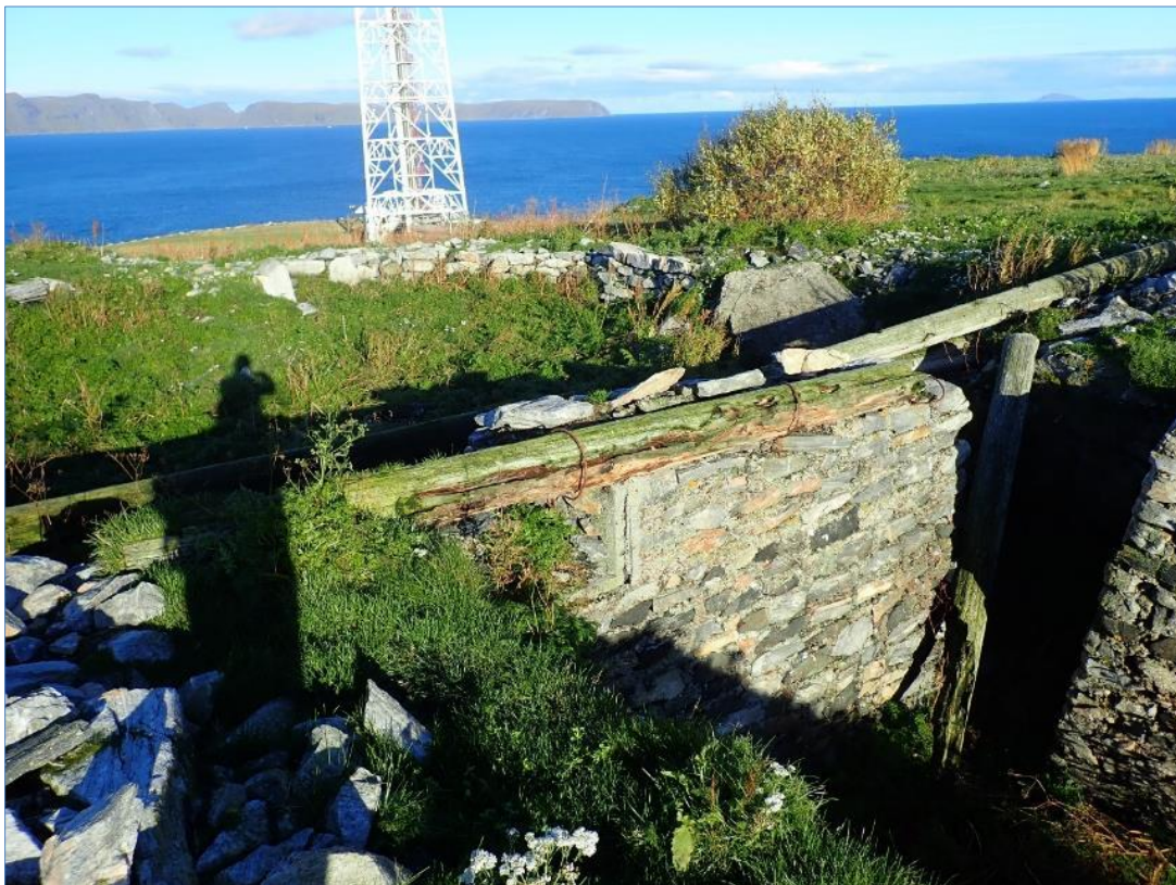
Kanonstilling 4. Mur mellom stillingen og dekningsrom. Tømmerstokkene her er i praksis det eneste trevirket som er igjen i stillingene.
