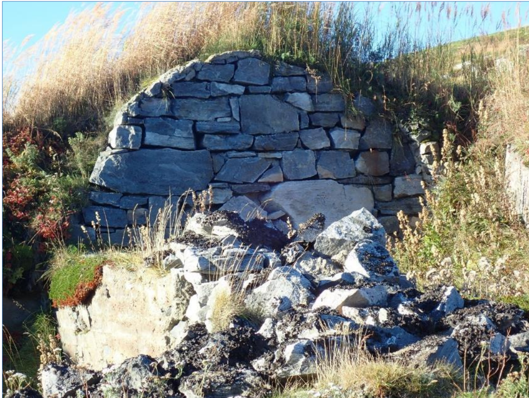
Melkøyneiset. Bygningsrester. Sannsynligvis rester etter en vaktbu. Sørveggen er av tørrmur og formen på bygget må ha vært som en Nissenbrakke med avrundet tak.
