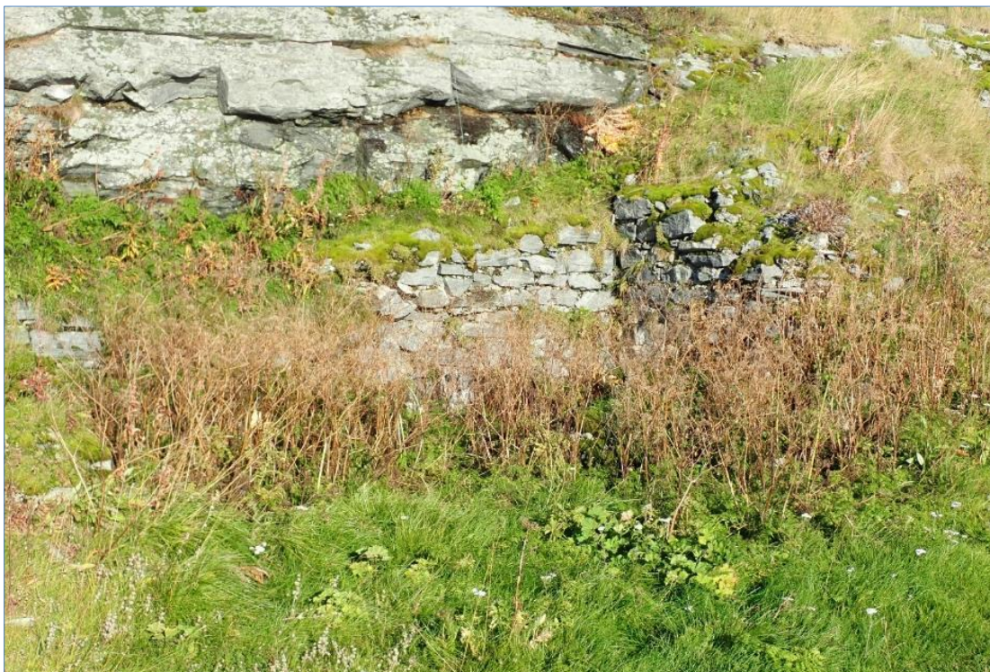
Midt mellom tunell-inngangene har det stått en bygning. Tørrmur mot berget utgjør bakvegg, til høyre nordre endevegg. Muligens rester etter et lagerbygg. Foto: NIKU 2020.
