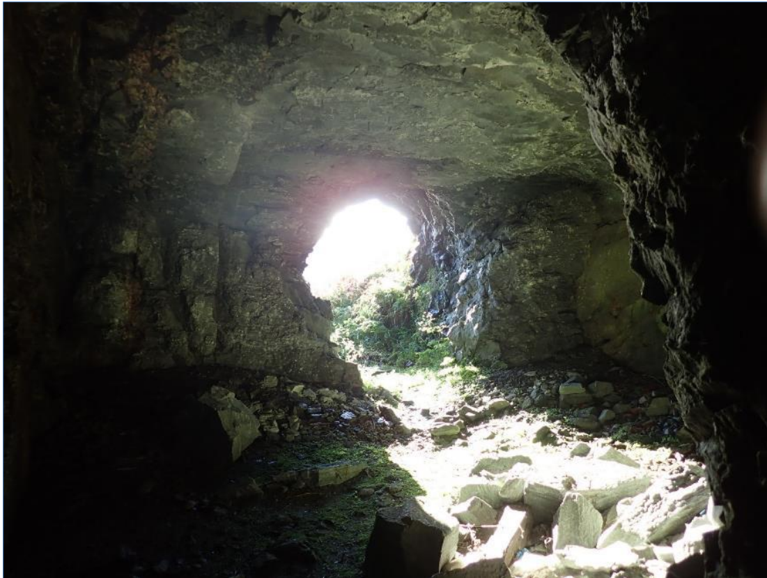
Figur 5-36. Inngangsparti ved søndre tunellingang (nr.3). Foto: NIKU 2020
