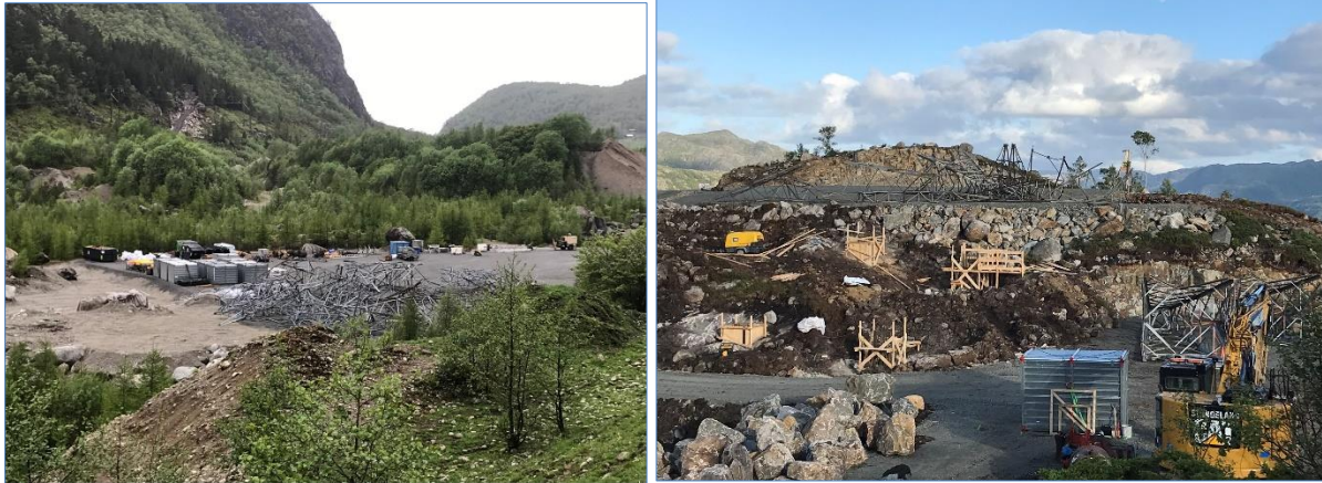
Figur 3-7. Illustrasjon baseområde for premontering master (til venstre). Forskalingsstøping mastefundament (til høyre). Kilde: Equinor 2020.
