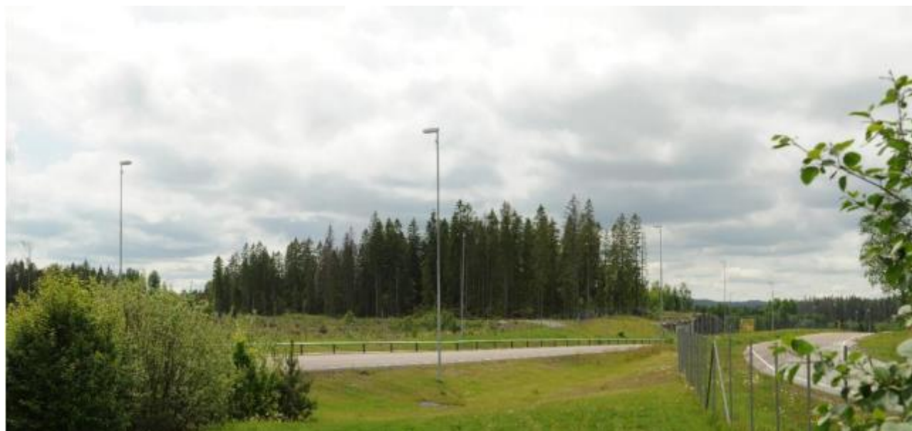
Figur 22: Førbilde av planområdet for solkraftverket, sett fra restplassen som ligger på motsatt side av E18.
