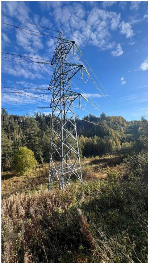
Figur 1-6: Eksempler på bilder av fagverksmaster. (Foto: Glitre Nett).
